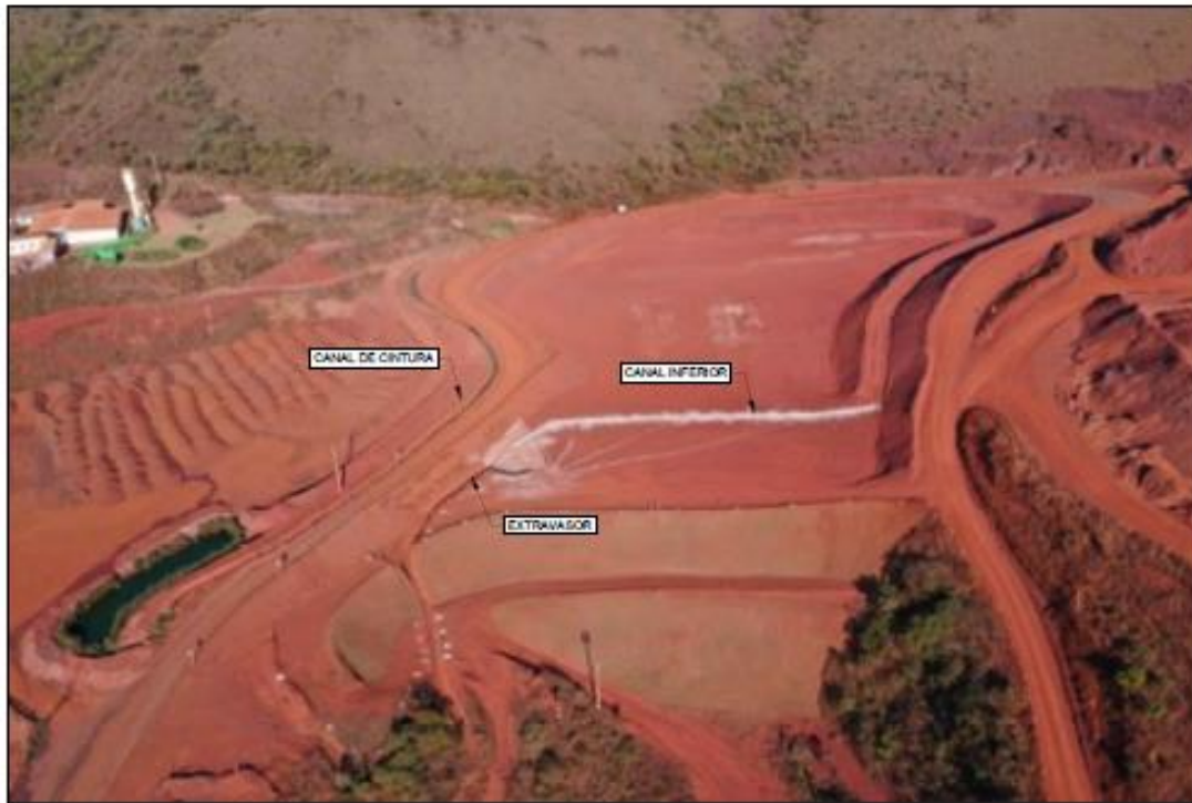
Figura 5.9 – Barragem Grotta – Sistema drenagem
