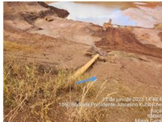
Figura 4-6: Tubo de água proveniente da estrada ITA-320 sentido SAFM .
