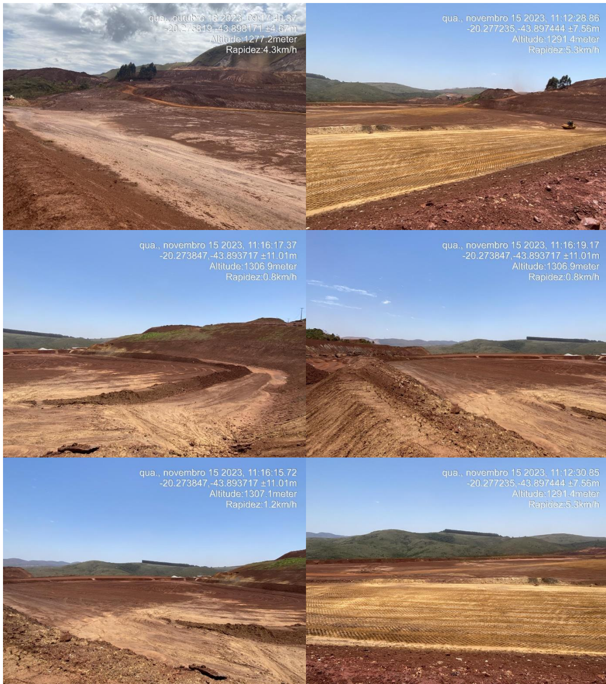
Figura 6-26: Fotografias do reservatório da Barragem Aredes.
