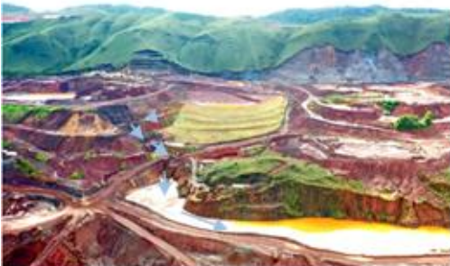
Figura 4-9: Sistema de drenagem partindo da barragem central até o sump que converge para a cava sul.
