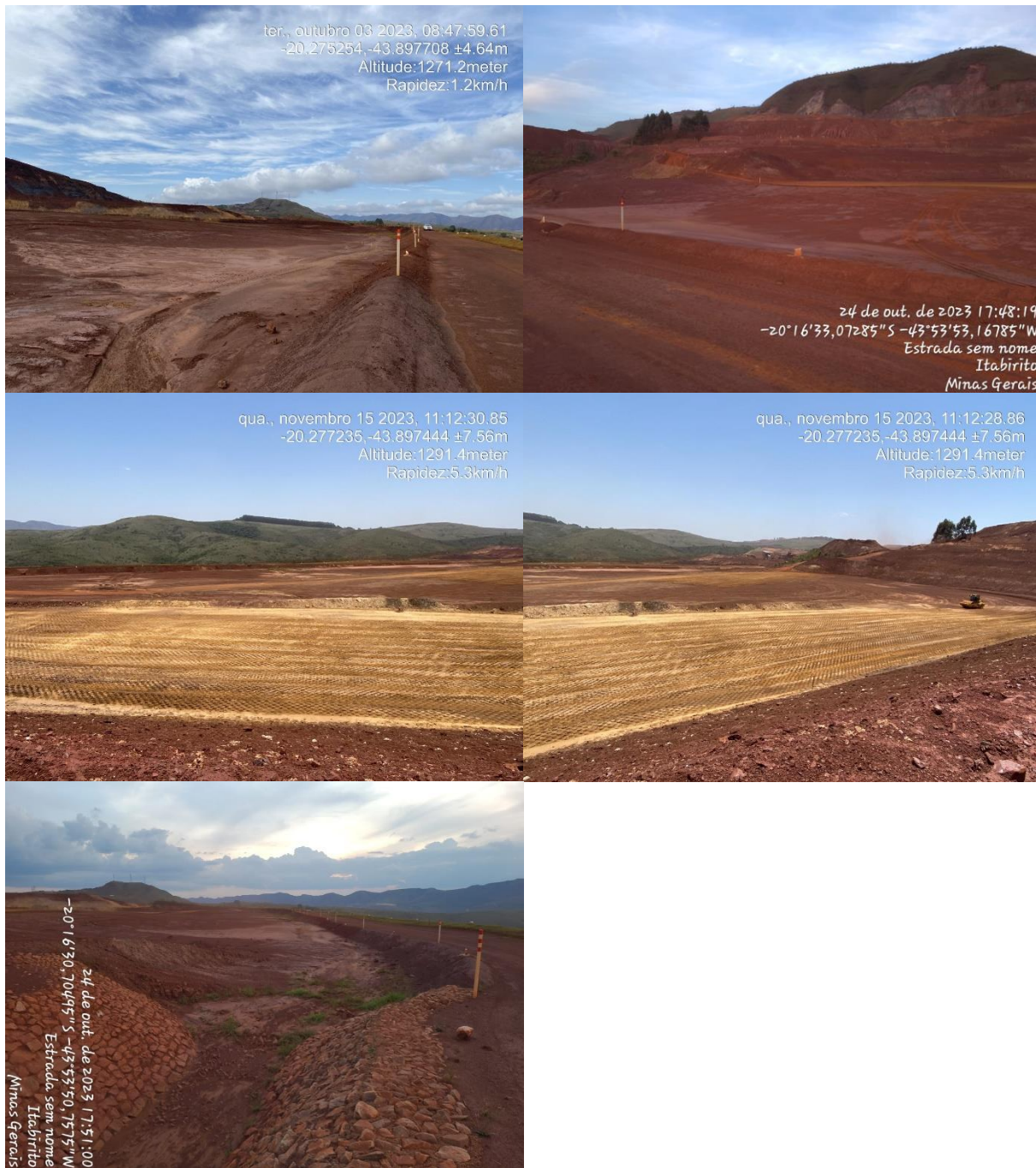
Figura 6-25: Reservatório da Barragem Aredes.
