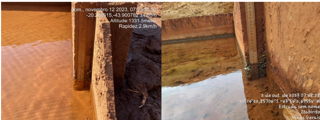
Figura 6-9: Implantação da escada de descida de água
