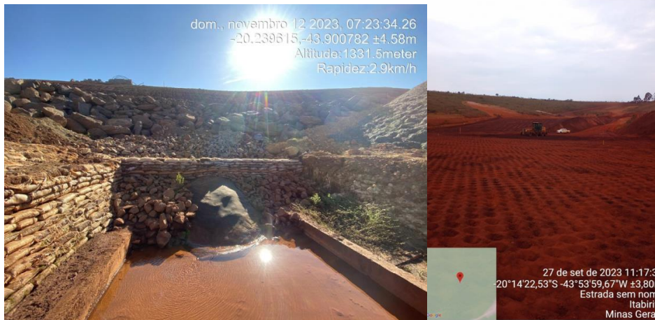
Figura 6-8: Pilha Noroeste – inspeção diária
