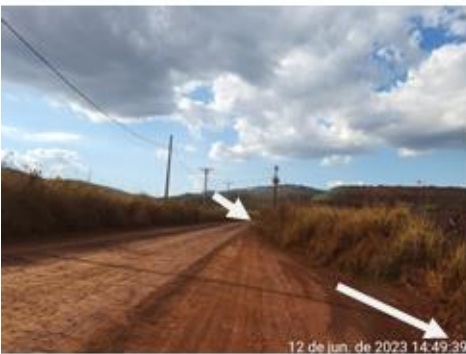
Figura 4-10: ITA – 320 em ótimo estado de conservação
