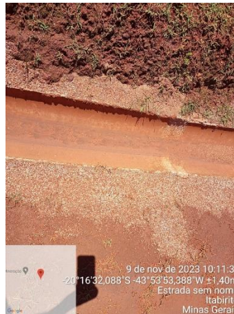
Figura 6-1: Canaletas recolocadas
