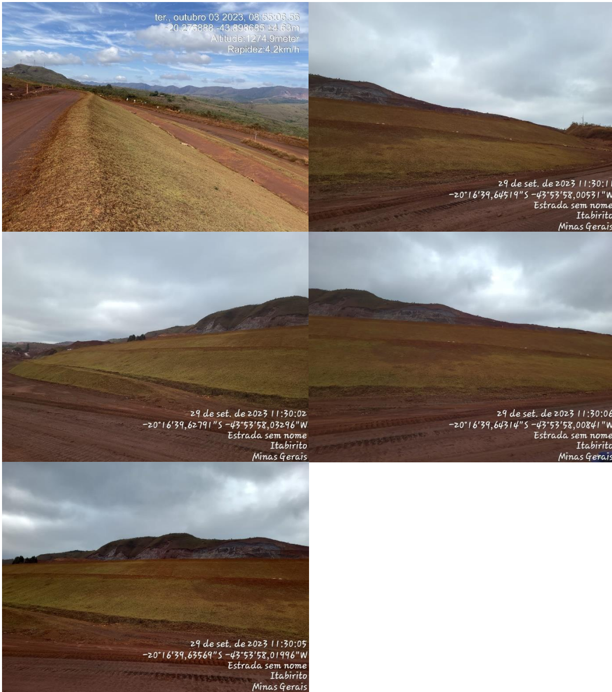
Figura 6-27: maciço da Barragem Aredes durante o período referente a este trimestre
