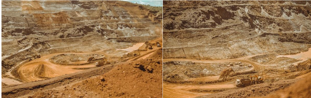
Figura 6-31: Cava sul. Sump para onde a água da barragem Aredes é desviada.
