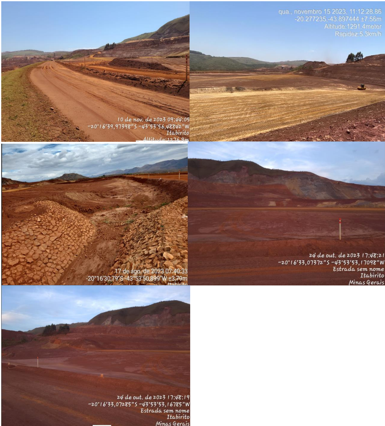
Figura 6-32: Reservatório da barragem Aredes no trimestre
