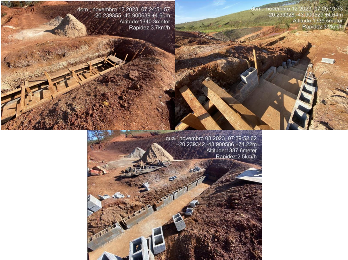
Figura 6-9: Implantação da escada de descida de água
