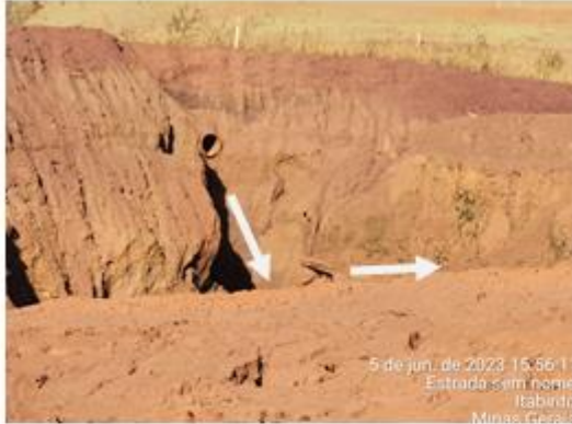
Figura 4-2: Bueiro próximo a barragem Central para vertimento de água pluvial de montante para a cava do dique
