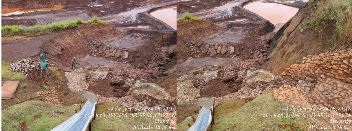
Figura 4: Desemboque do sistema extravasor da Barragem Aredes.
