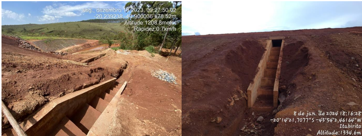
Figura 6-10: Implantação e finalização da escada de descida de água
