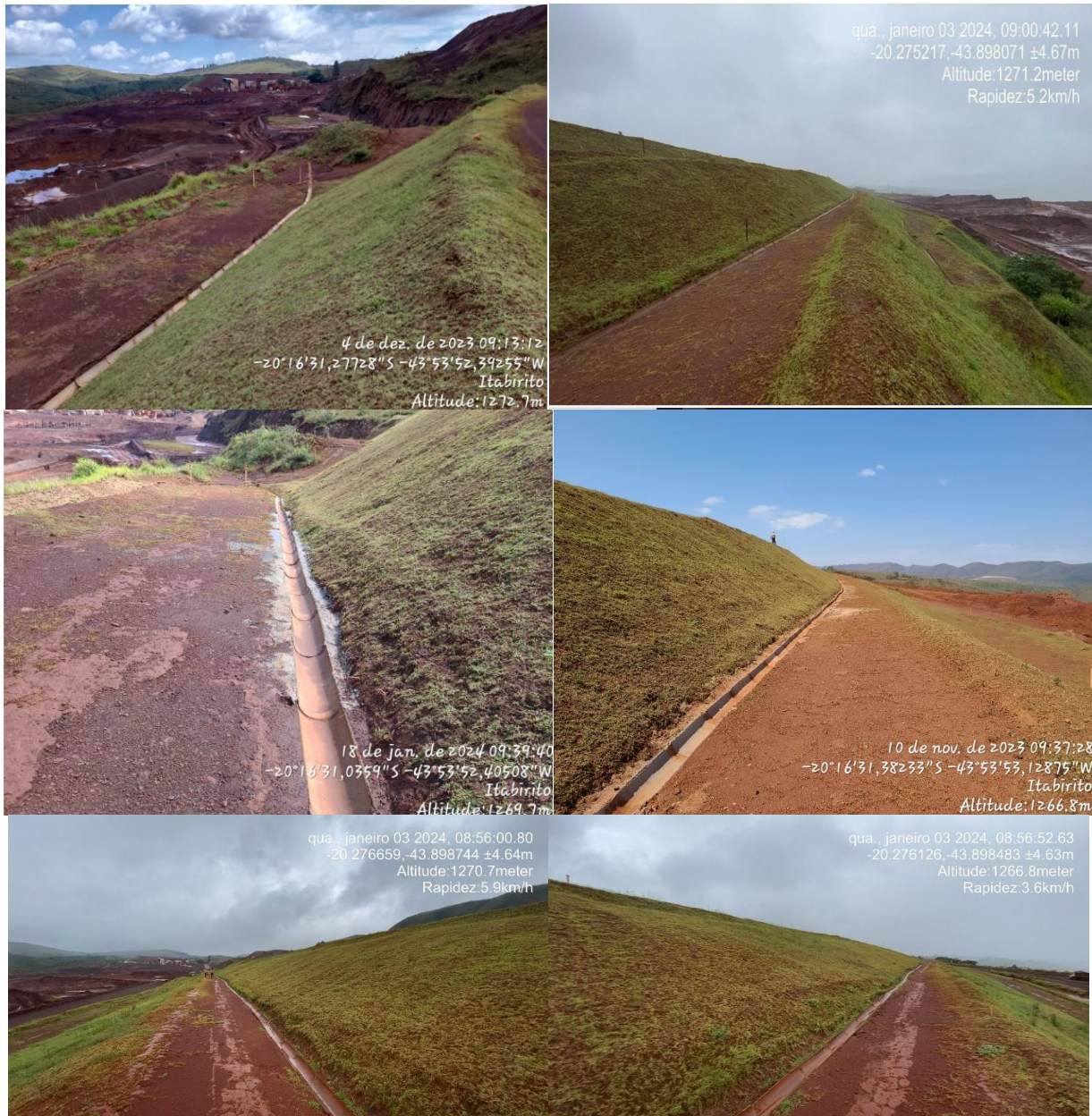
Figura 6-44: Canaletas na Barragem Aredes
