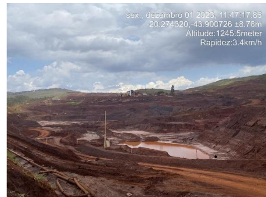
Figura 6-37: Água pluvial sendo drenada da cava do dique para aspersão de vias internas SAFM
