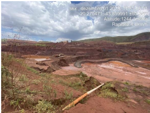
Figura 6-38: Fundo da cava do dique.
