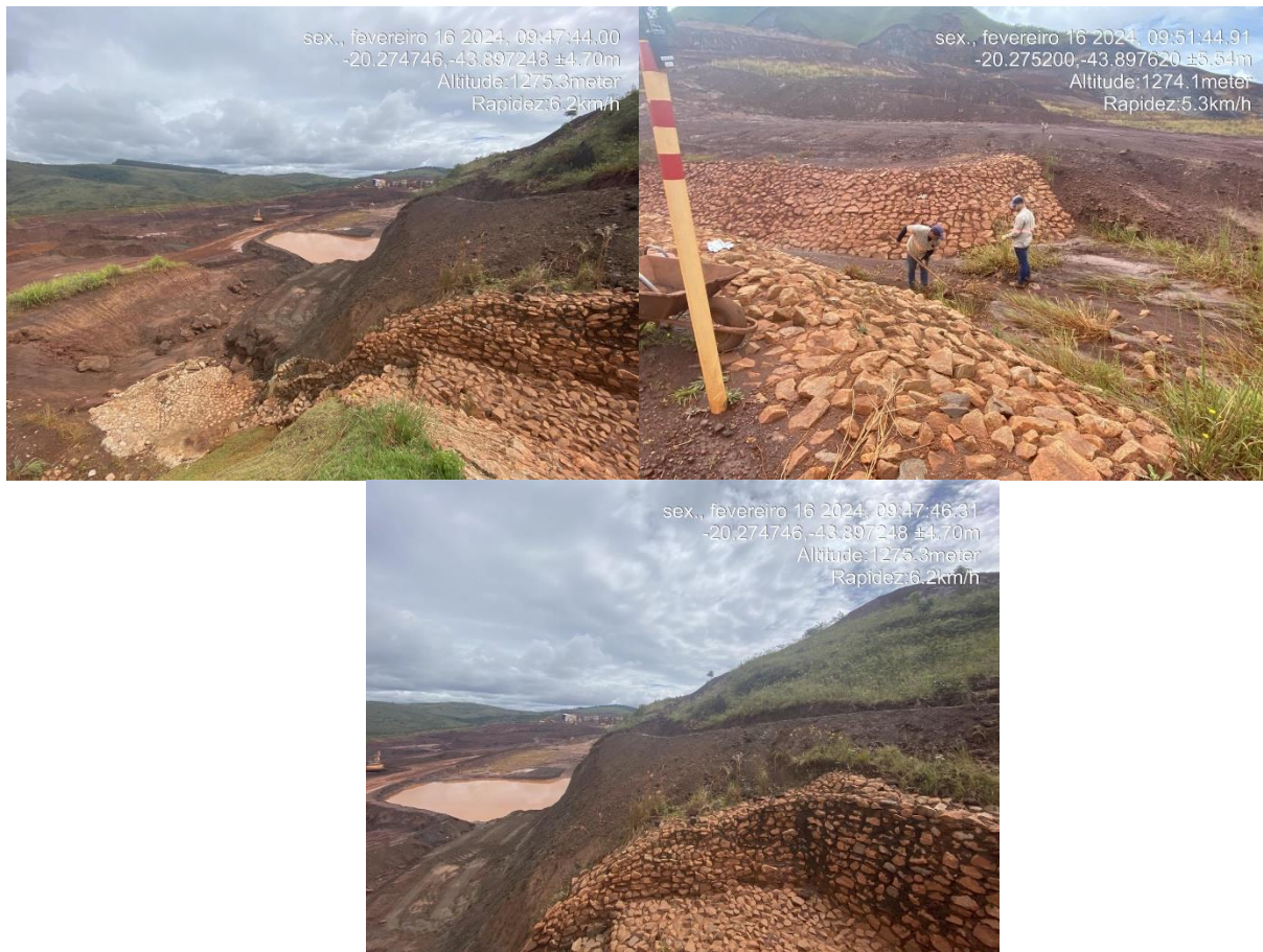
Figura 6-42: Reservatório e extravasor principal da barragem Aredes no trimestre
