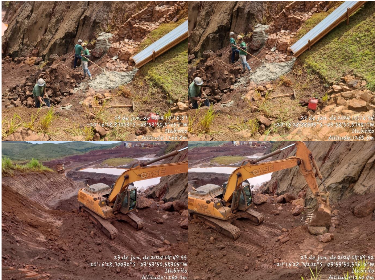
Figura 4: Desemboque do sistema extravasor da Barragem Aredes.
