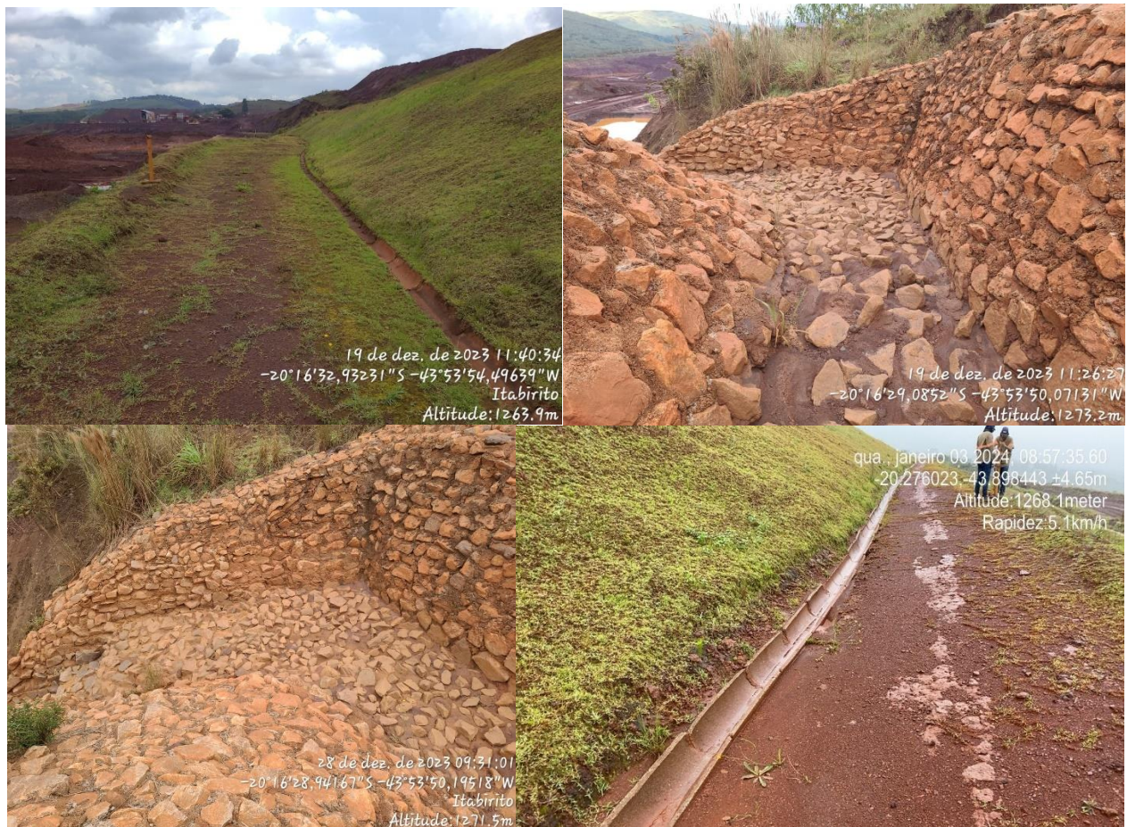
Figura 6-26: Fotografias do reservatório da Barragem Aredes.
