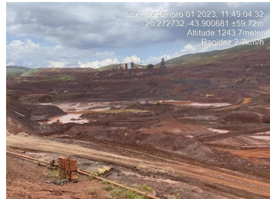
Figura 6-39: Fundo da cava do dique
