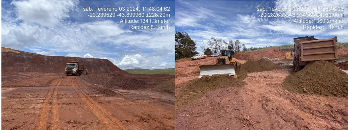
Figura 6-14: Espalhamento, compactação, teste de hilf e proctor e acompanhamento diário da estrutura referente a este relatório
