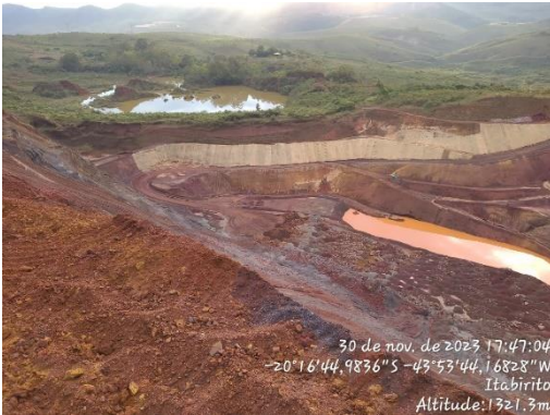
Figura 6-33: Água pluvial no fundo cava sul. Estas serão utilizadas para aspersão de poeira interna.
