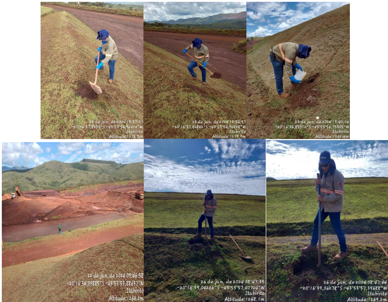
Figura 6-45: Manutenção do sistema de drenagem da barragem Aredes
