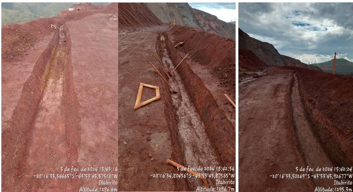
Figura 6-27: Canaleta de off set. Utilização de gabaritos para aderência total ao projeto de descaracterização.
