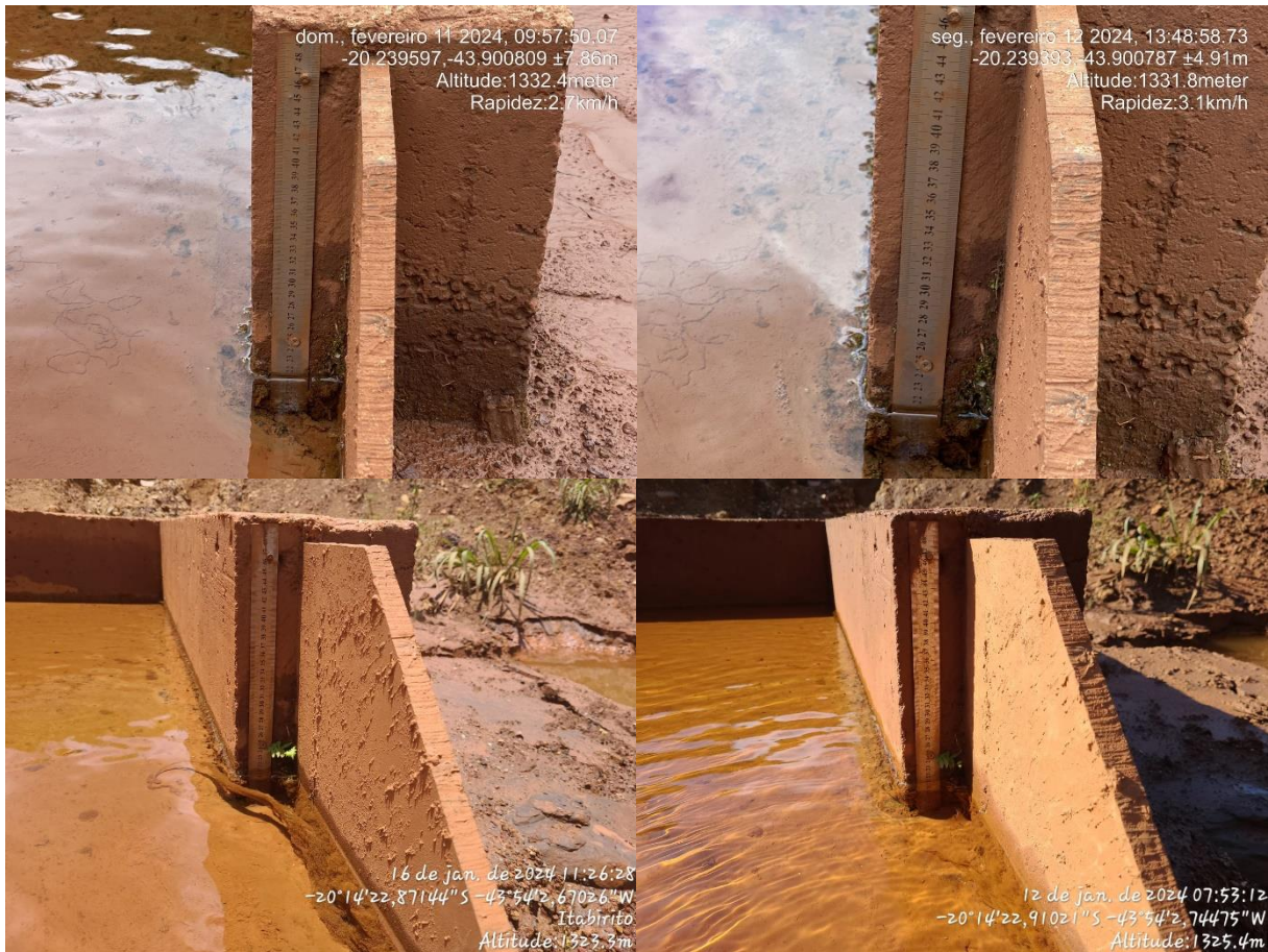
Figura 6-10: Implantação e finalização da escada de descida de água
