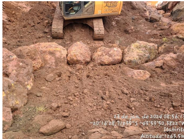
Figura 5: Obras no Desemboque do sistema extravasor
