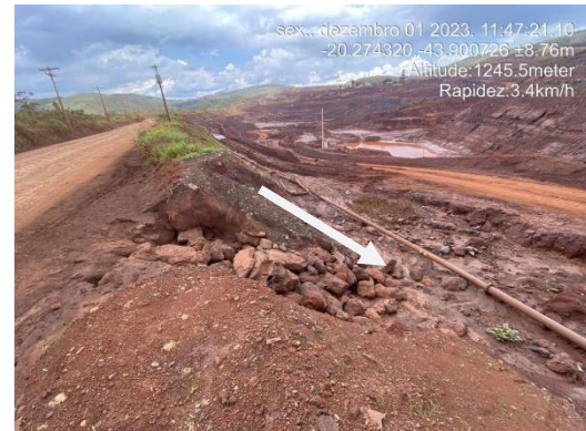
Figura 6-36: Encanamentos com direcionamento da água proveniente da ITA-320 para a cava do dique.
