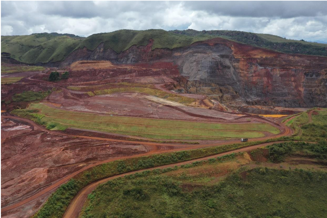
Figura 6-19: Situação atual da estrutura. 16/02/2024
