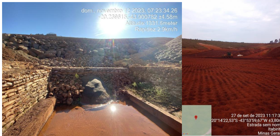
Figura 6-7: Pilha Noroeste – inspeção diária
