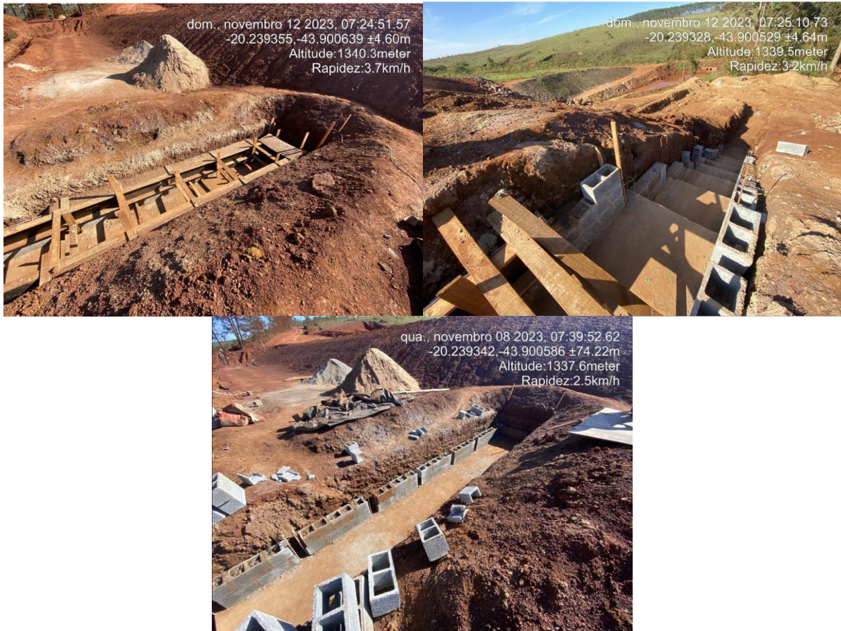
Figura 6-8: Implantação da escada de descida de água
