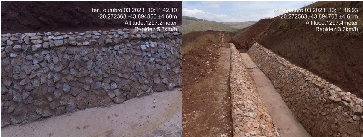
Figura 6-24: Construção do extravasor temporário em pedra argamassada em período seco.
