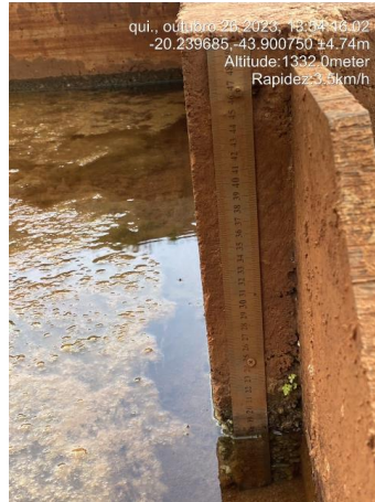
Figura 6-9: Monitoramento da vazão da drenagem interna da pilha noroeste
