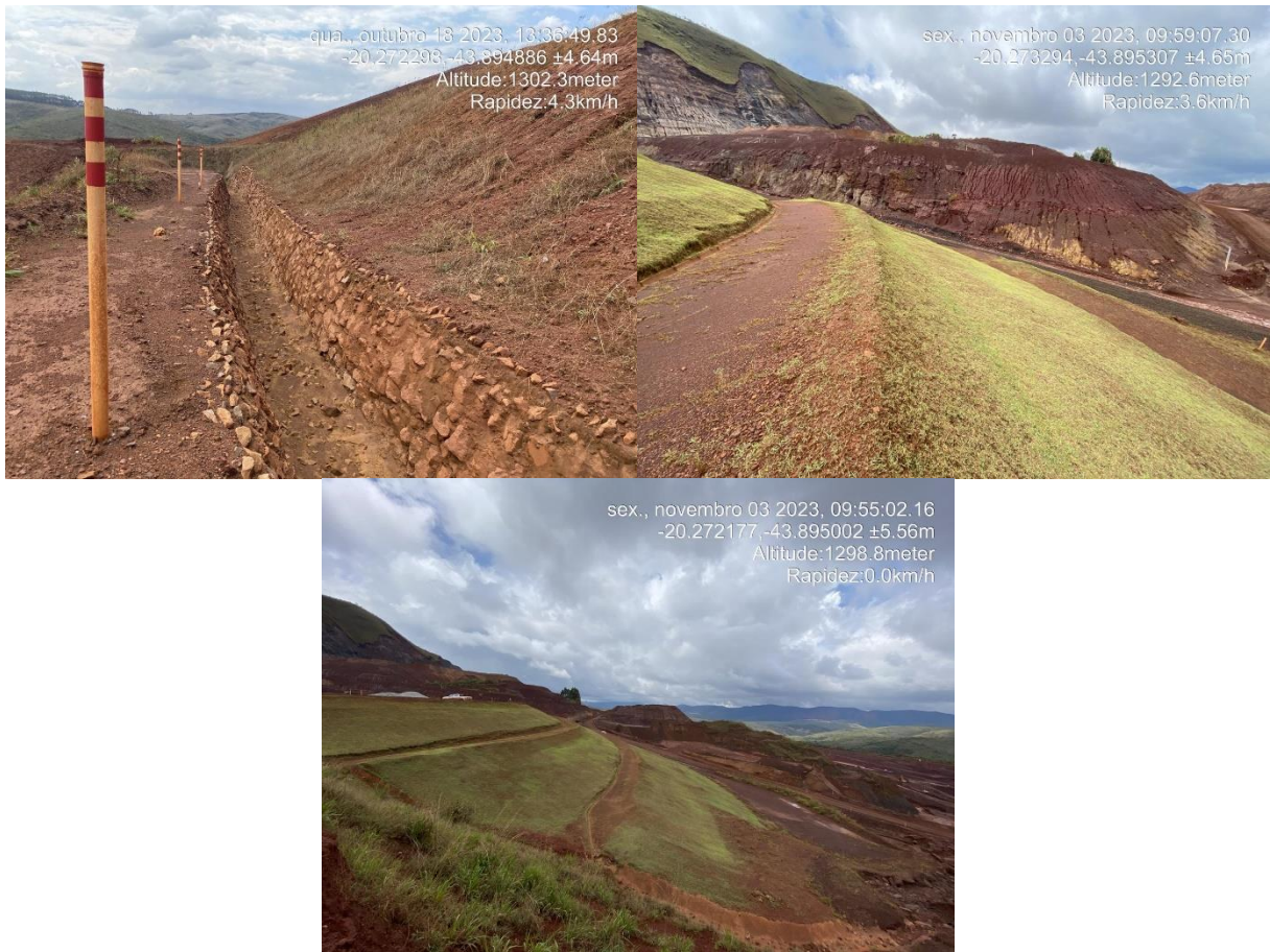
Figura 6-28: Barragem Central – condições do maciço e drenagem
