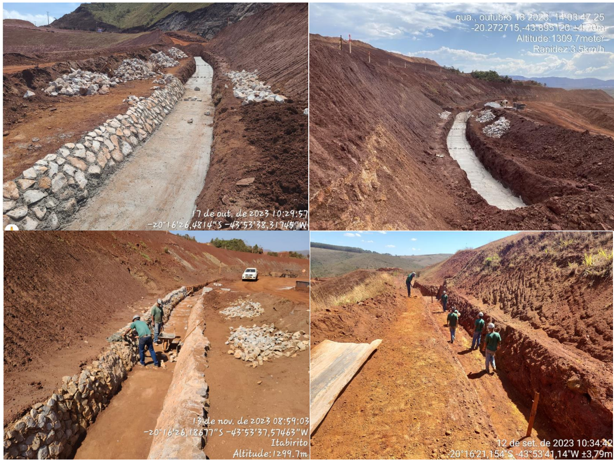
Figura 6-26: Extensão do canal de cintura existente.
