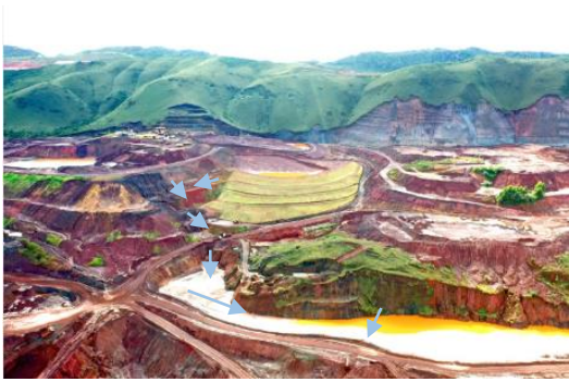
Figura 6-44: Sistema de drenagem partindo da barragem central até o sump que converge para a cava sul.
