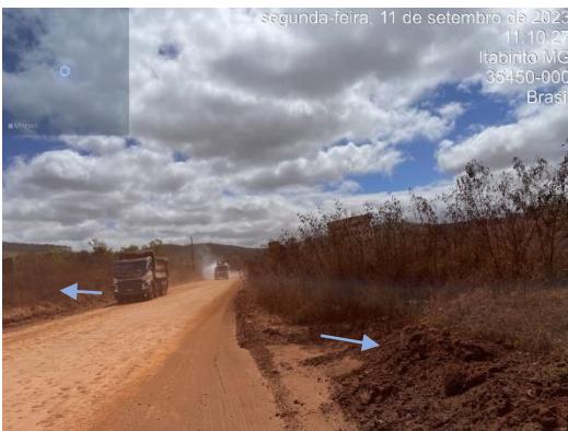
Figura 6-46: ITA-320 em boas condições
