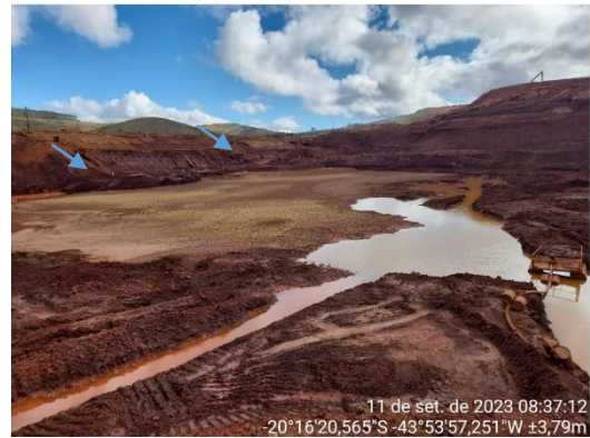
Figura 6-49: Fluxo de água pluvial sendo direcionada a partir da ITA-320 para a cava do dique.
