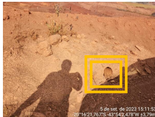
Figura 6-43: Encanamento direcionando o fluxo de água da estrada para a parte interna da SAFM Mineração.
