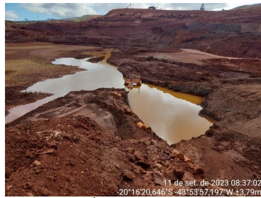
Figura 6-42: Água pluvial sendo drenada da cava do dique para aspersão de vias internas SAFM
