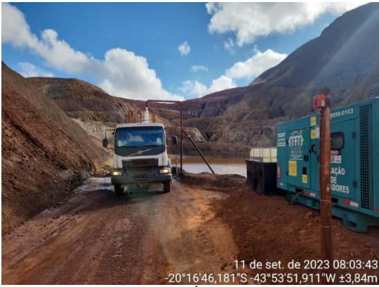
Figura 6-38: Cava sul. Água pluvial sendo retirada do fundo da cava para aspersão de poeira interna.
