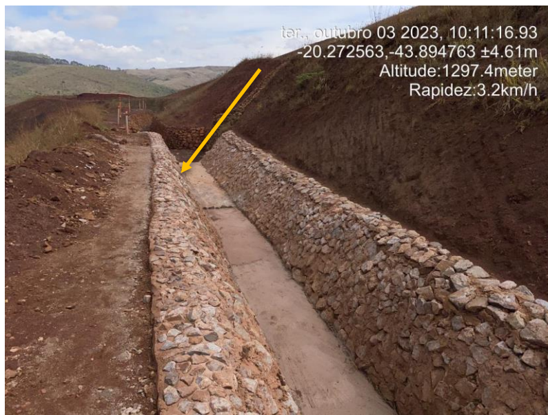
Figura 6-25: Conexão do extravasor existente com o construído (seta alaranjada)
