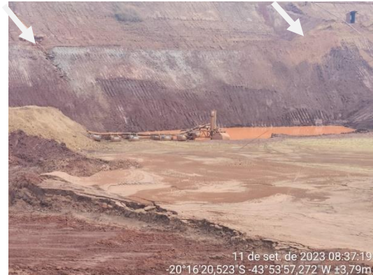
Figura 6-41: Encanamentos com direcionamento da água proveniente da ITA-320 para a cava do dique.
