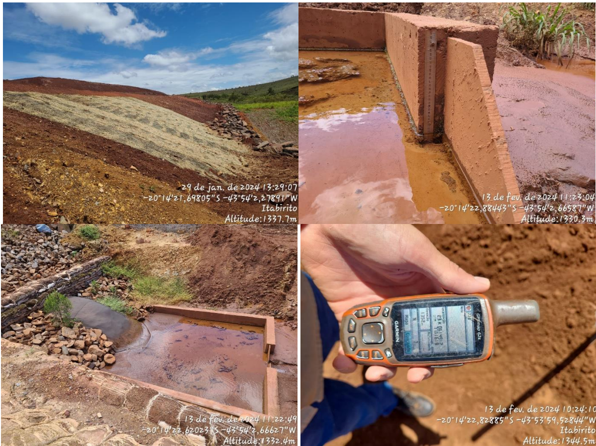
Figura 6-9: Pilha Noroeste – inspeção diária
