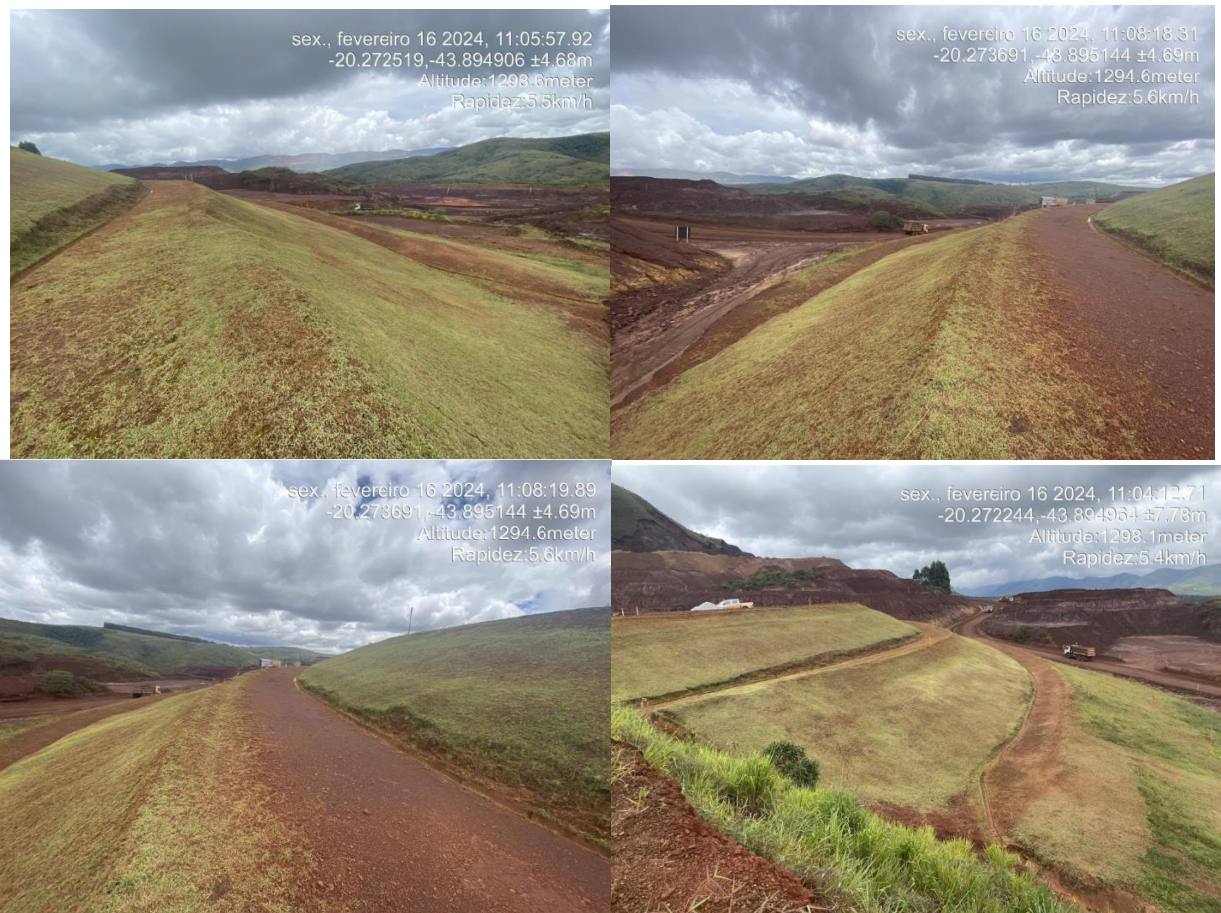
Figura 6-19: Situação atual da estrutura. 15/02/2024
