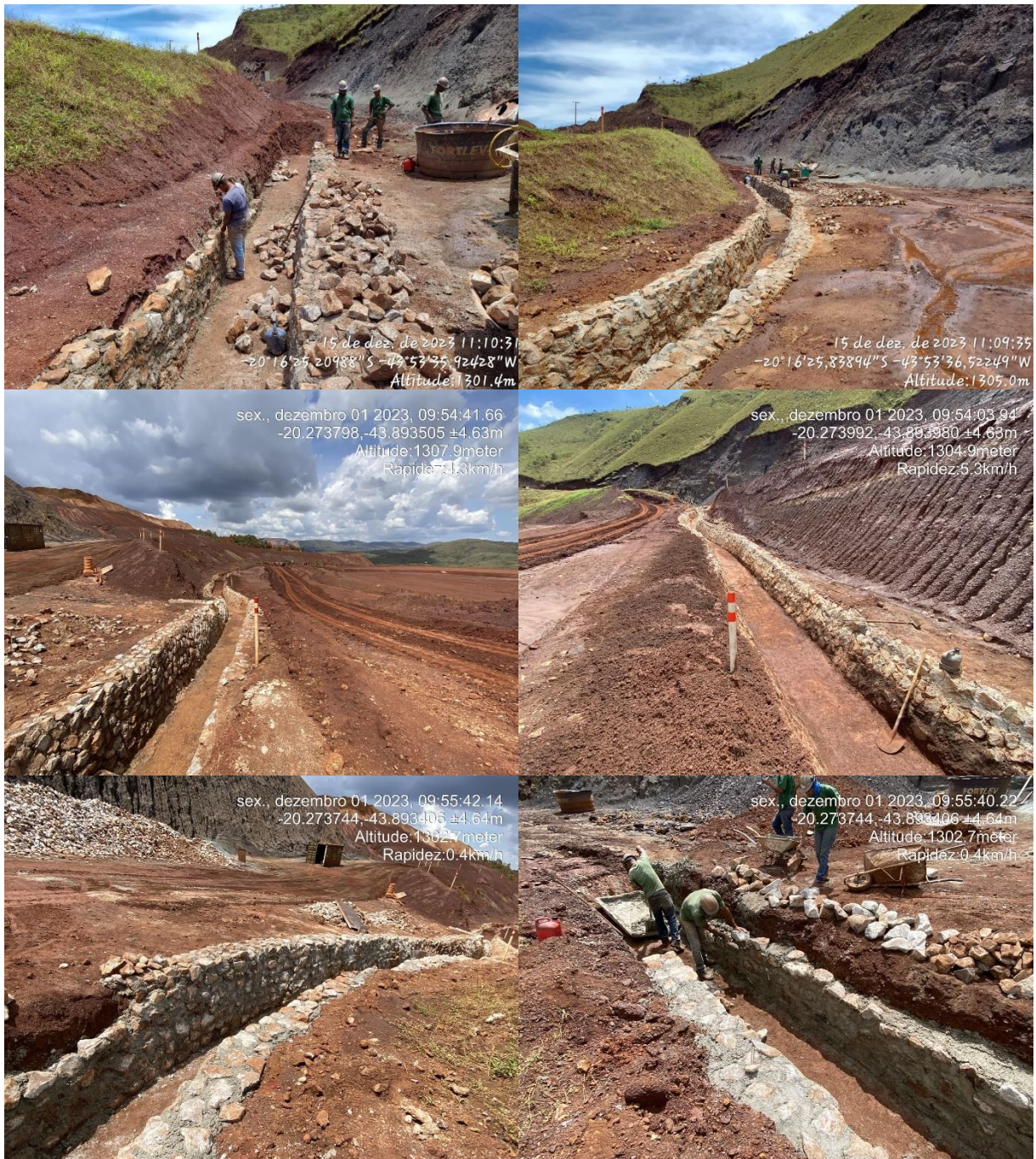
Figura 6-25: Extensão do canal de cintura.
