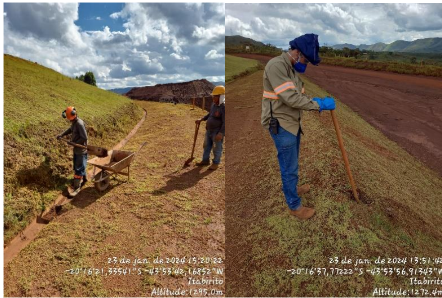
Figura 5-5: algumas das manutenções realizadas na Barragem Central neste trimestre.
