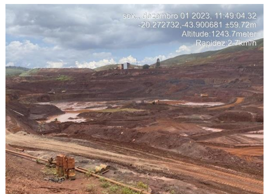
Figura 6-39: Fundo da cava do dique
