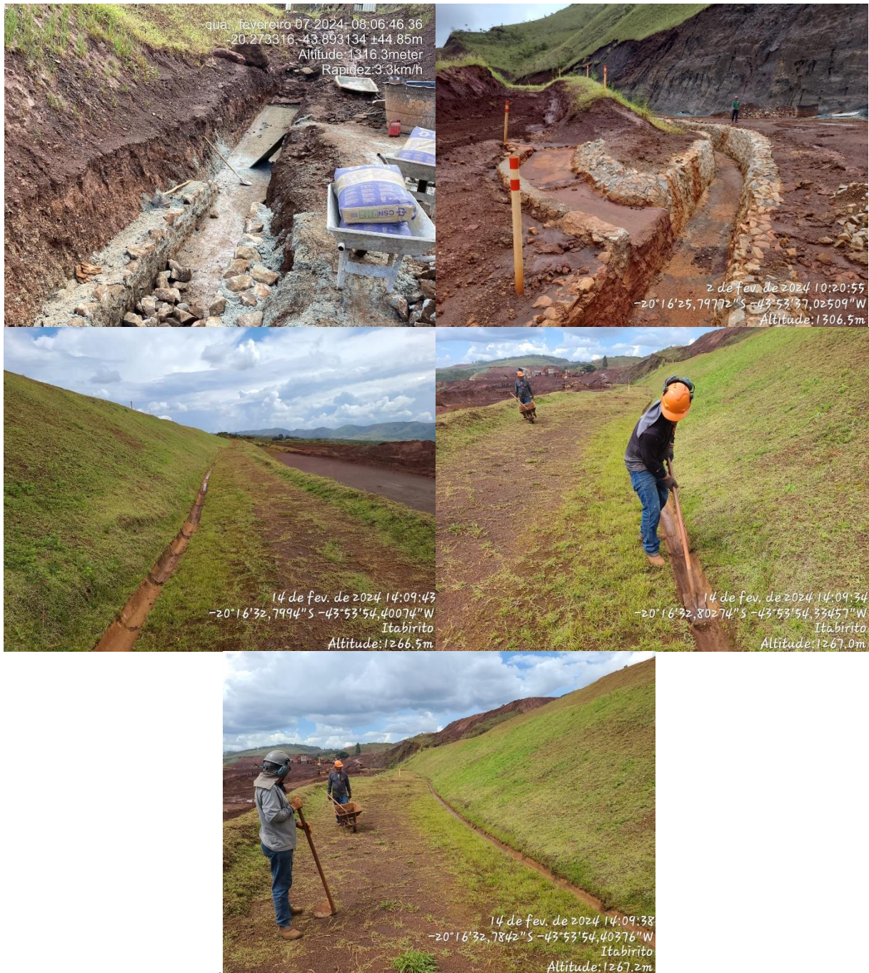
Figura 6-28: Condição no período chuvoso da Barragem Central no trimestre
