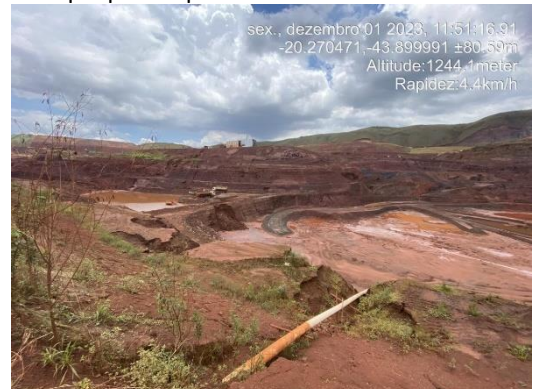
Figura 6-38: Fundo da cava do dique.
