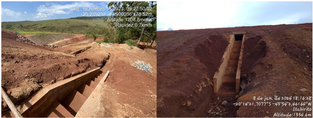
Figura 6-10: Implantação e finalização da escada de descida de água
