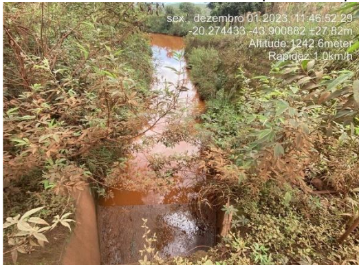
Figura 6-35: Água pluvial desviada da ITA-320 para o sump da SAFM Mineração
