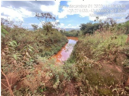
Figura 6-34: água proveniente da ITA-320 que foi desviada da mesma e direcionada para o sump.
