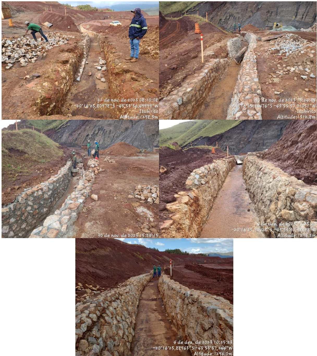
Figura 6-42: Canal de cintura sendo ampliado na barragem grotá.
