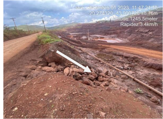
Figura 6-36: Encanamentos com direcionamento da água proveniente da ITA-320 para a cava do dique.
