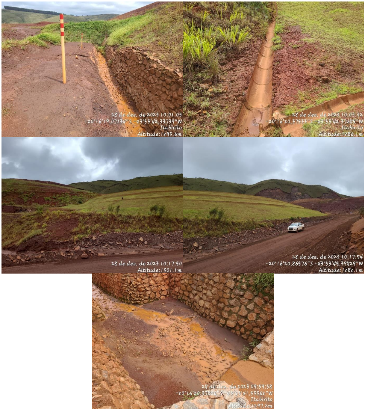
Figura 6-27: Barragem Central – condições do maciço e drenagem
