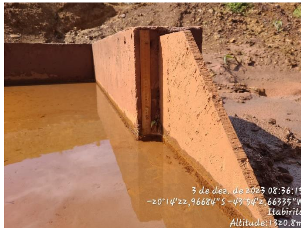
Figura 6-11: Monitoramento da vazão da drenagem interna da pilha noroeste
