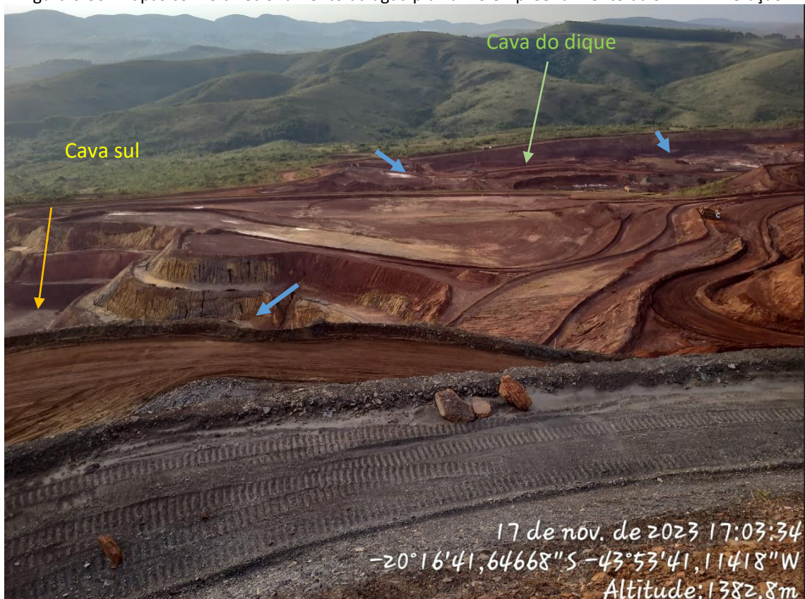
Figura 6-31: Duas cavas para as quais as águas pluviais são direcionadas na mina ponto verde.
