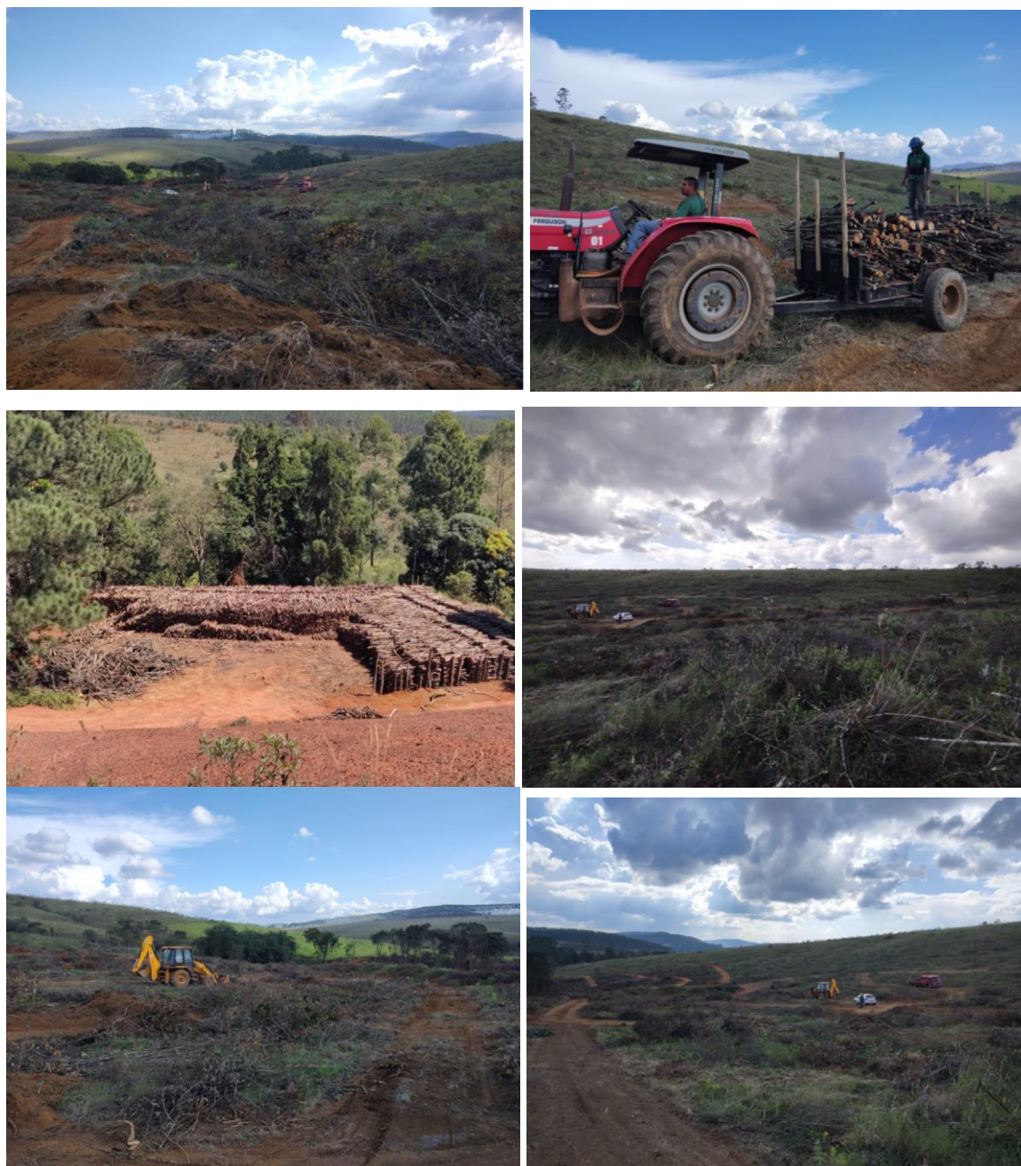
Figura 8-1: Desmate na área onde será construída a futura pilha Noroeste.
