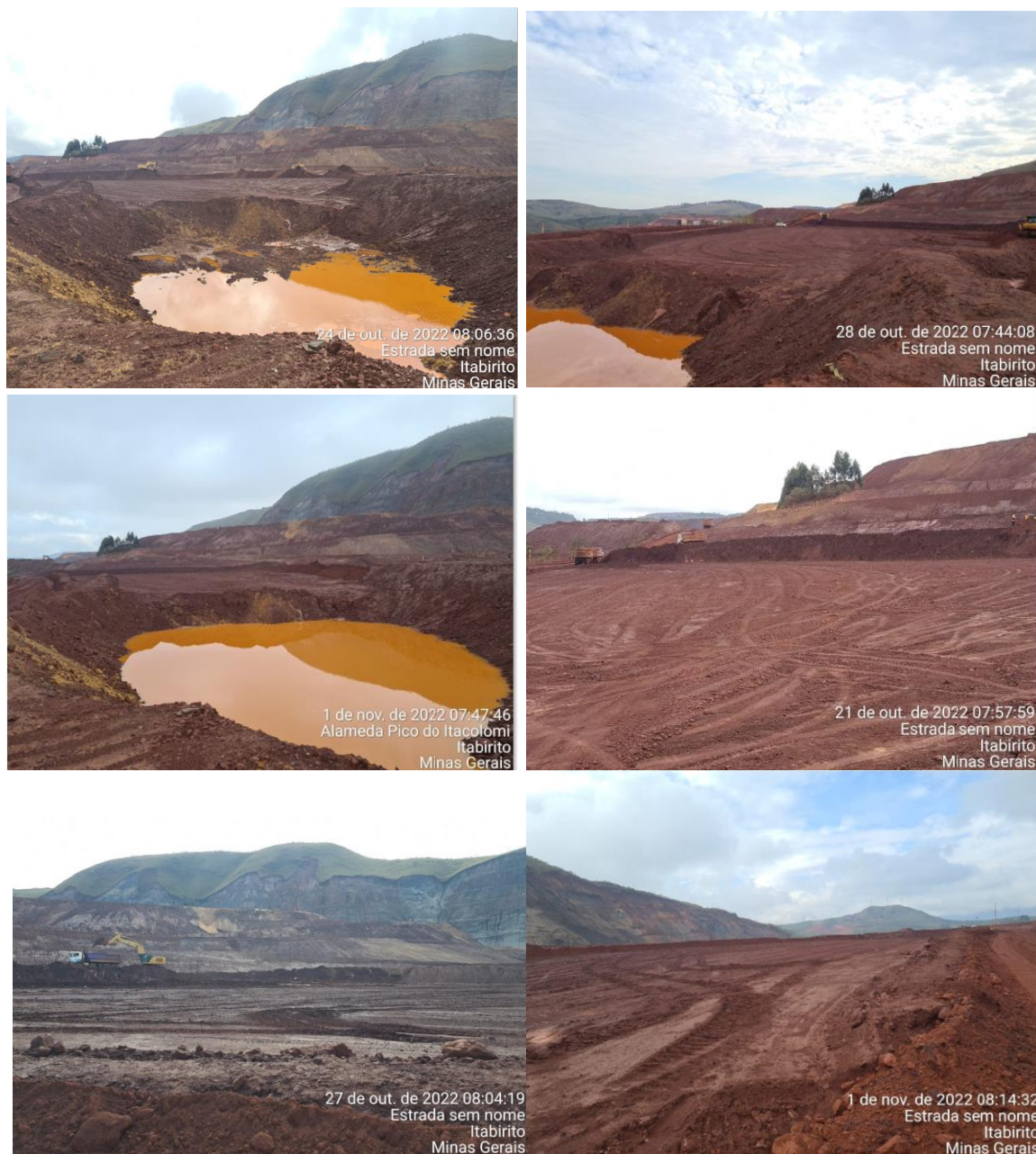
Figura 8-2: Sump funcionando de modo adequado. Observação para o reservatório da barragem sem água, erosões ou quaisquer indícios de instabilidade.
