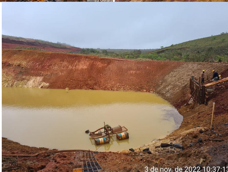
Figura 7-3: sump da pilha noroeste, manilhas de 1000 e “sapinho” compactando as camadas contiguas ao extravasor, respectivamente.
