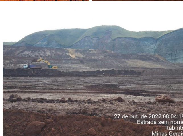
Figura 8-3: Remoção de rejeito na Barragem Aredes neste trimestre.
