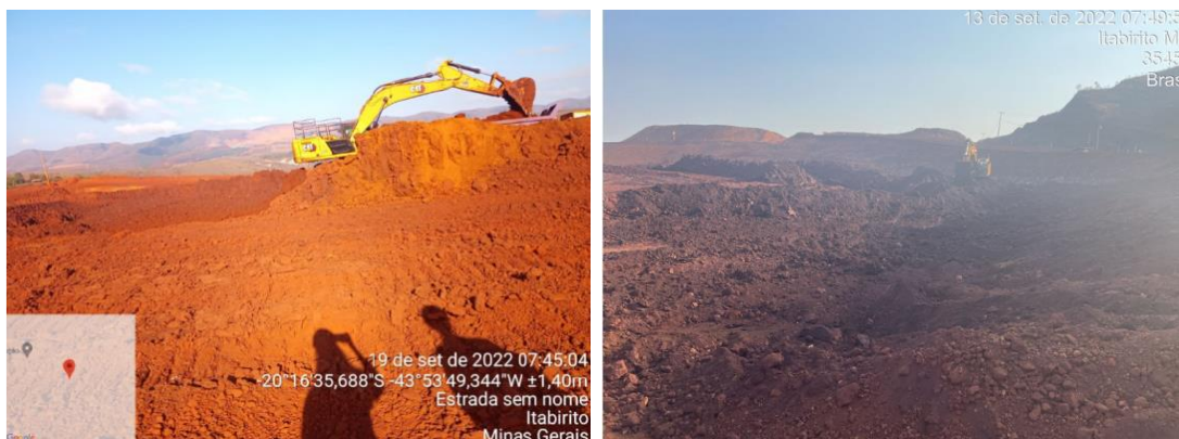
Figura 8-1: Abertura do sump na Barragem Aredes.
