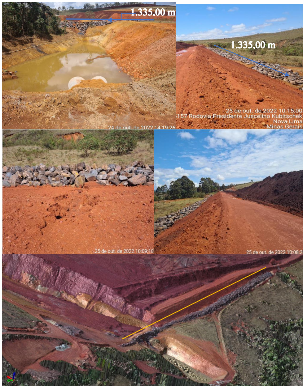
Figura 7-4: Enrocamento na pilha noroeste.
