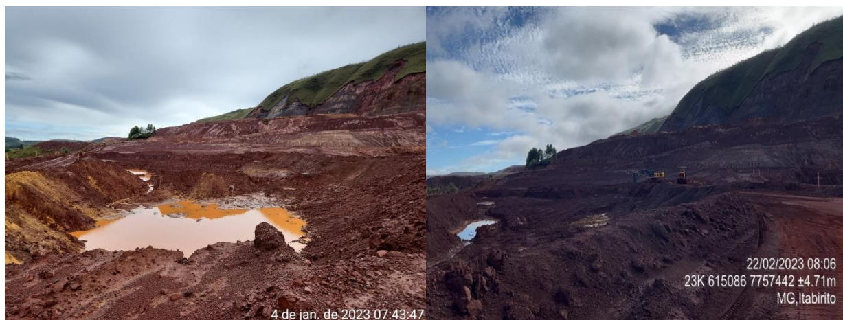
Figura 7-3: Sump funcionando durante o período chuvoso
