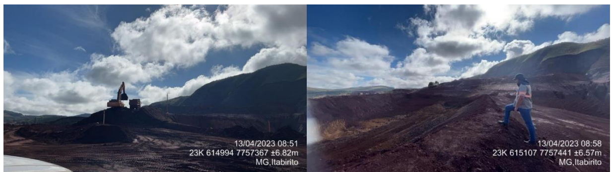
Figura 7.2-3: Processo de Descaracterização da Barragem Aredes –Abril/2023
