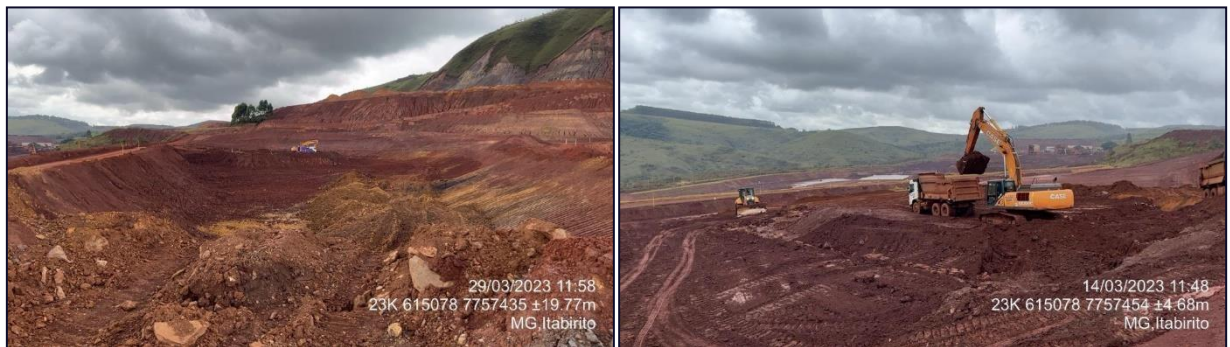
Figura 7.1-3: Processo de Descaracterização da Barragem Aredes –Março/2023.
