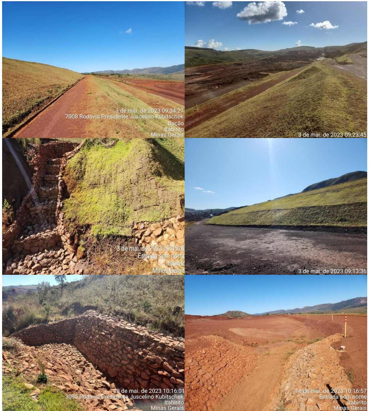
Figura 7.3-2: Barragem Aredes – Maio/2023
