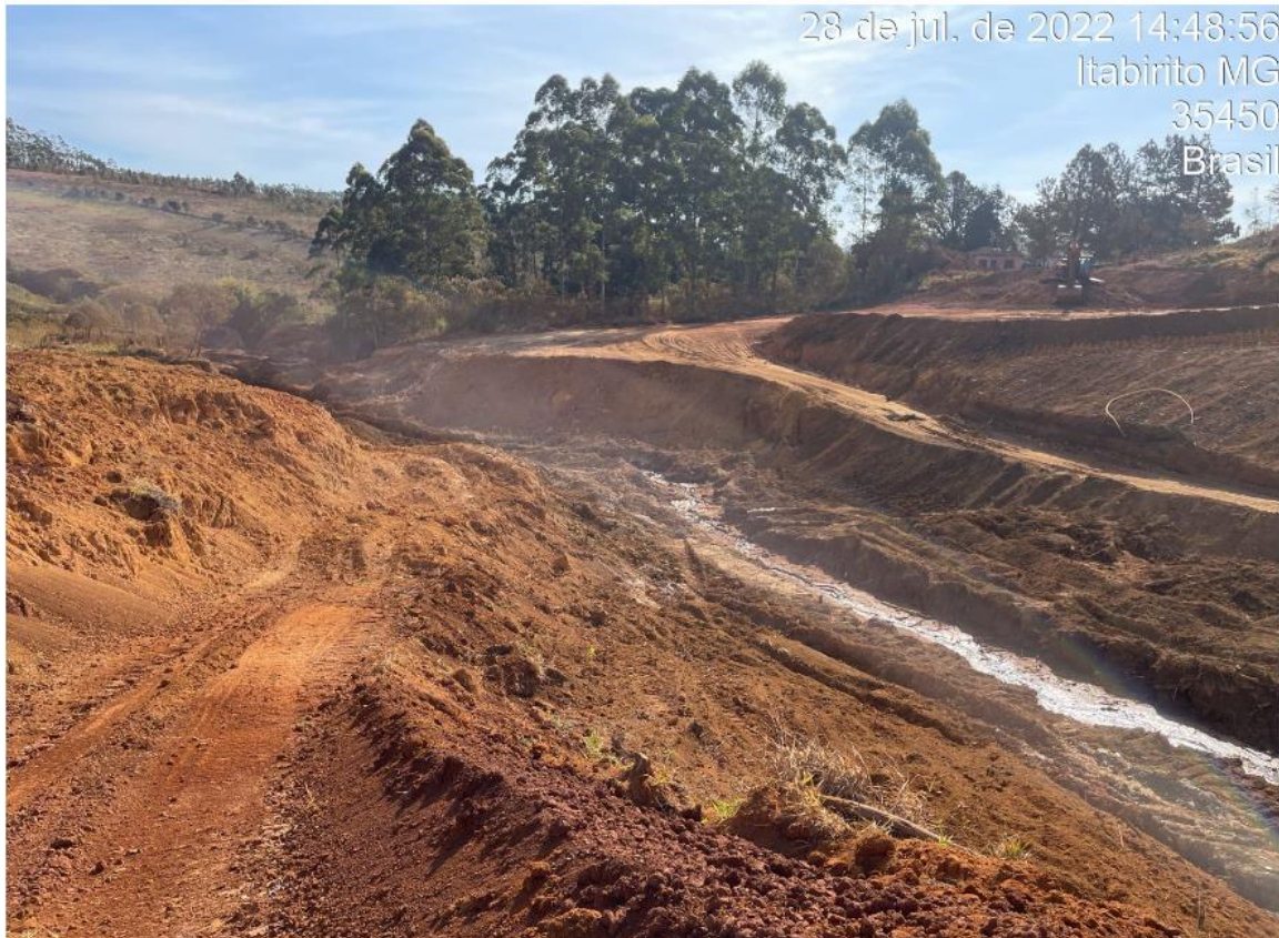
Figura 8-5: Escavação do dreno de fundo da pilha Noroeste.
