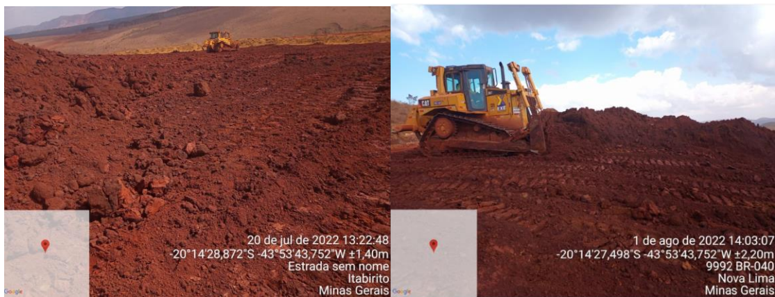
Figura 8-1: Compactação do rejeito removido da barragem Aredes na pilha Noroeste.
