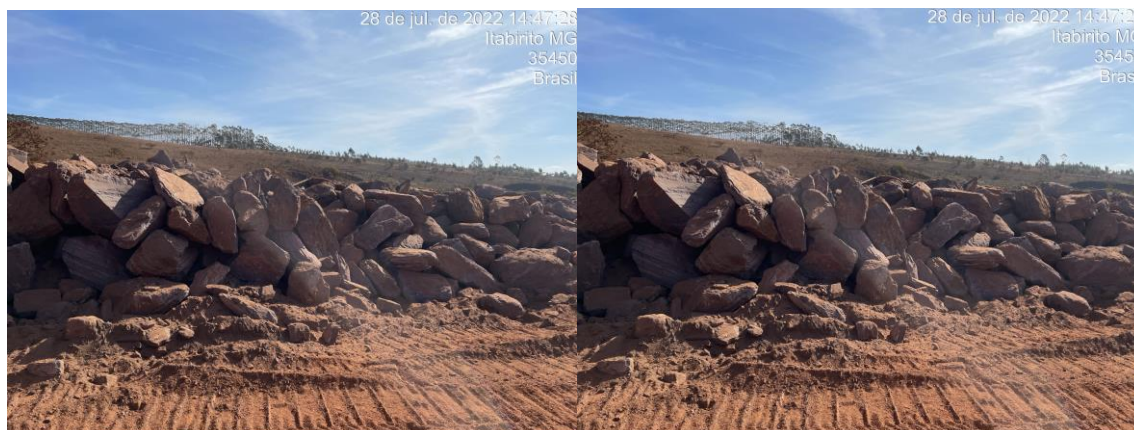
Figura 8-3: Enrocamento sendo construído conforme especificação em projeto.
