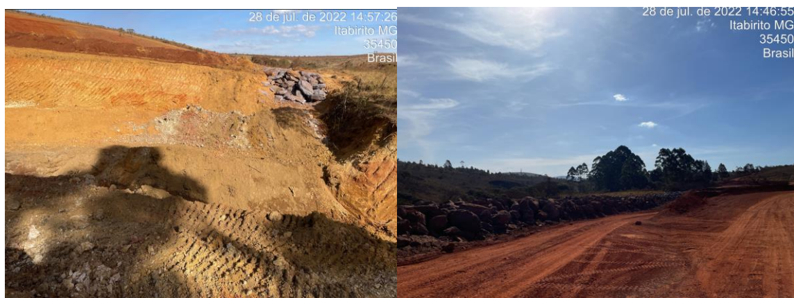
Figura 8-2: Enrocamento da pilha Noroeste
