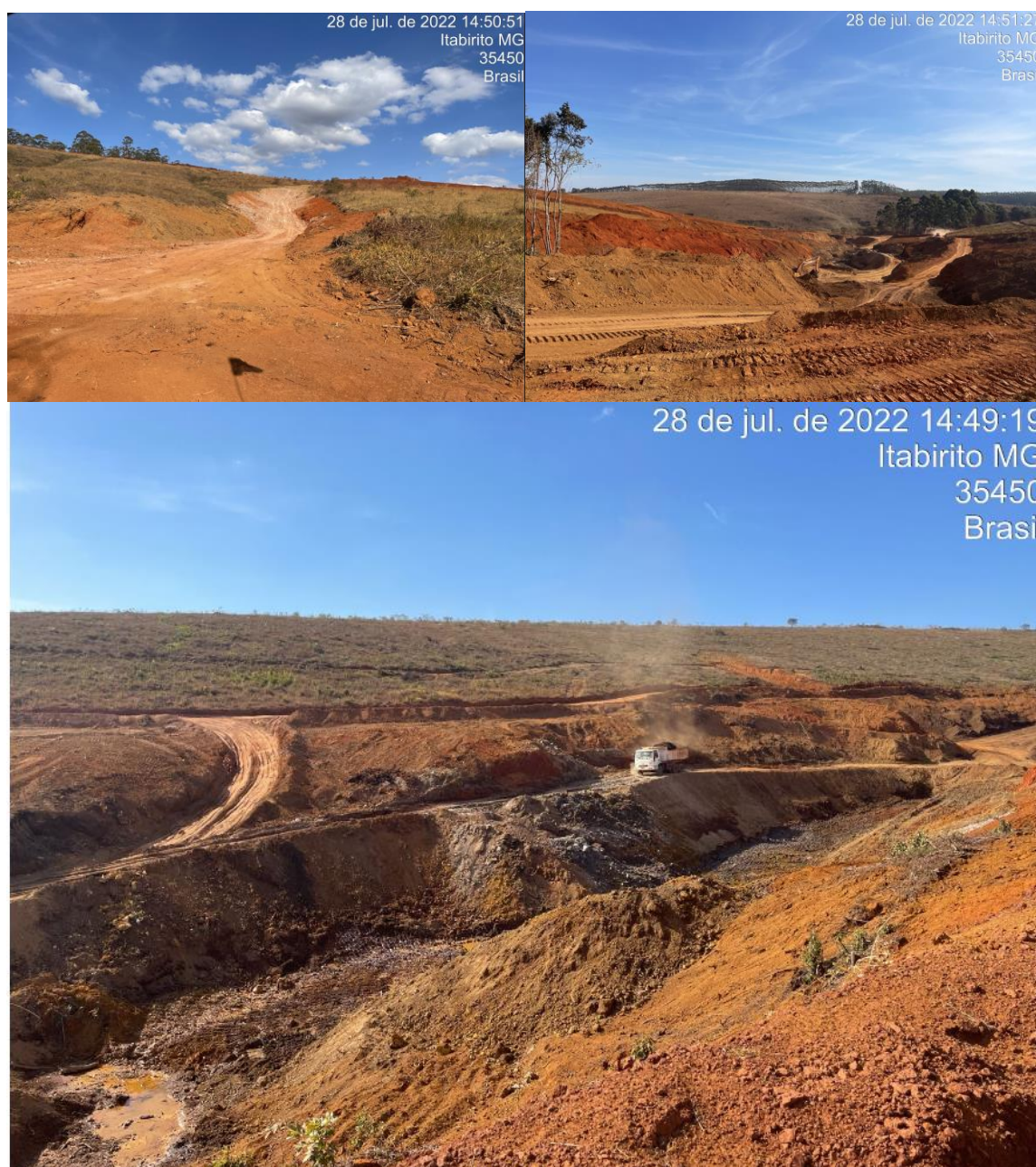
Figura 8-4: Desmate na área onde será construída a futura pilha Noroeste.
