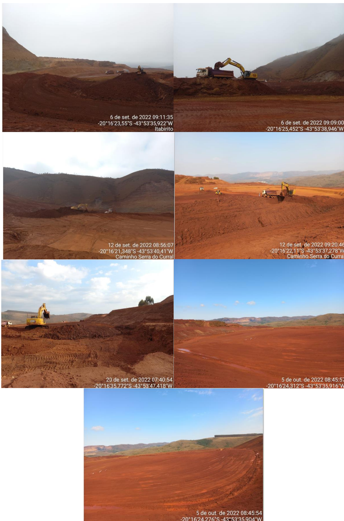
Figura 8-2: Evidências da remoção da barragem Central.
