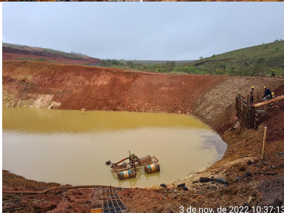
Figura 7-3: sump da pilha noroeste, manilhas de 1000 e “sapinho” compactando as camadas contíguas ao extravasor, respectivamente.
