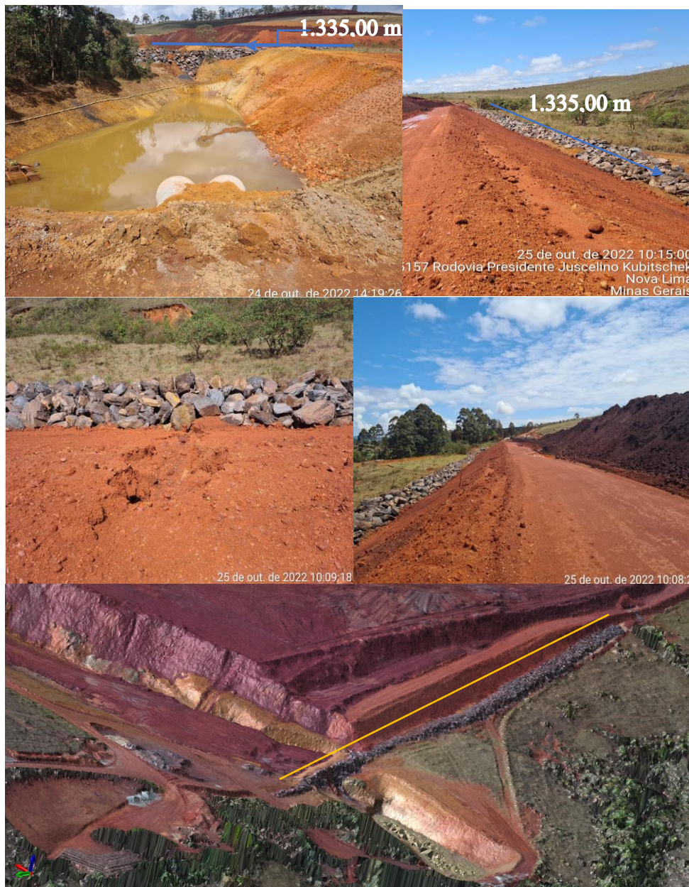
Figura 7-4: Enrocamento na pilha noroeste.
