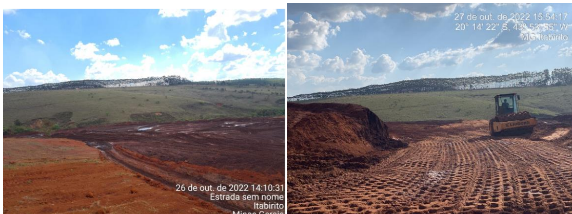
Figura 7-5: Pilha noroeste. Rejeito compactado.
