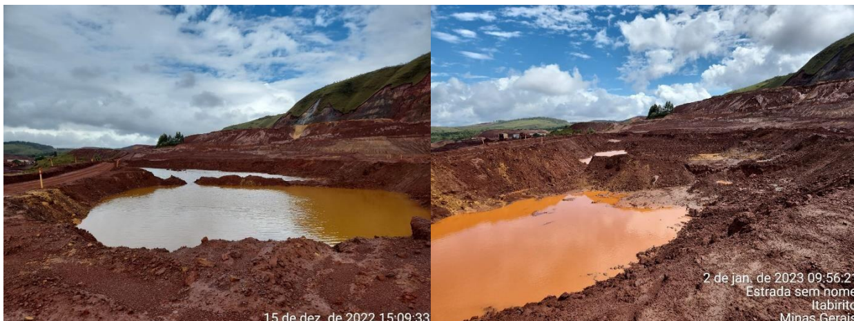
Figura 1-2: Sump funcionando durante o período chuvoso
