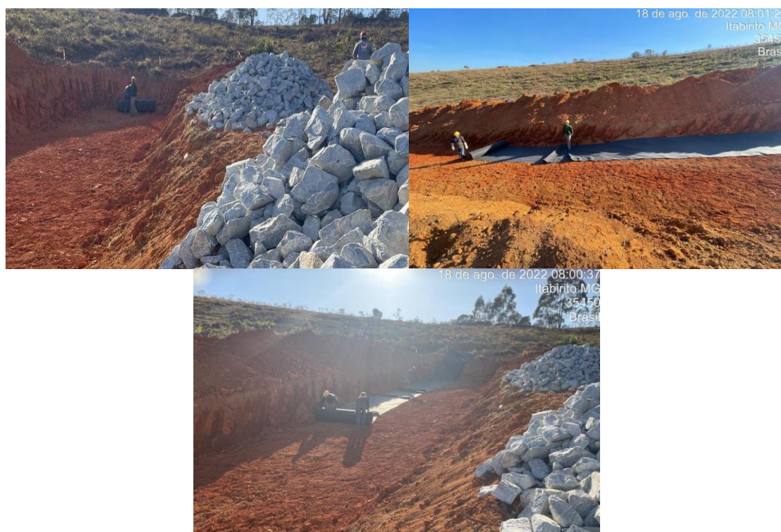
Figura 8-10: Bidim sendo colocado no dreno de fundo da pilha noroeste.
