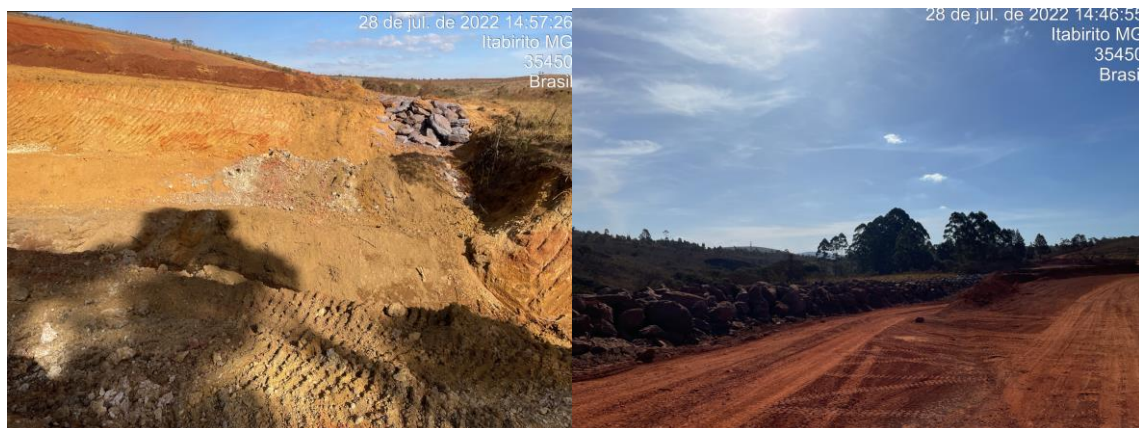
Figura 8-6: Enrocamento da pilha Noroeste
