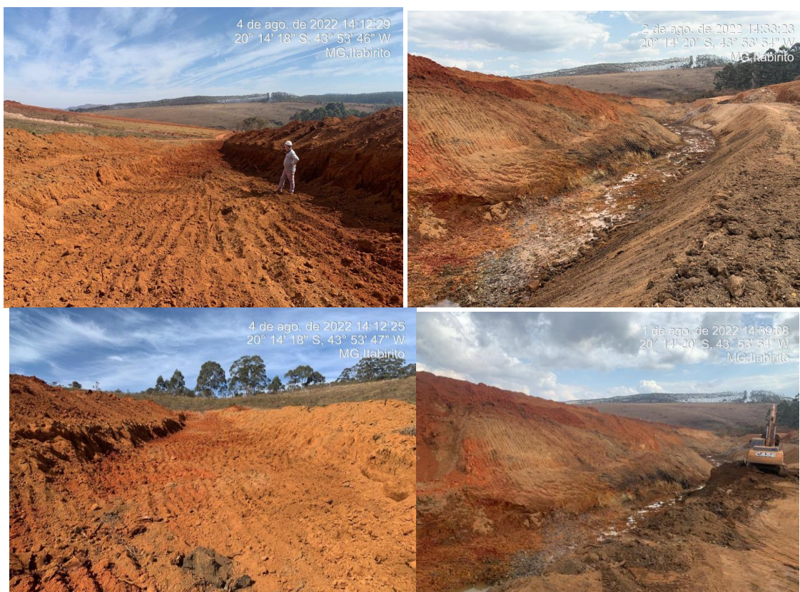
Figura 8-8: Limpeza do dreno de fundo da pilha noroeste.
