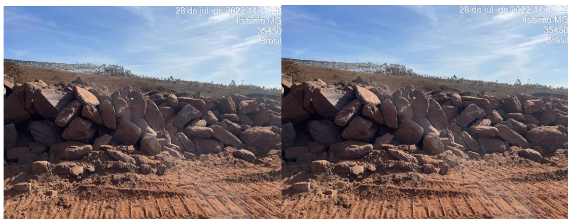
Figura 8-7: Enrocamento sendo construído conforme especificação em projeto.
