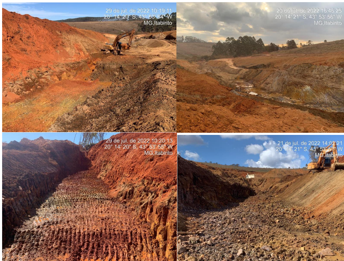
Figura 8-9: Escavação do dreno de fundo da pilha Noroeste.
