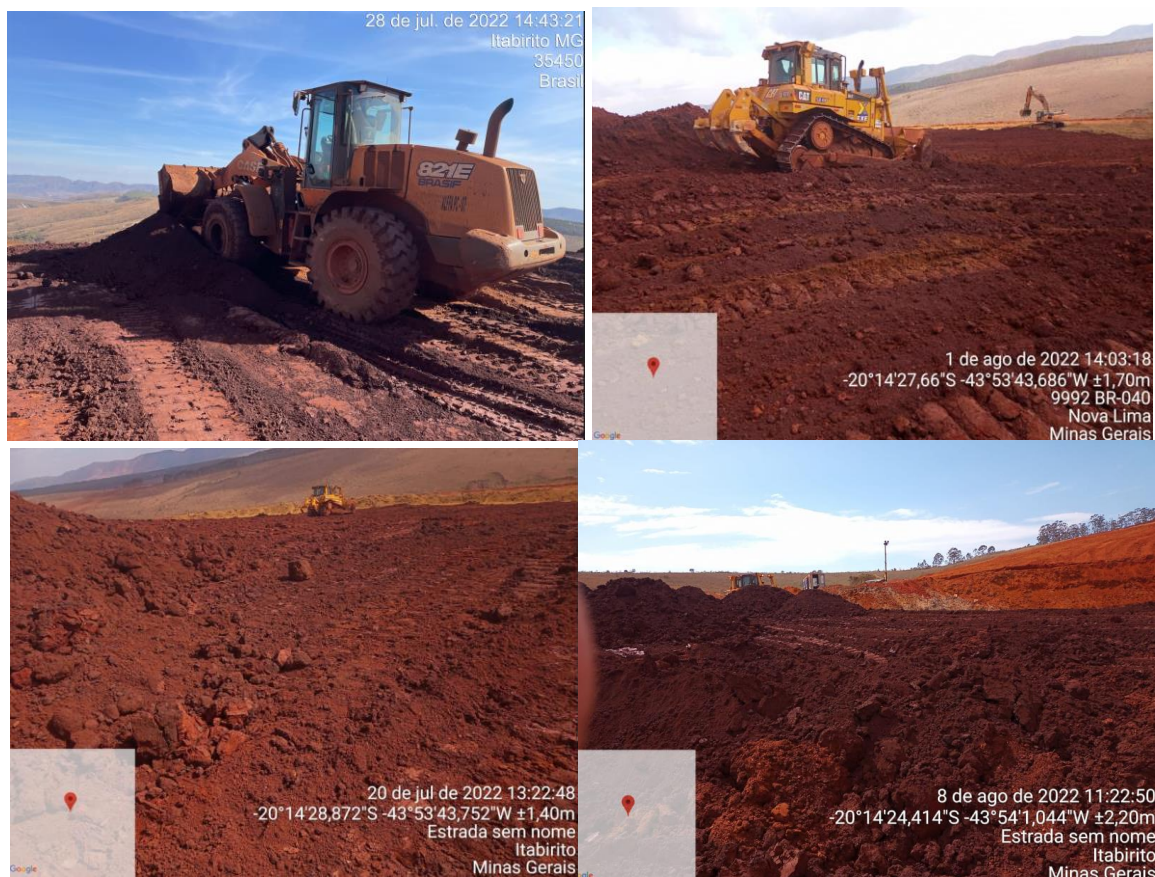
Figura 8-5: Compactação do rejeito removido da barragem Aredes na pilha Noroeste.
