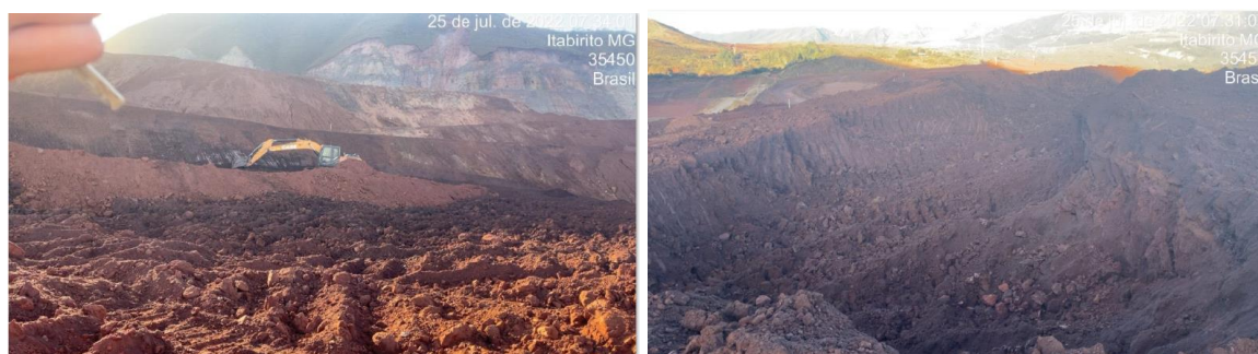
Figura 8-3: Remoção de rejeito conforme especificação de projeto executivo na Barragem Aredes.
