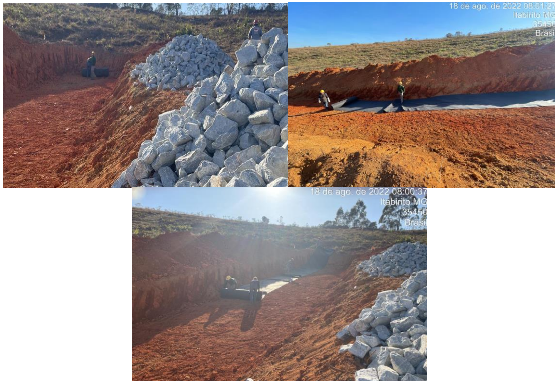
Figura 8-7: Bidim sendo colocado no dreno de fundo da pilha noroeste.
