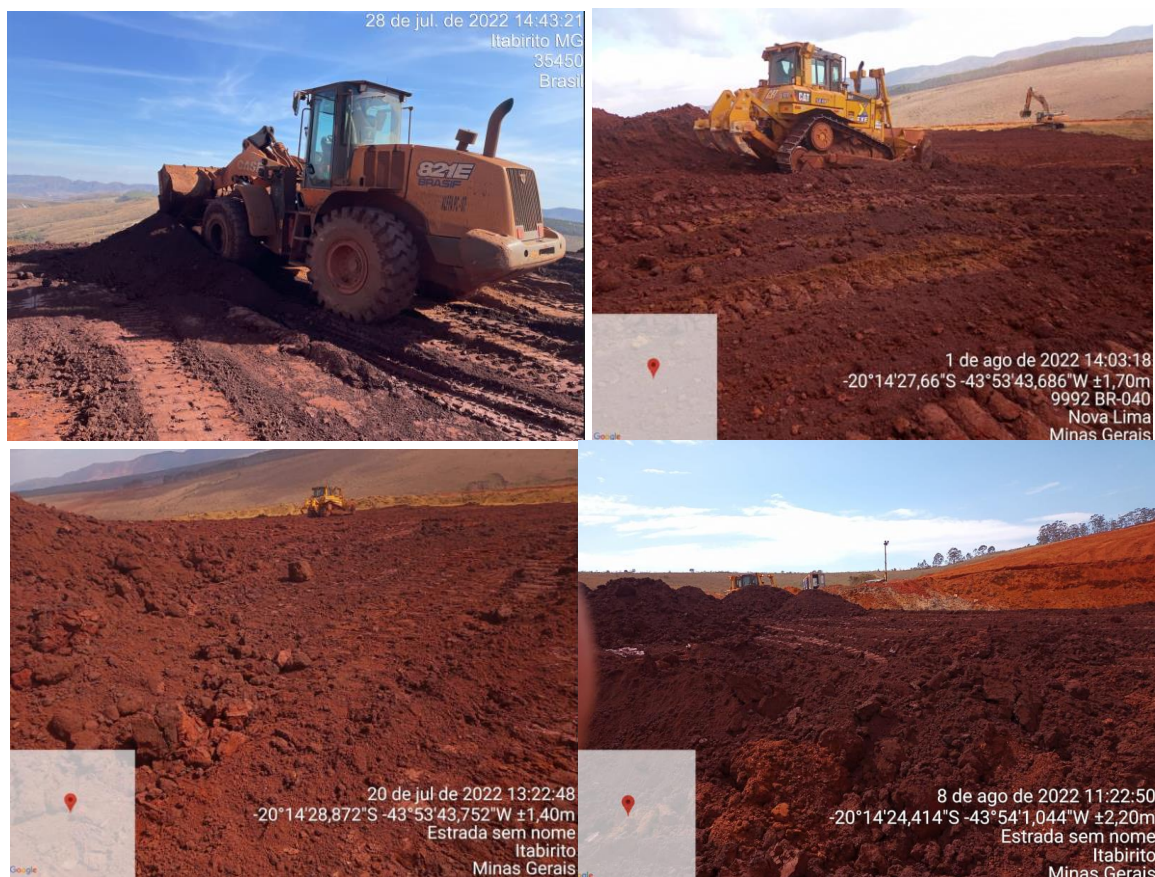
Figura 8-2: Compactação do rejeito removido da barragem Aredes na pilha Noroeste.
