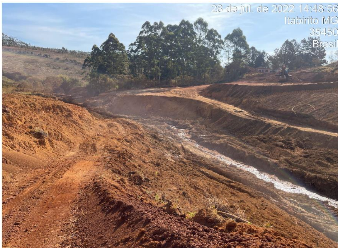
Figura 8-8: Escavação do dreno de fundo da pilha Noroeste.
