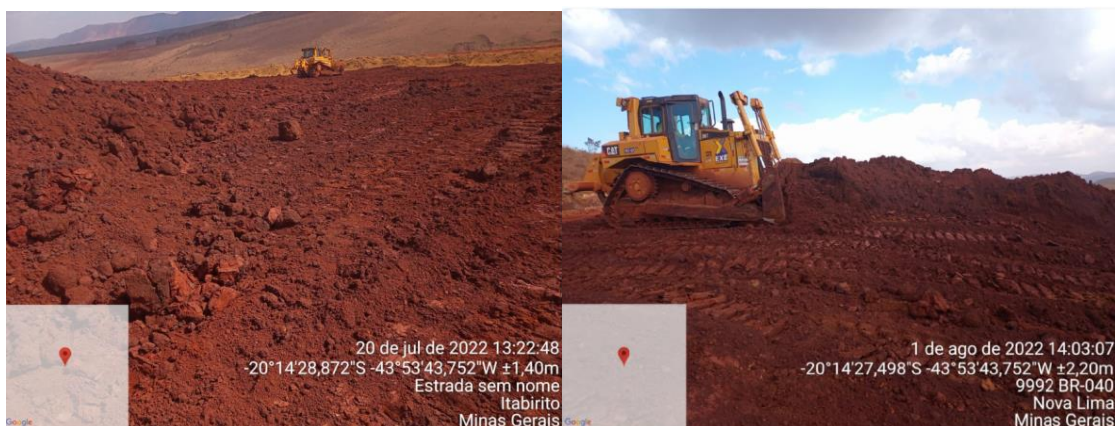
Figura 8-4: Compactação do rejeito removido da barragem Aredes na pilha Noroeste.
