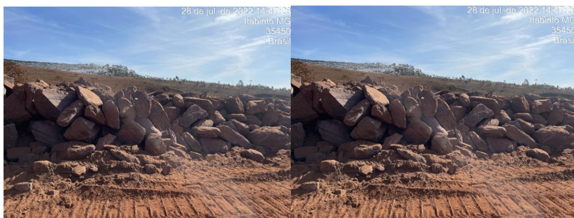
Figura 8-5: Enrocamento sendo construído conforme especificação em projeto.
