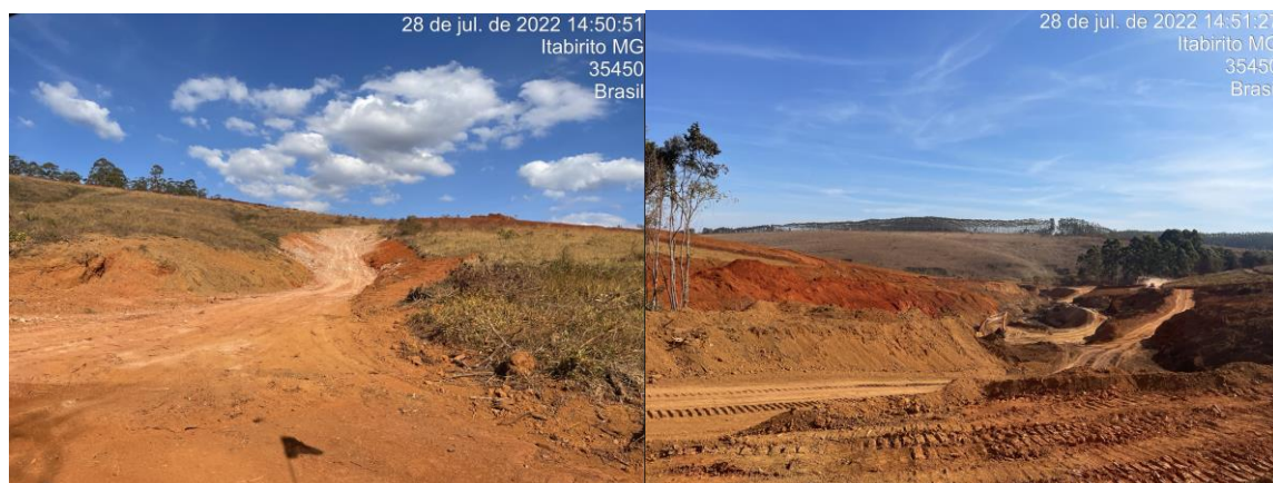
Figura 8-6: Desmate da área do dreno de fundo da pilha noroeste.
