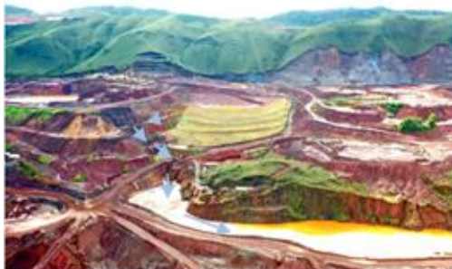
Figura 4-9: Sistema de drenagem partindo da barragem central até o sump que converge para a cava sul.
