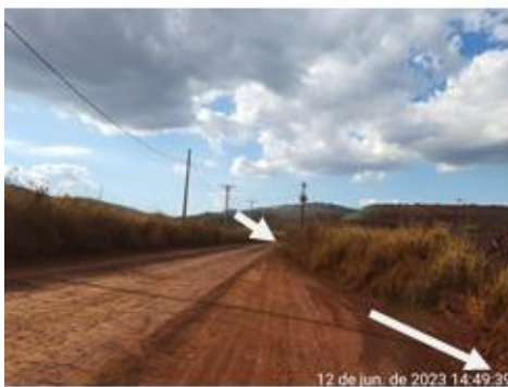
Figura 4-10: ITA – 320 em ótimo estado de conservação
