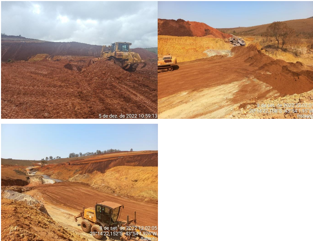
Figura 6-36: Devida compactação do material na pilha noroeste -Inspeções diárias
