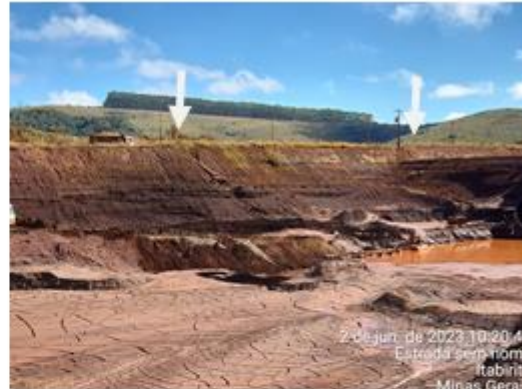
Figura 4-5: Encanamentos com direcionamento da água proveniente da ITA-320 para a cava do dique.
