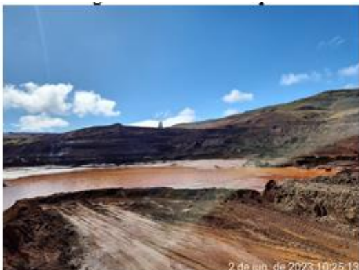
Figura 4-4: Cava do dique.
