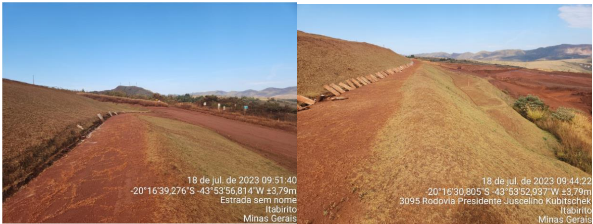
Figura 6-23: maciço da Barragem Aredes durante o período referente a este trimestre
