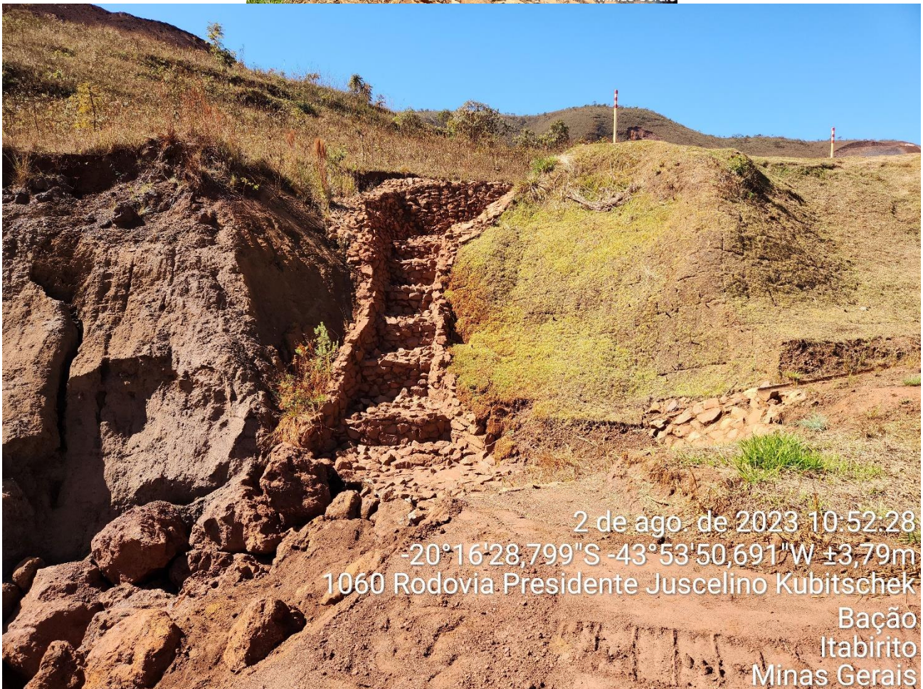
Figura 6-42: Reservatório da barragem Aredes no trimestre
