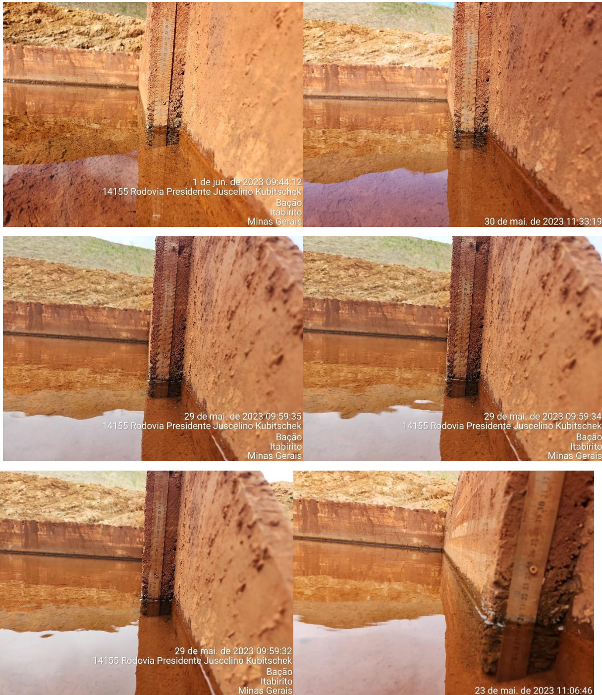
Figura 6-6: Monitoramento da vazão da drenagem interna da pilha noroeste
