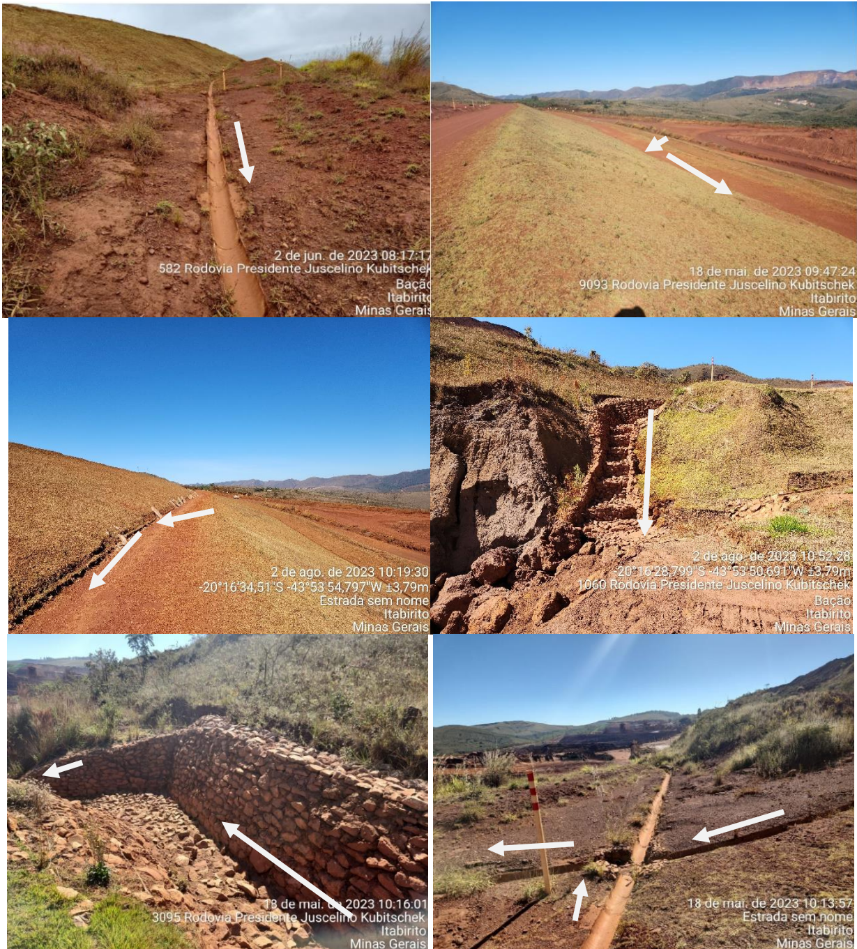
Figura 6-44: Fluxo de drenagem na barragem Aredes
