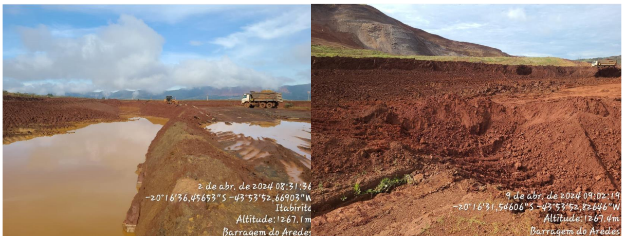
Figura 6-3: Reservatório da Barragem Aredes com acúmulo de água no sump temporário (Foto a esquerda) e dias seguidos com o reservatório já seco e operante (foto a direita)
