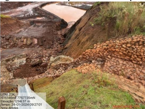
Figura 6-47: Saída da drenagem do sistema principal da Barragem Aredes para o dique a jusante.
