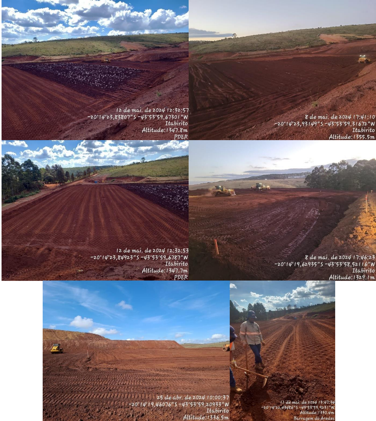
Figura 6-15: Espalhamento, compactação, teste de hilf e proctor e acompanhamento diário da estrutura referente a este relatório
