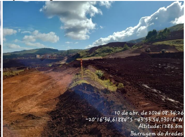
Figura 6-21: Remoção do maciço da barragem Aredes
