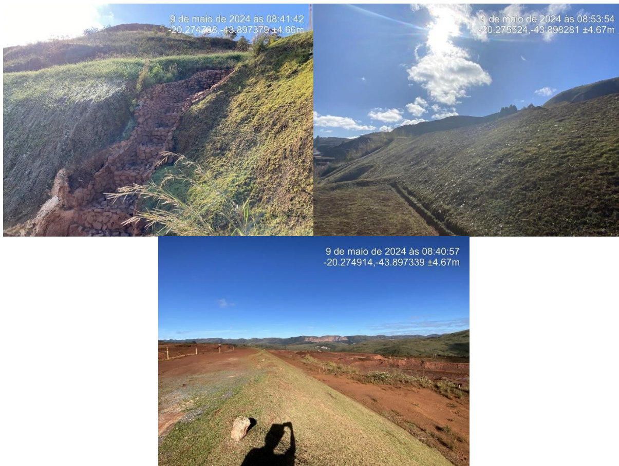
Figura 6-32: Condições do maciço e vegetação ao longo do trimestre
