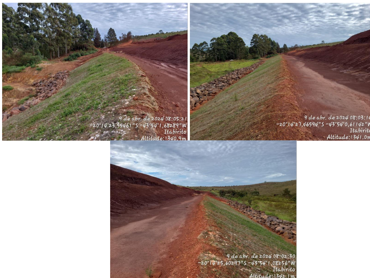
Figura 6-14: Vegetação do primeiro talude da pilha noroeste.
