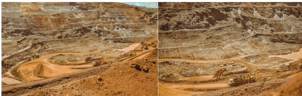
Figura 6-49: Cava sul. Sump para onde a água da barragem Aredes é desviada.
