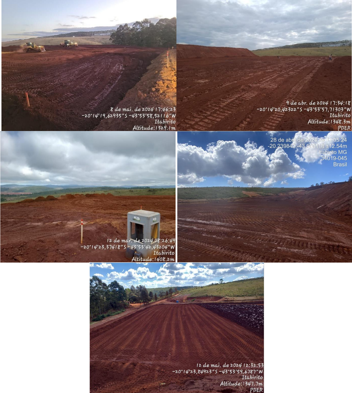
Figura 6-10: Pilha Noroeste – inspeção diária
