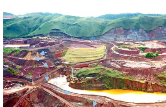
Figura 6-45: Sistema de drenagem partindo da barragem central até o sump que converge para a cava sul.
