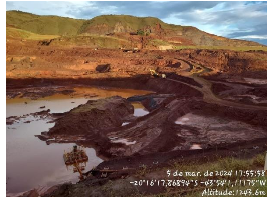
Figura 6-41: Cava do dique.
