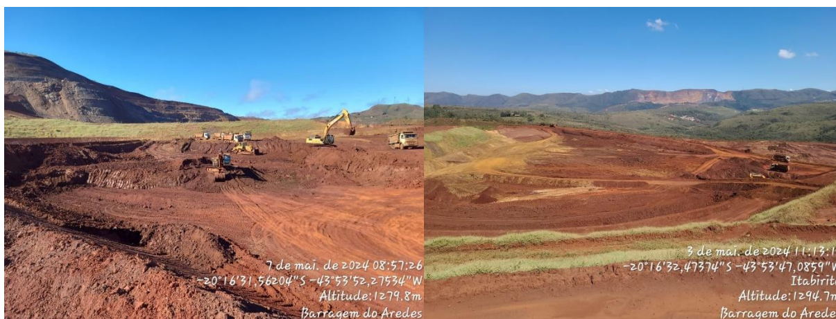
Figura 6-35: Remoção do reservatório da Barragem Aredes.
