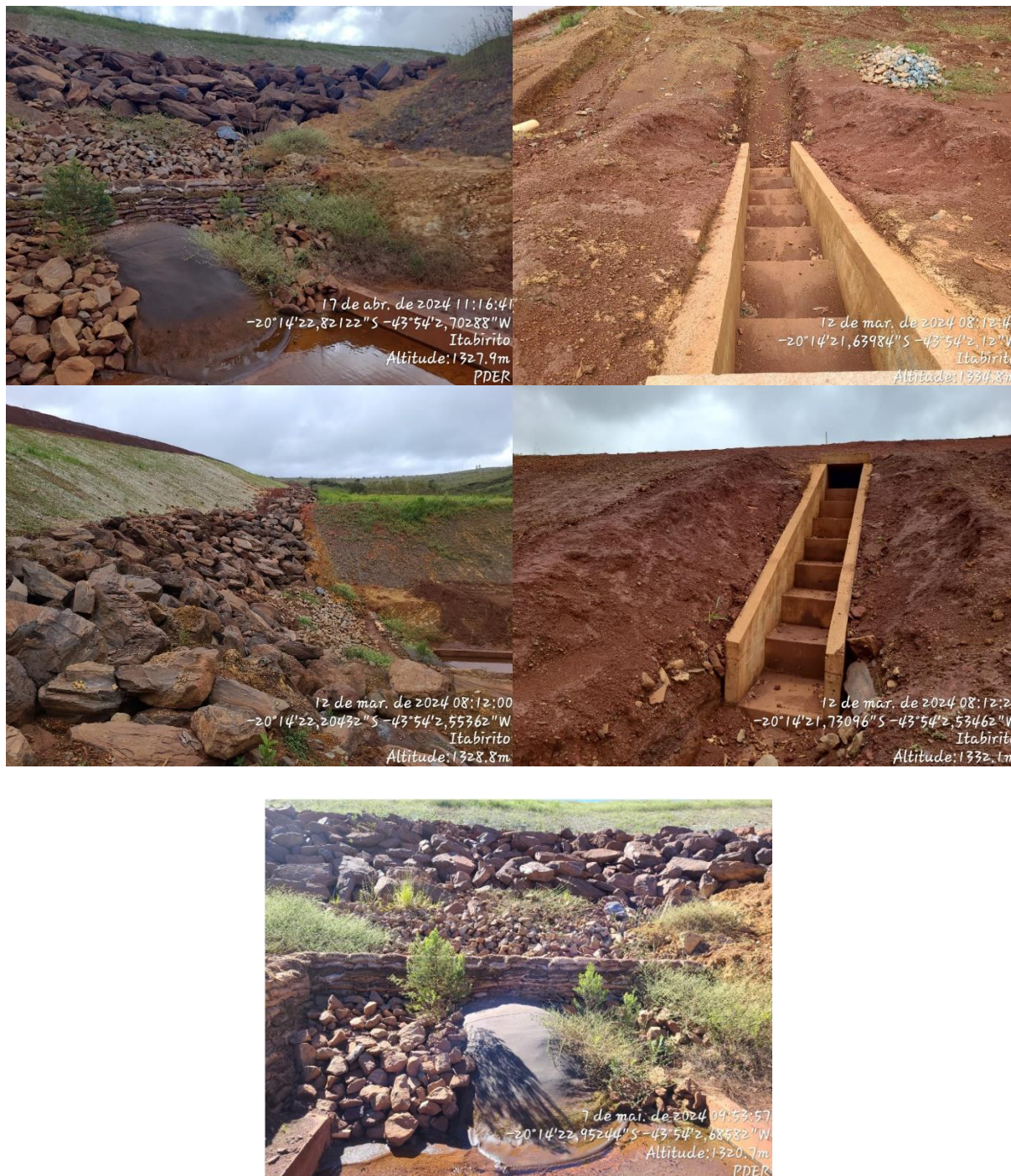
Figura 6-12: manutenção das áreas referentes ao sistema de drenagem da pilha noroeste
