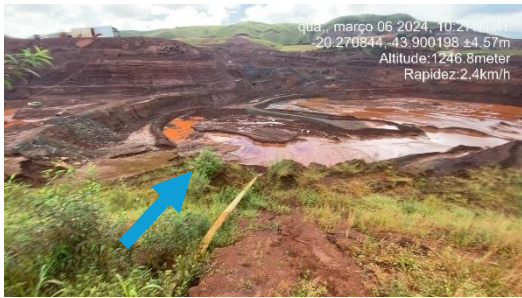
Figura 6-40: Cava do dique e tubo (seta azul)
