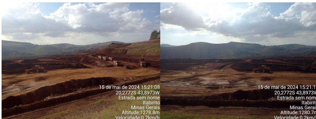
Figura 6-50: Reservatório da barragem Aredes no trimestre
