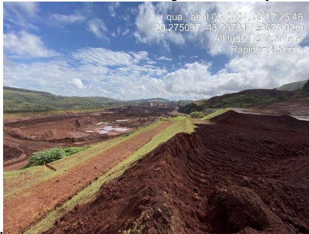
Figura 6-21: Remoção do maciço da barragem Aredes
