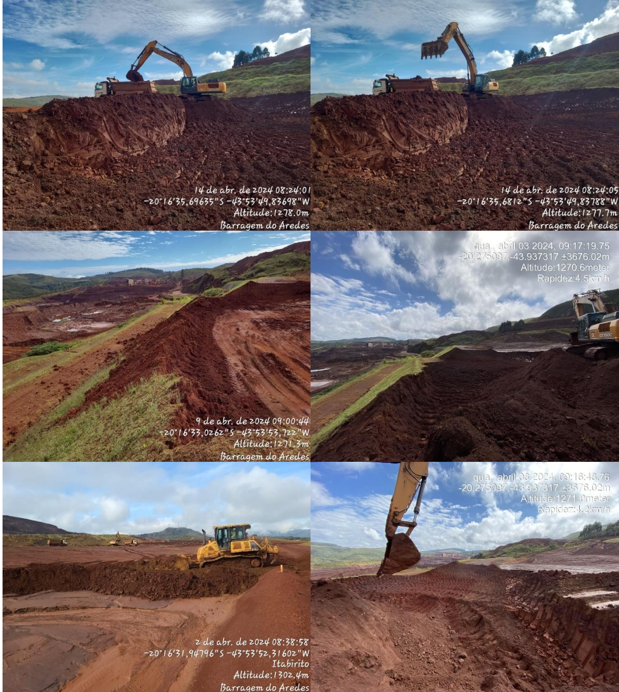
Figura 6-22: Remoção do maciço ao longo do trimestre
