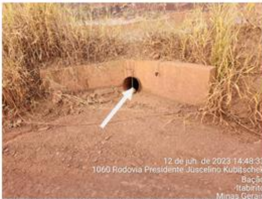
Figura 4-8: Bueiro da estrada ITA-320 em direção a Cava do dique.
