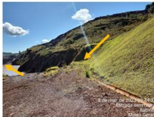
Figura 4-12: Fluxo de água pluvial a partir da barragem Aredes para a cava do dique.
