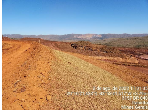
Figura 6-25: Barragem Central – condições do maciço e drenagem
