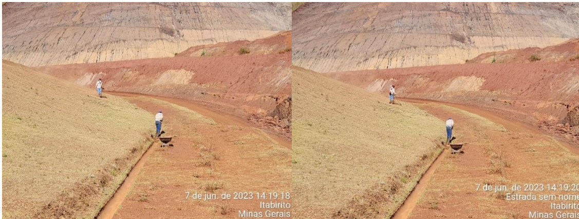
Figura 6-50: Manutenção na barragem central
