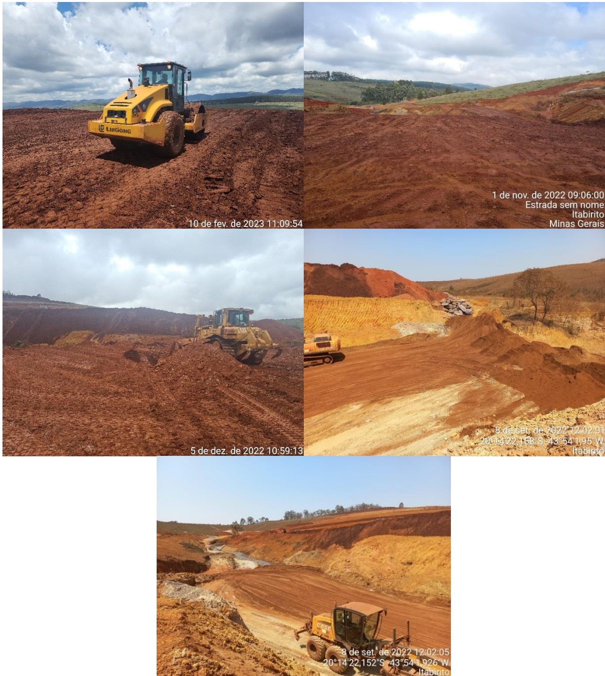
Figura 6-42: Devida compactação do material na pilha noroeste -Inspeções diárias
