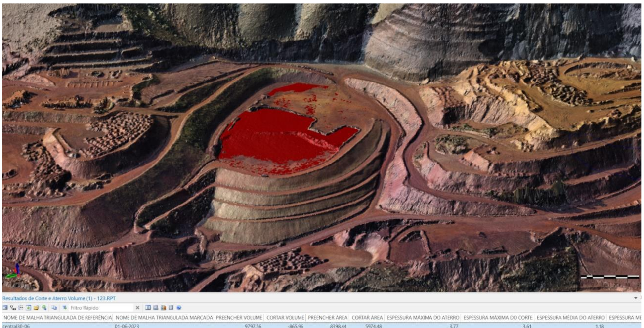
Figura 6-16: Volume retirado na Barragem Arêdes no mês de junho de 2023. Destaque para região da retirada do rejeito.
