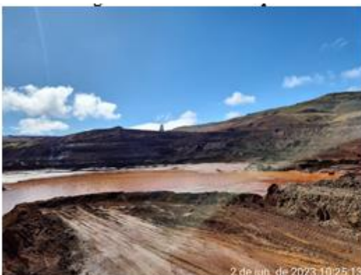
Figura 4-4: Cava do dique.
