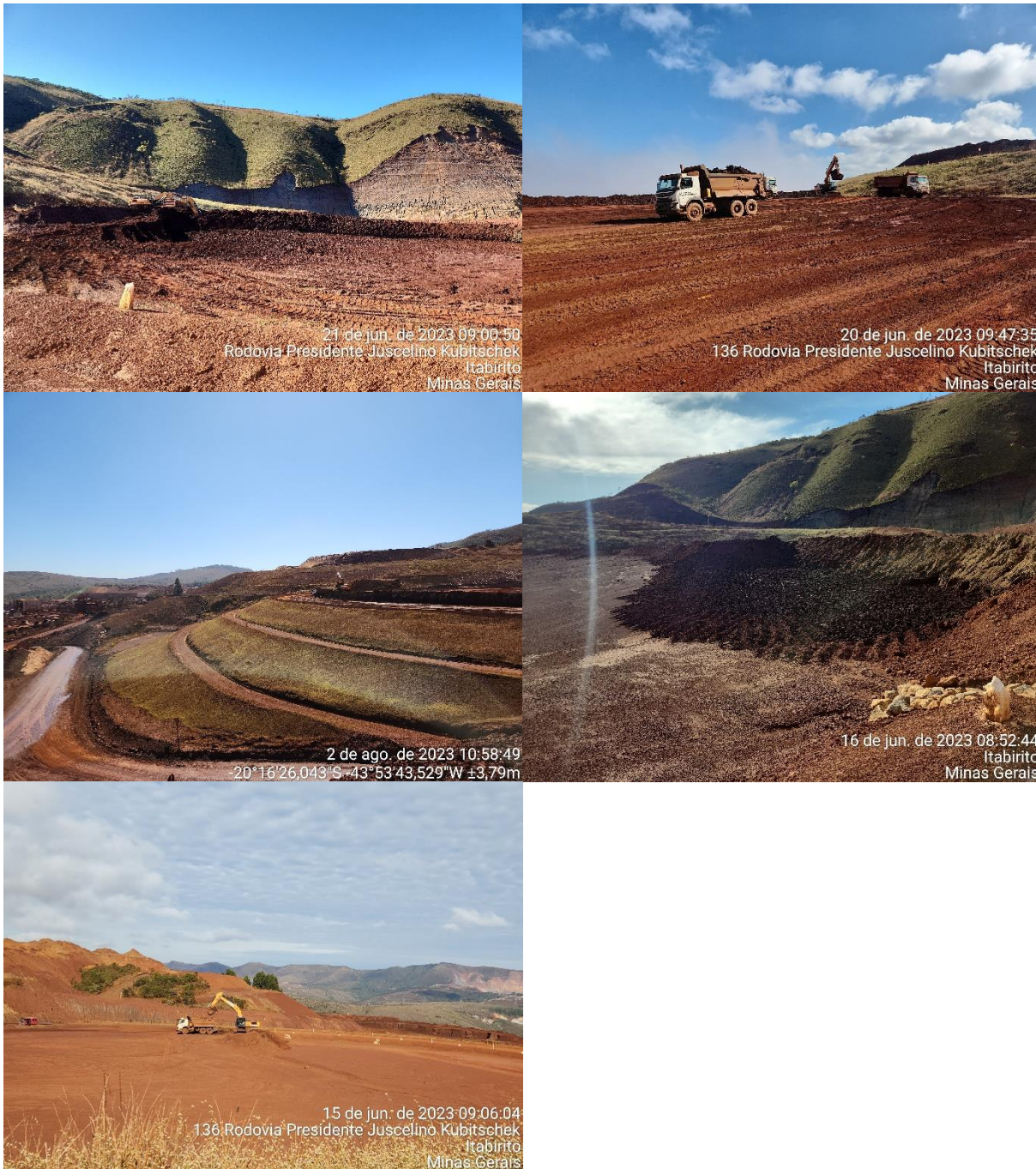
Figura 6-41: Descaracterização da Barragem Central no trimestre
