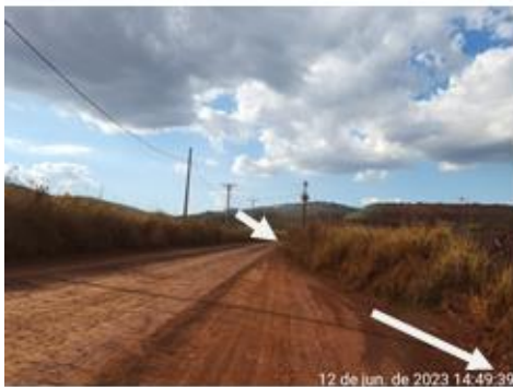
Figura 4-10: ITA – 320 em ótimo estado de conservação
