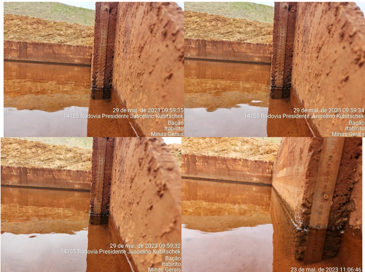
Figura 6-5: Monitoramento da vazão da drenagem interna da pilha noroeste
