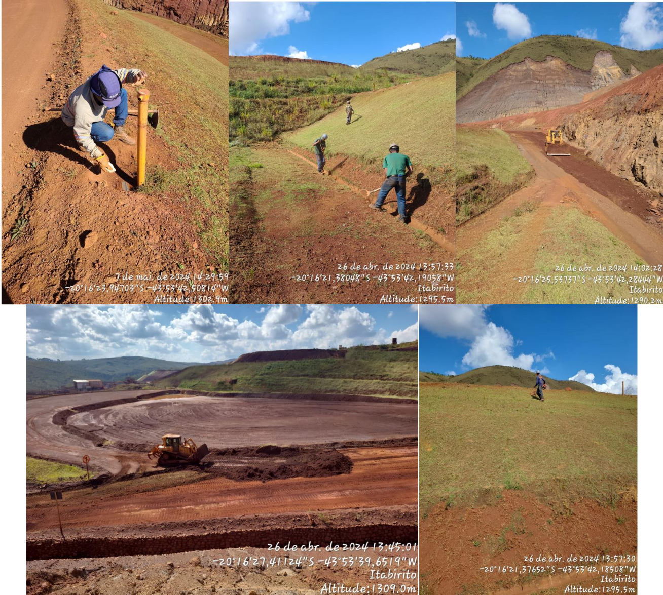
Figura 5-4: Alguma das manutenções realizadas na Barragem Central
