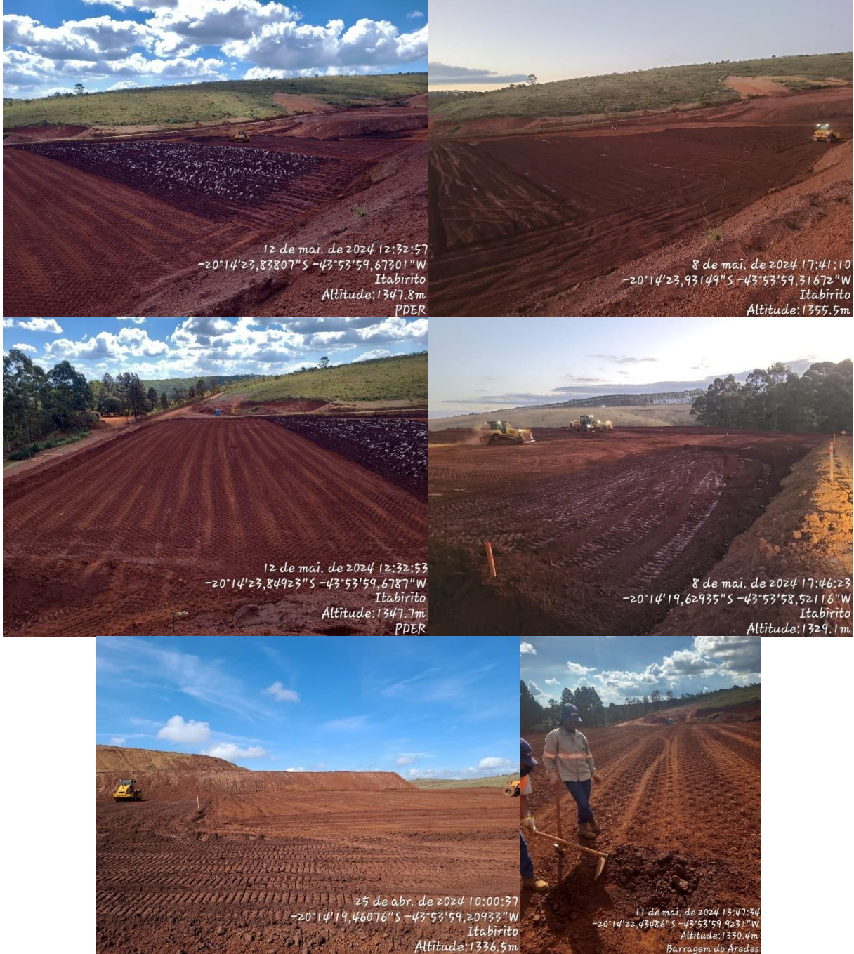
Figura 6-13: Espalhamento, compactação, teste de hilf e proctor e acompanhamento diário da estrutura referente a este relatório
