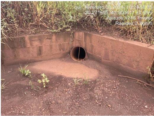
Figura 6-53: Bueiro que sai da ITA-320 para o fundo da cava do dique.
