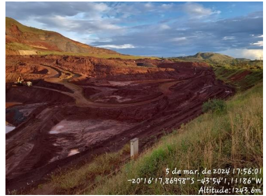
Figura 6-50: Cava do dique vista pela ITA-320.
