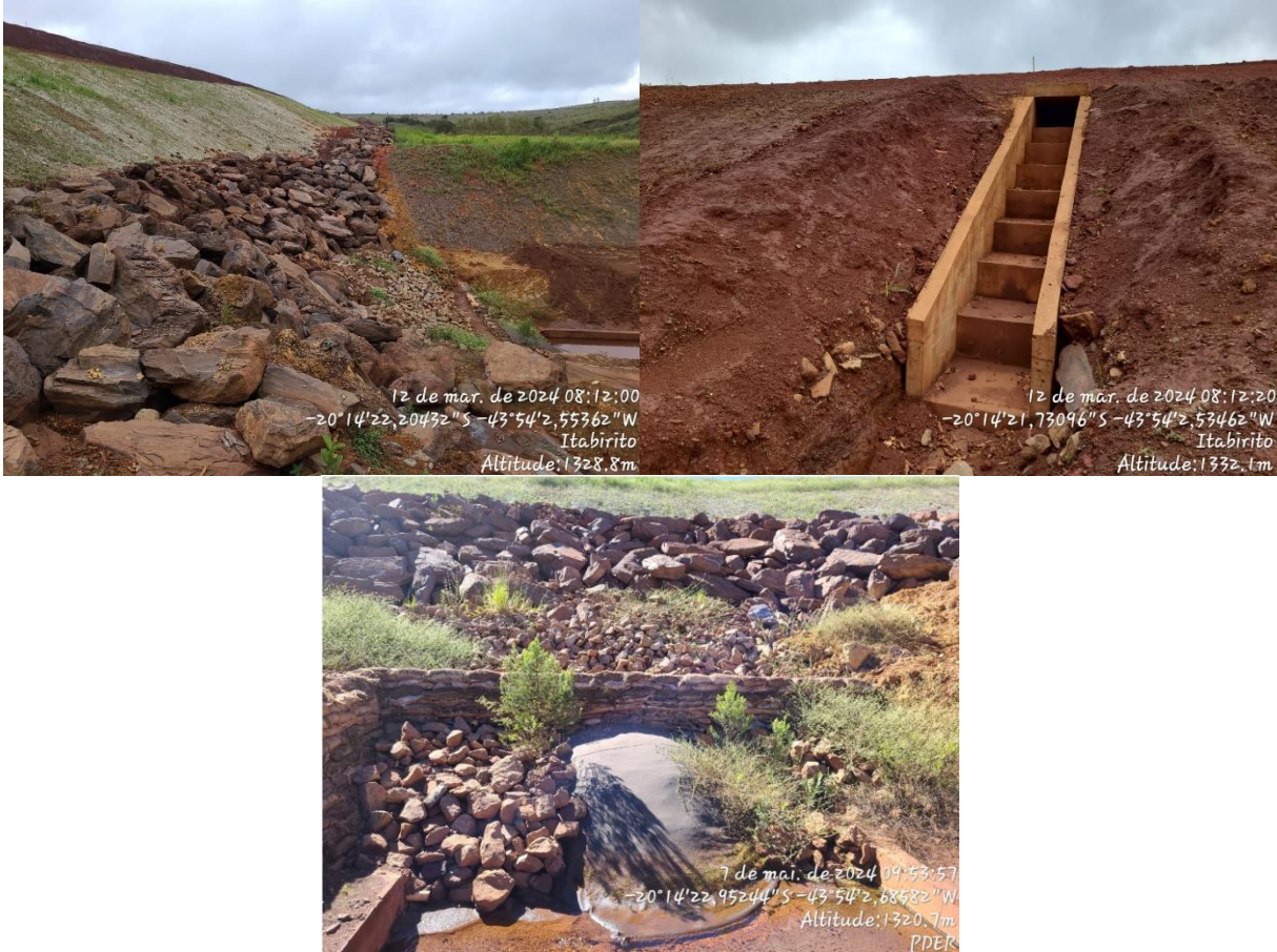
Figura 6-10: manutenção das áreas referentes ao sistema de drenagem da pilha noroeste
