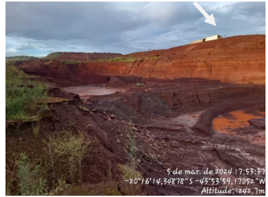
Figura 6-49: Local onde existia o dique longitudinal e atualmente é o fundo da cava do dique.
