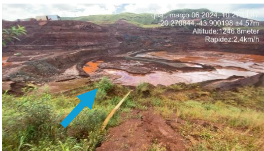
Figura 6-46: Cava do dique e tubo (seta azul)
