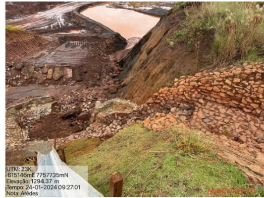
Figura 6-54: Saída da drenagem do sistema principal da Barragem Arede para o dique a jusante.
