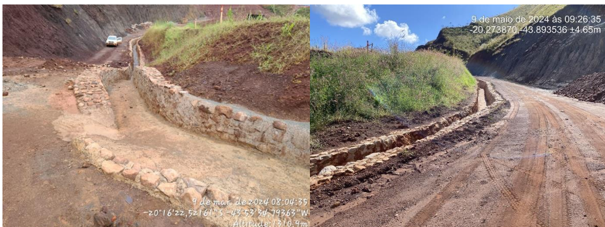
Figura 6-56: Canal de cintura sendo ampliado na barragem grotá.
