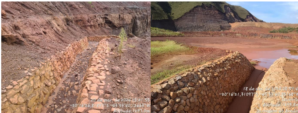
Figura 6-18: Situação geral da estrutura ao longo do trimestre.
