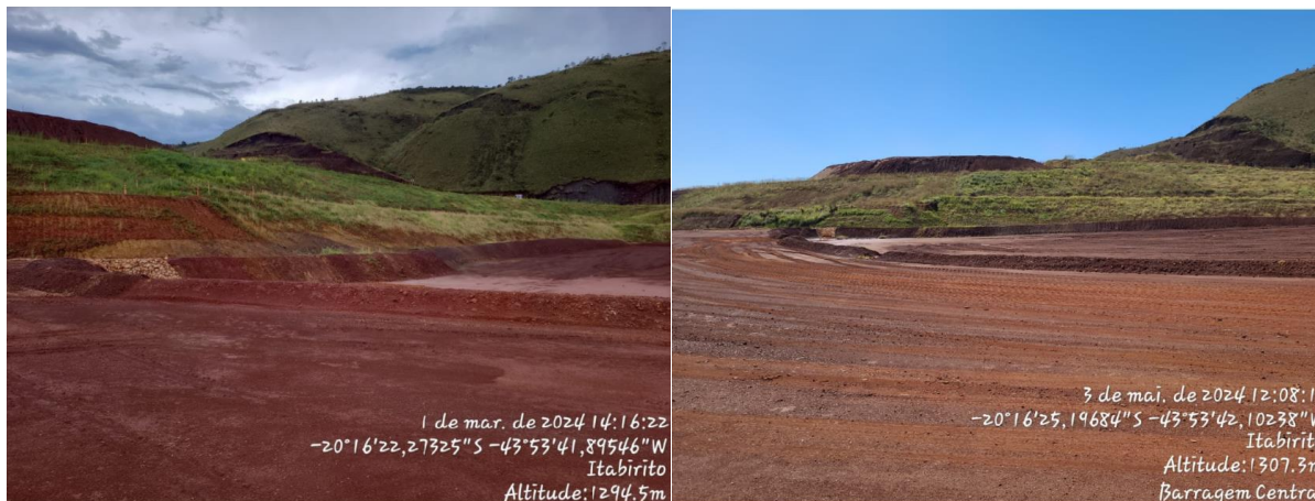
Figura 6-2: Desenvolvimento da vegetação nos taludes remanescentes da Barragem Central.
