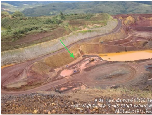
Figura 6-45: Cava sul. Água pluvial sendo retirada do fundo da cava para aspersão de poeira interna. Caminhão pipa sendo indicado com seta verde.
