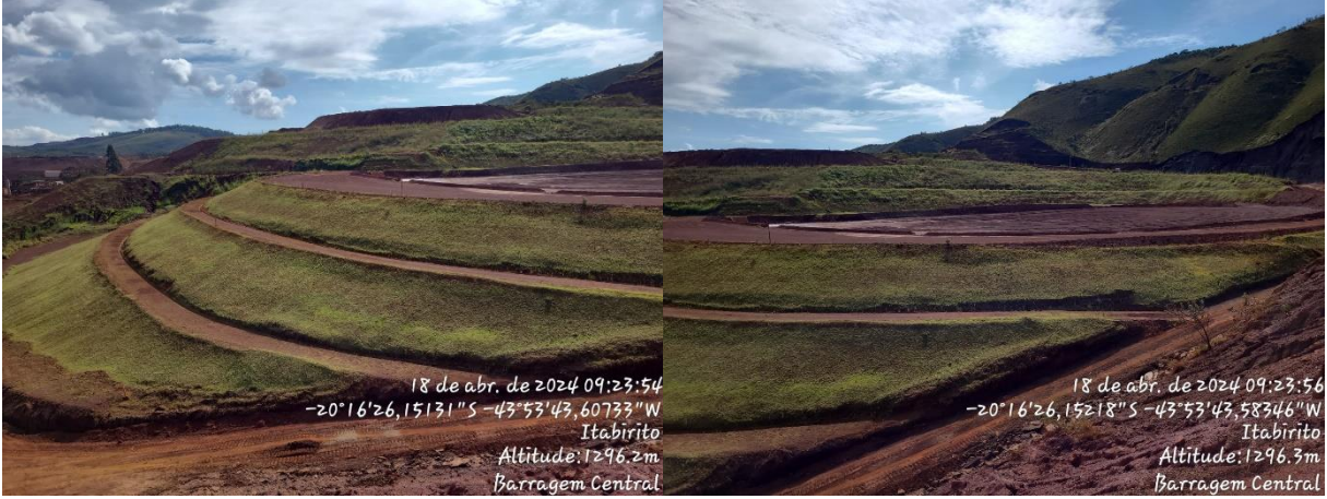
Figura 6-40: Barragem Central – condições do maciço e drenagem
