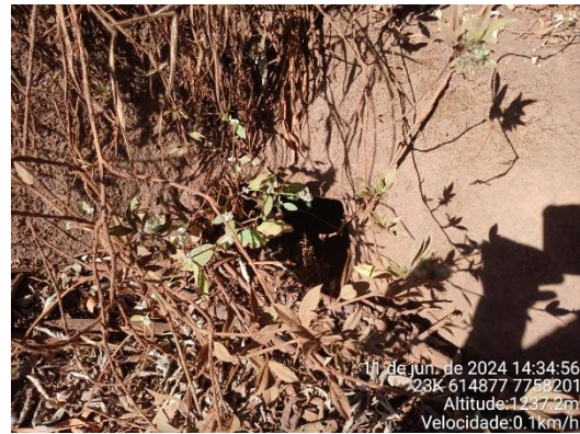
Figura 6-42: saída d'água em outro ponto da ITA-320 em declividade para a cava do dique.
