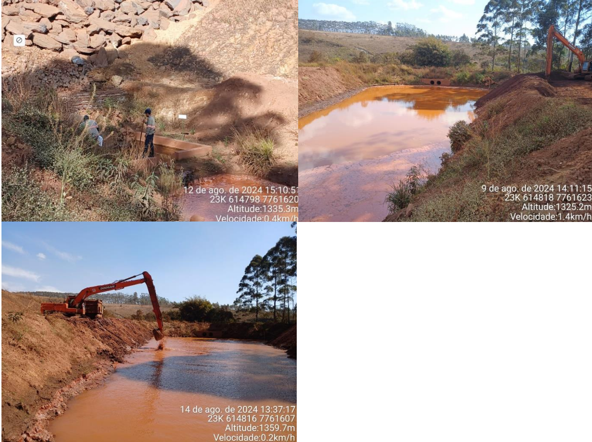
Figura 6-14: Sump e dreno de fundo com saída de água límpida– Pilha Noroeste
