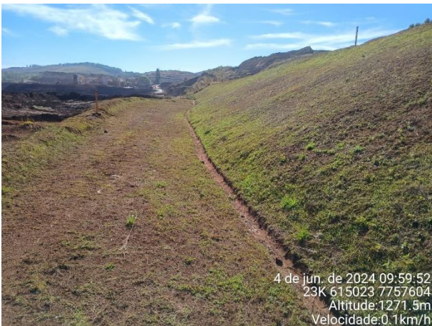
Figura 6-33: Fotografias do sistema de drenagem da Barragem Aredes ao longo do trimestre
