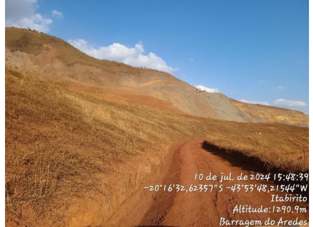
10 de jul. de 2024 15:49:35 -20°16'34,83995"S -43°53'47,29711"W Itabirito Altitude: 1291,3m Barragem do Aredes
