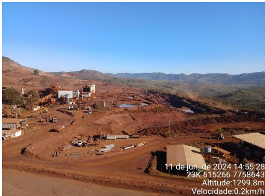
Figura 6-45: fundo da cava do dique.
