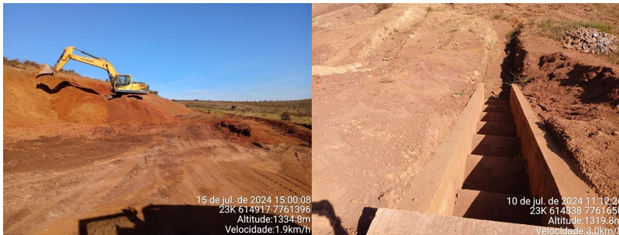
Figura 6-12: manutenção das áreas referentes ao sistema de drenagem da pilha noroeste
