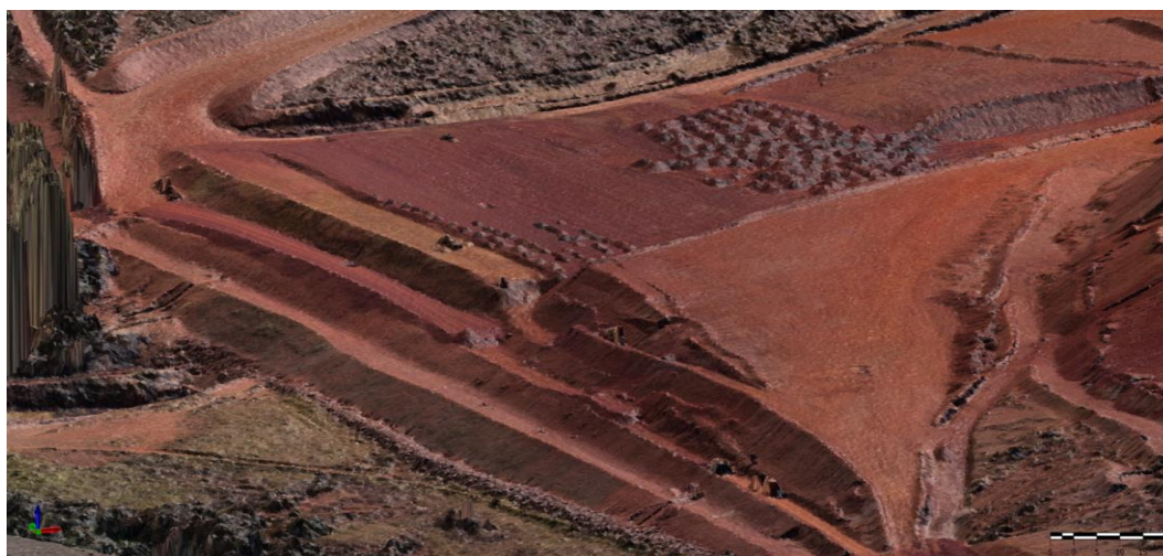
Figura 13: Taludes da deposição ascendente da pilha noroeste . 12/07/2024
