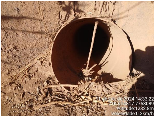
Figura 6-39: entrada da tubulação que sai da ITA-320 em direção à Cava do Dique.
