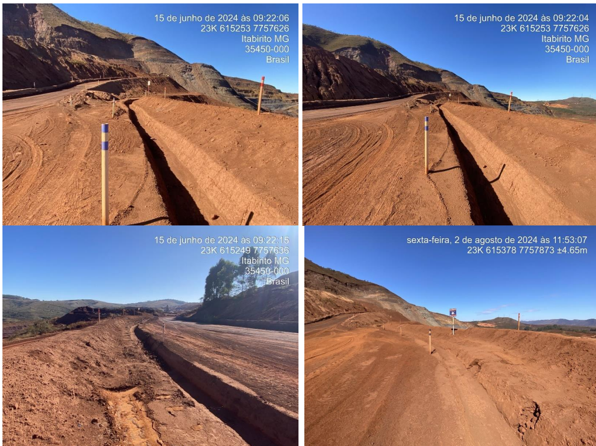
Figura 30: Canaletas de solo apiloado nos taludes remanescentes.
