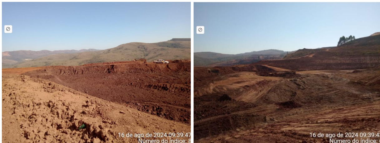
Figura 6-2: Reservatório Seco da Barragem Aredes no trimestre.
