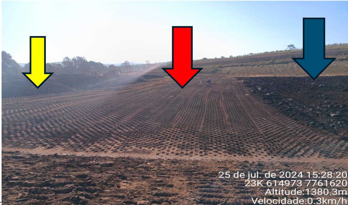
Foto 11: subdivisão da praça 01 conforme atuação dos equipamento.
