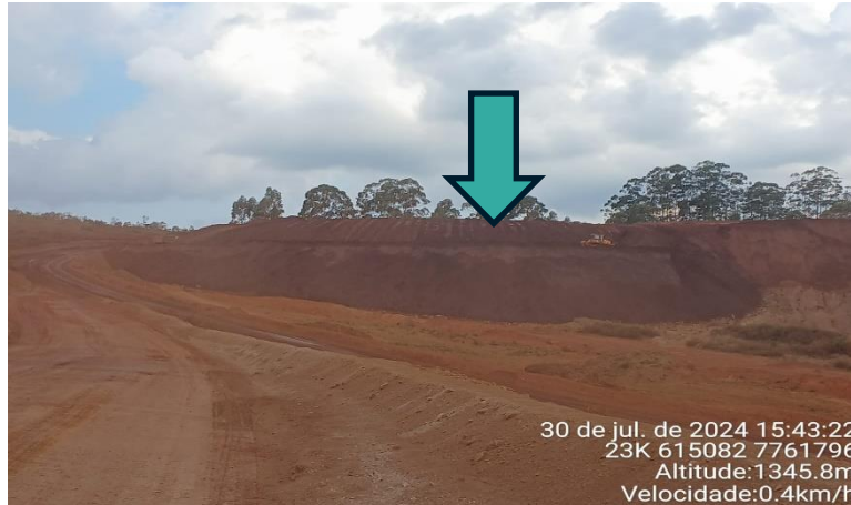
Foto 07: bota-espera na Praça 10 com material proveniente da barragem e rejeito filtrado.
