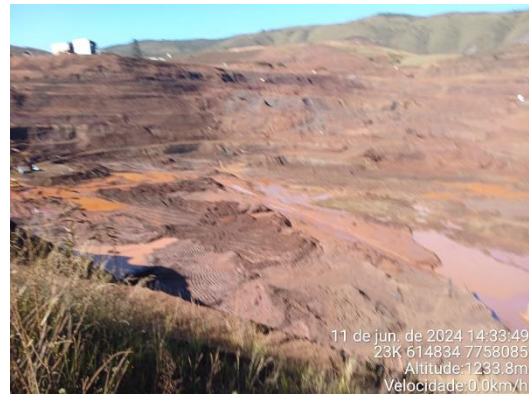
Figura 6-43: fundo da cava do dique.
