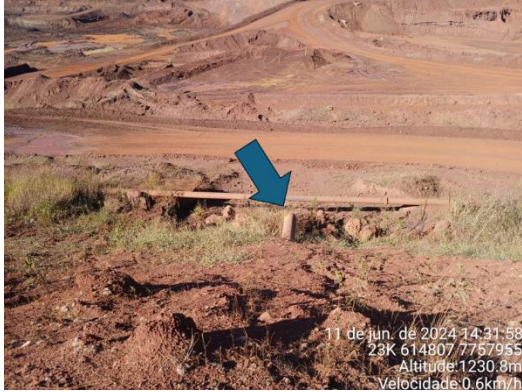
Figura 6-38: tubulação para desaguar da água proveniente da ITA-320 na Cava do Dique.
