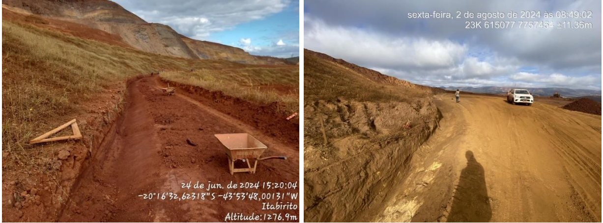
Figura 30: Canaletas de solo apiloado nos taludes remanescentes.
