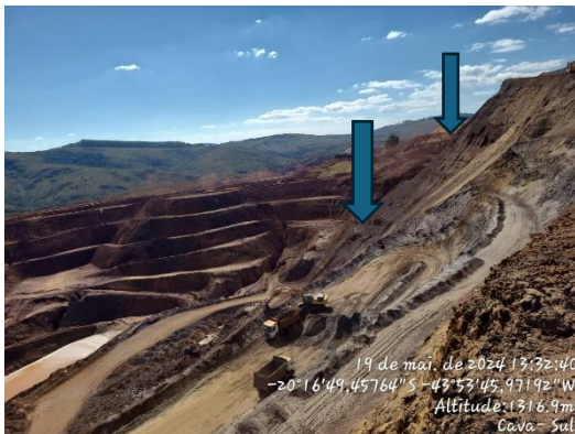
Figura 6-46: fundo da cava sul.
