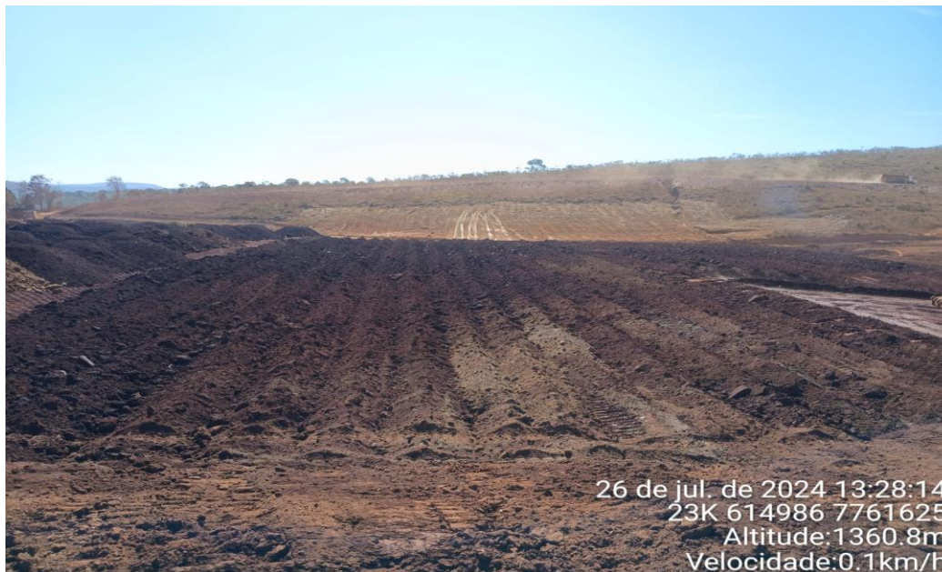
Foto 12: material disposto sob forma de leiras pela motoniveladora em processo de secagem e preparo para nivelamento e compactação.
