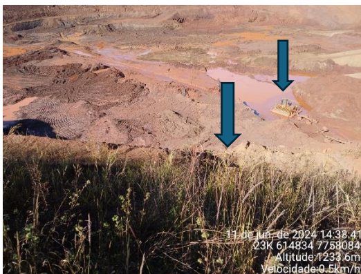
Figura 6-40: desvio pluvial da ITA-320 para o sump da SAFM Mineração com sistema de bombeamento para re-utilização.
