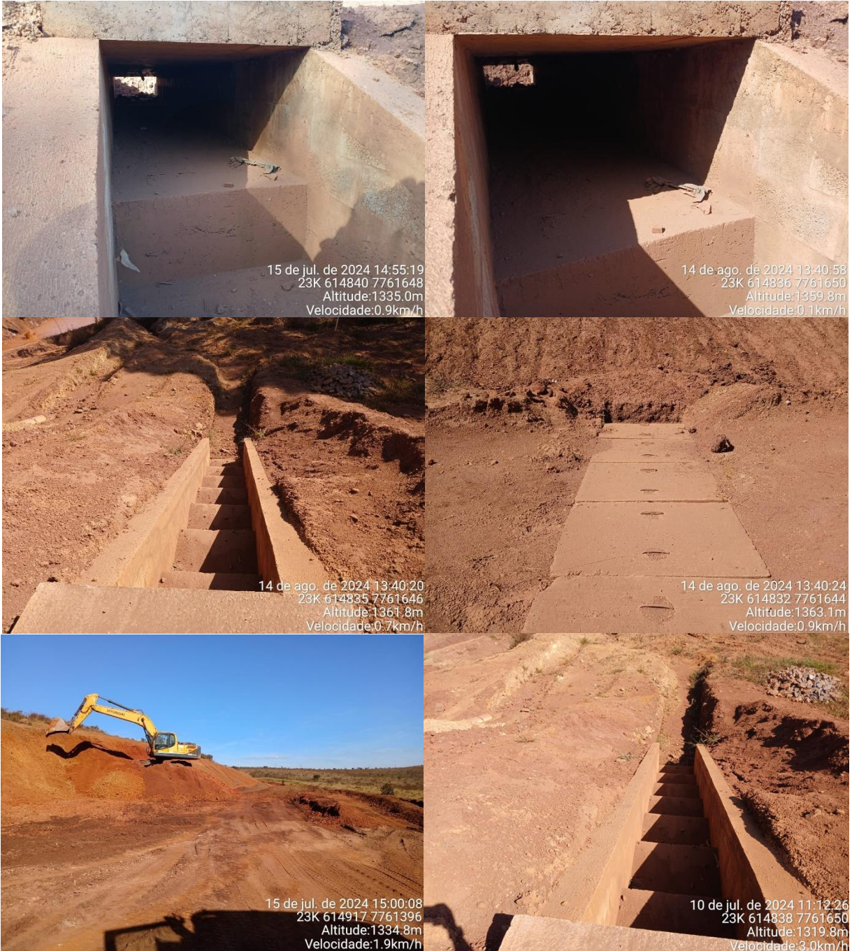
Figura 6-10: manutenção das áreas referentes ao sistema de drenagem da pilha noroeste
