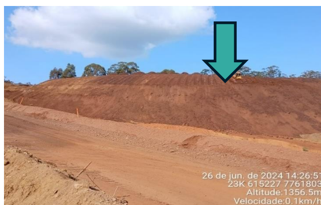
Foto 07: bota-espera na Praça 10 com material proveniente da barragem e rejeito filtrado.
