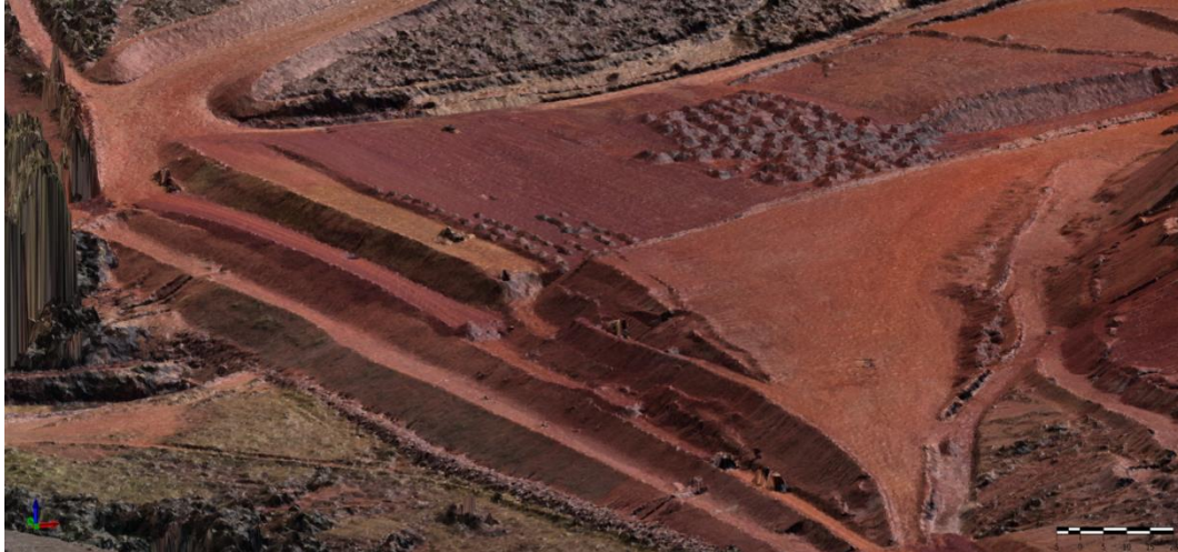
Figura 11: Taludes da deposição ascendente da pilha noroeste . 12/07/2024
