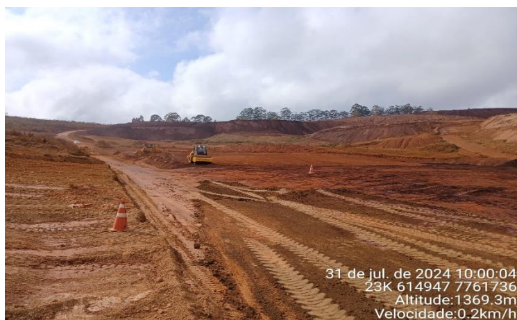
Foto 09: empilhamento de estéril na Praça 06.
