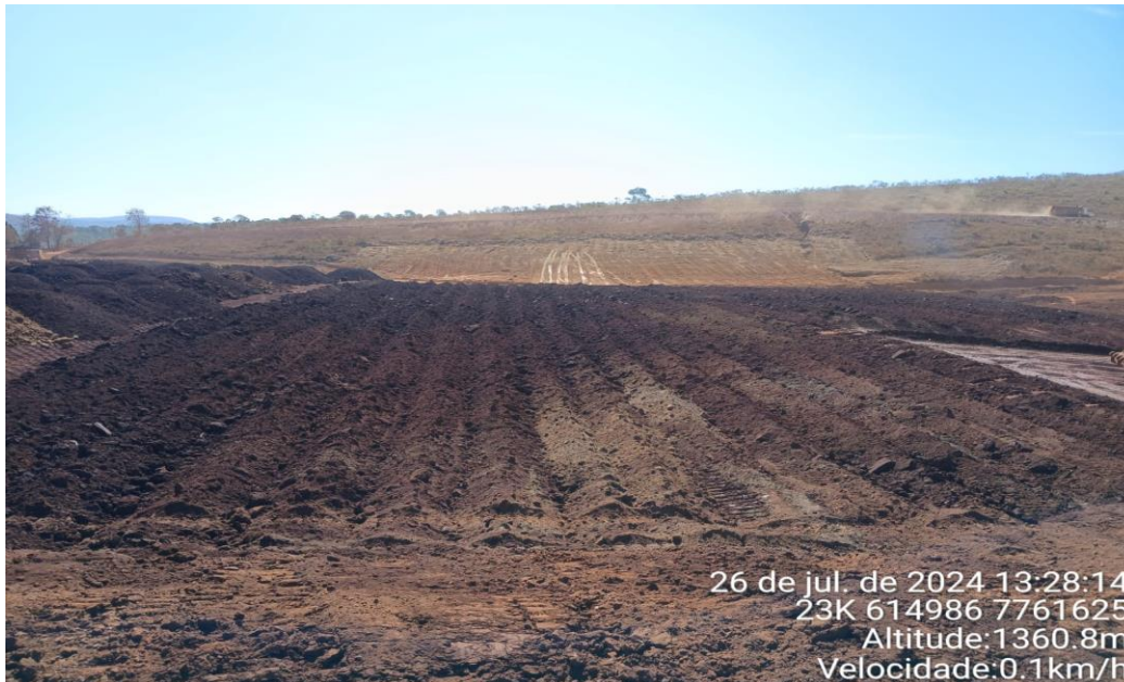
Foto 12: material disposto sob forma de leiras pela motoniveladora em processo de secagem e preparo para nivelamento e compactação.
