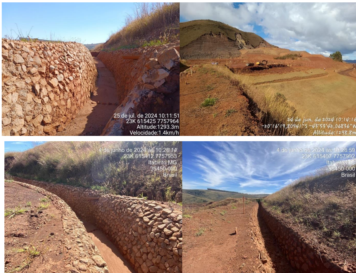
Figura 6-29: Barragem Central – condições do maciço e drenagem
