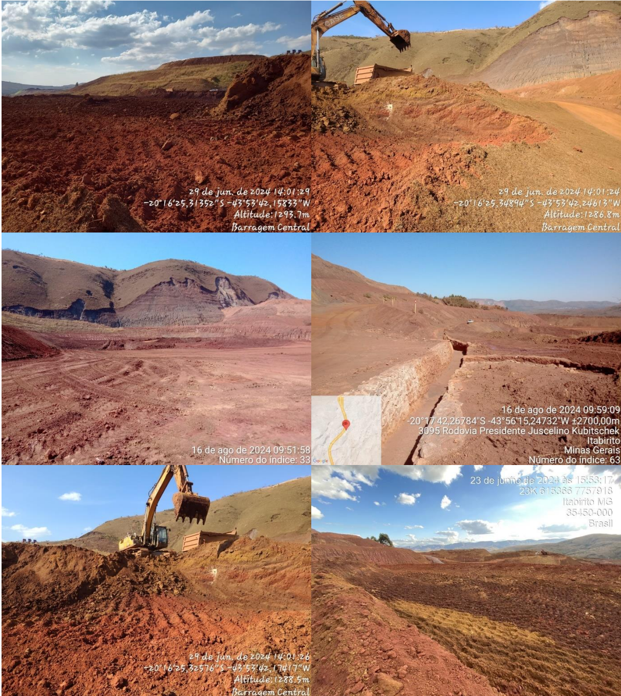
Figura 6-28: Fotografias do reservatório da Barragem Central
