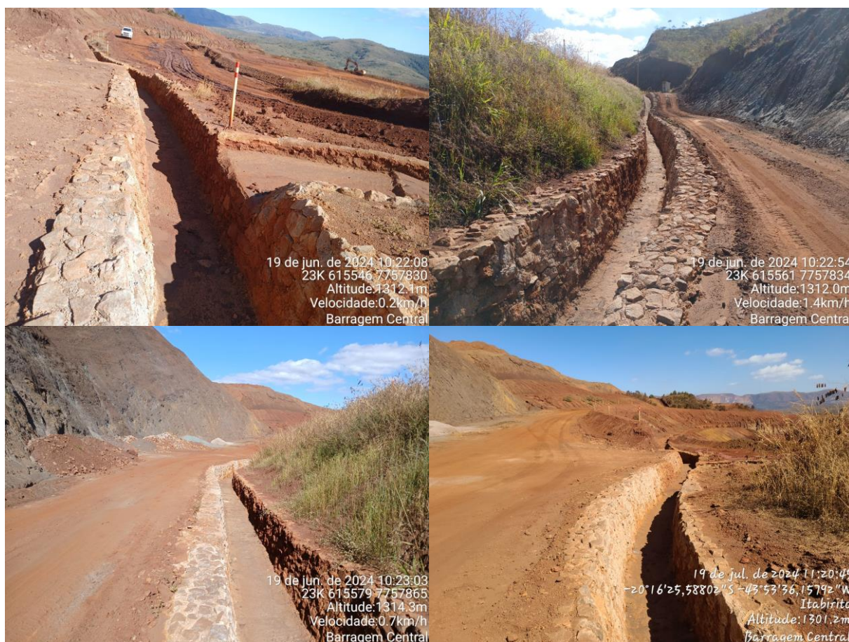
Figura 6-48: Canal de cintura ampliado ao longo que se avançará o processo de remoção da estrutura
