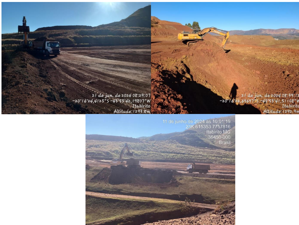
Figura 31: Algumas fotos do processo de remoção da Barragem Central
