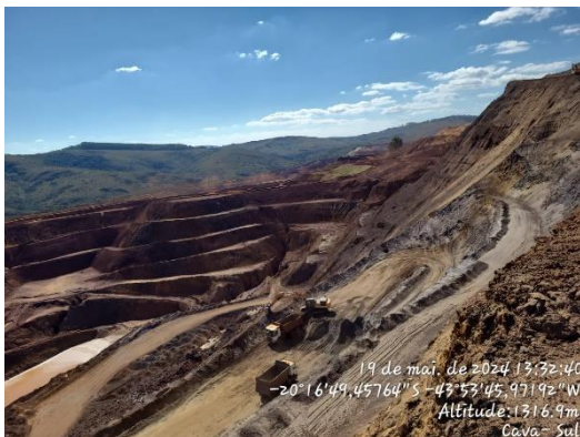
Figura 6-43: fundo da cava sul.
