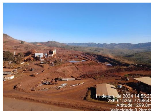
Figura 6-42: fundo da cava do dique.
