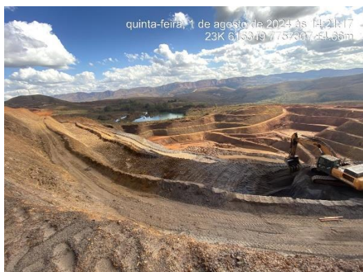
Figura 47: Cava sul. Água pluvial sendo retirada do fundo da cava para aspersão de poeira interna.
