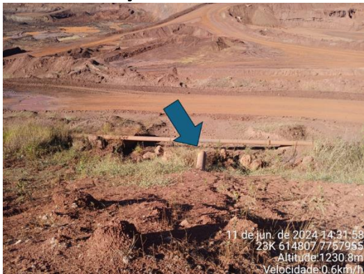
Figura 6-35: tubulação para desague da água proveniente da ITA-320 na Cava do Dique.
