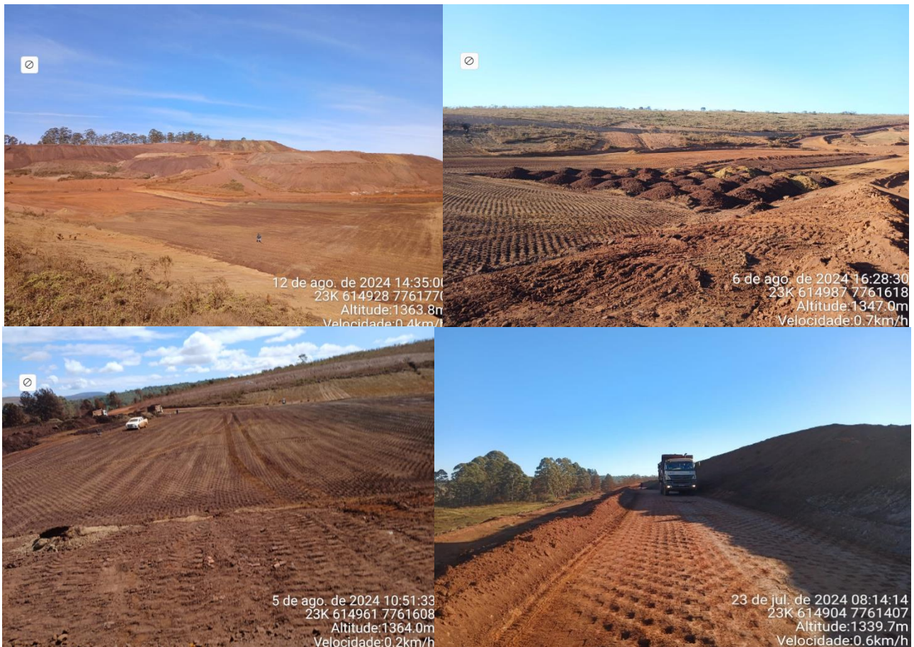
Figura 6: Compactação na pilha noroeste
