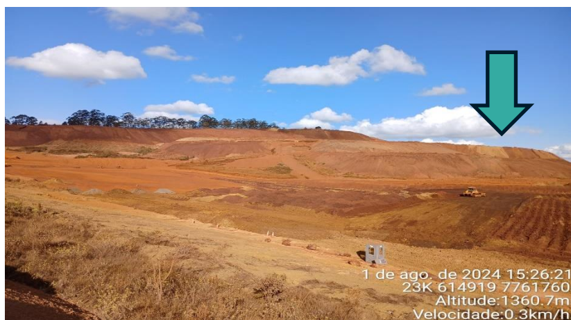
Foto 08: bota-espera de rejeito grosso na Praça 07.
