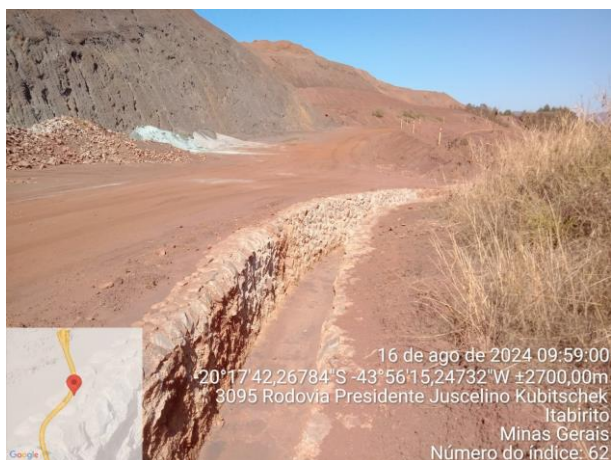
Figura 6-49: Canal de cintura da Barragem Central.
