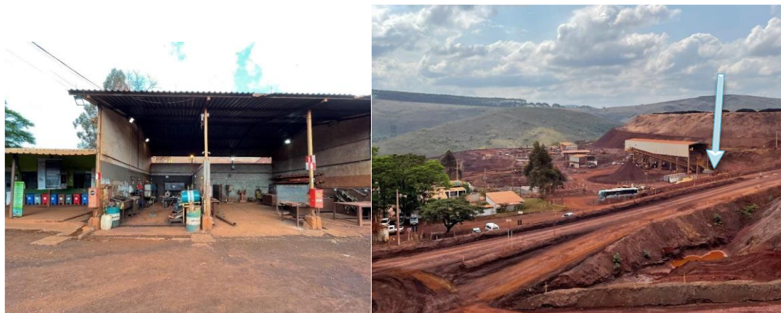
Figura 6-4: Oficina de ferramentaria e armazenamento de óleo lubrificante e oficina ITM B (Seta amarela)
