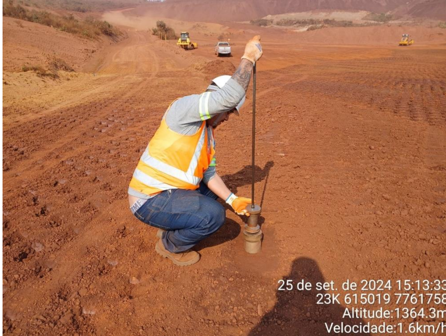
Foto 17: ensaio para determinação de umidade in situ e grau de compactação (Hilf). Componentes: haste guia, martelo de cravação, cabeçote metálico e cilindro biselado.
