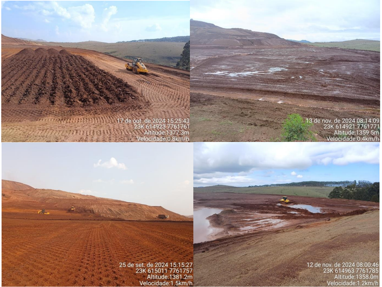
Figura 6: Compactação na pilha noroeste
