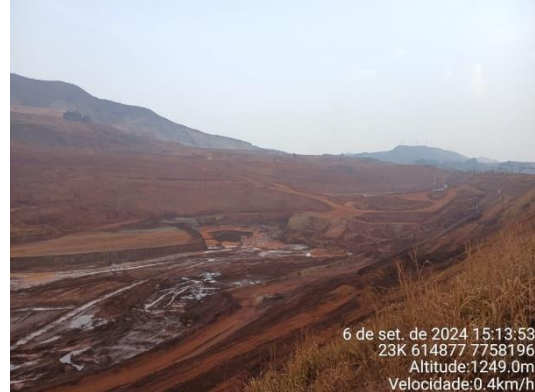
Figura 6-42: Cava do dique vista pela ITA-320.
