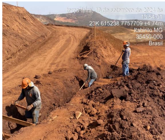
Figura 29: Canaletas de solo apiloado nos taludes remanescentes.
