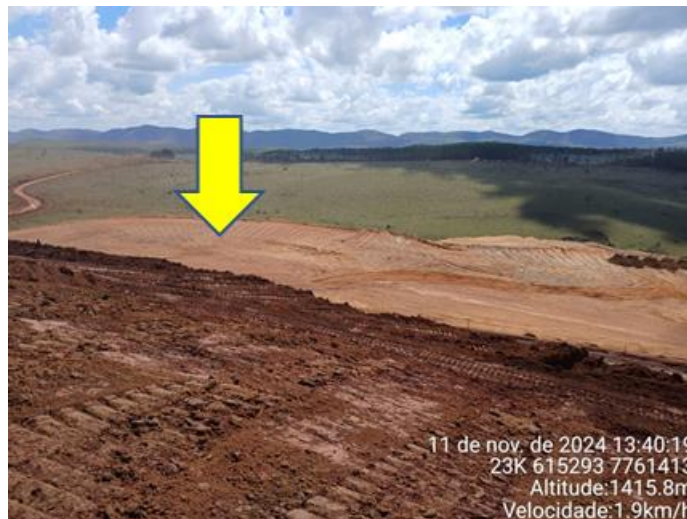
Foto 08: bota-espera de rejeito grosso na Praça 07.
