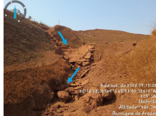
Figura 6-52: Saída da drenagem do extravasor principal da Barragem Aredes para o dique a jusante.
