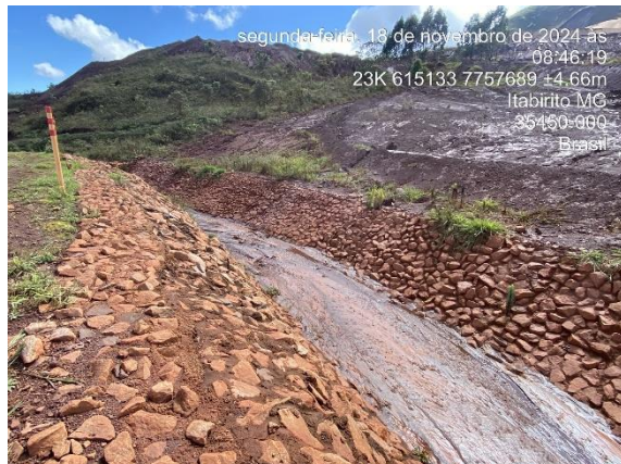
Figura 29: Canaletas de solo apiloado nos taludes remanescentes.
