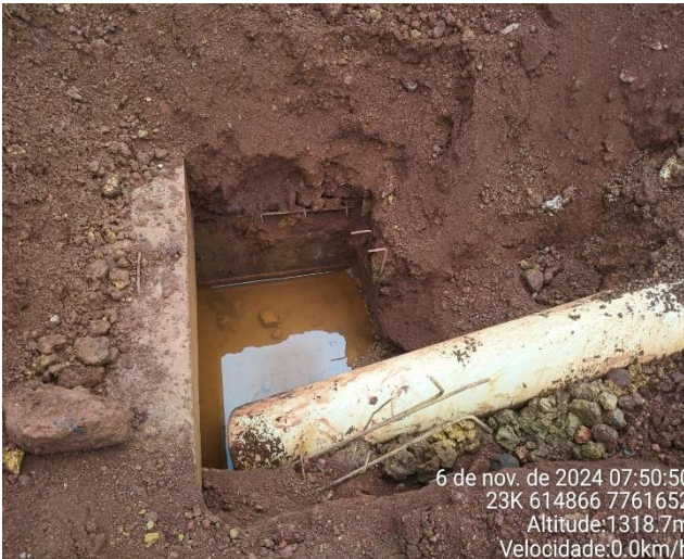
Figura 70: construção de drenagem temporária de direcionamento de água pluvial nas faces do talude.
