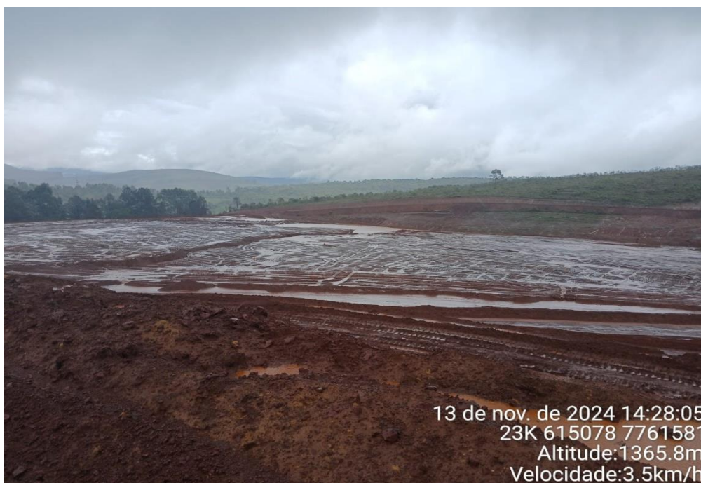
Foto 12: sistema de drenagem da praça 01 (com controle tecnológico).
