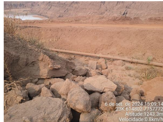
Figura 6-44: Enrocamento da ITA-320 que desagua em direção à cava do dique.
