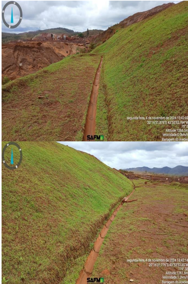
Figura 31: Talude remanescentes em boas condições e com vegetação devidamente plantada
