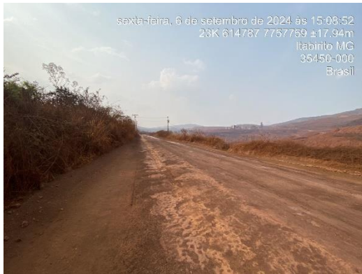
Figura 6-46: ITA-320 em boas condições
