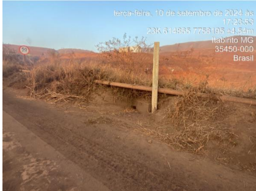
Figura 6-51: Bueiro que sai da ITA-320 para o fundo da cava do dique.
