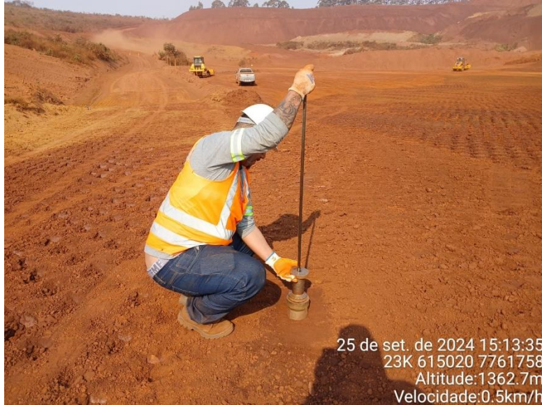
Foto 16: laboratorista terceirizado realizando ensaio de compactação (Hilf) a fim de liberação de camada.
