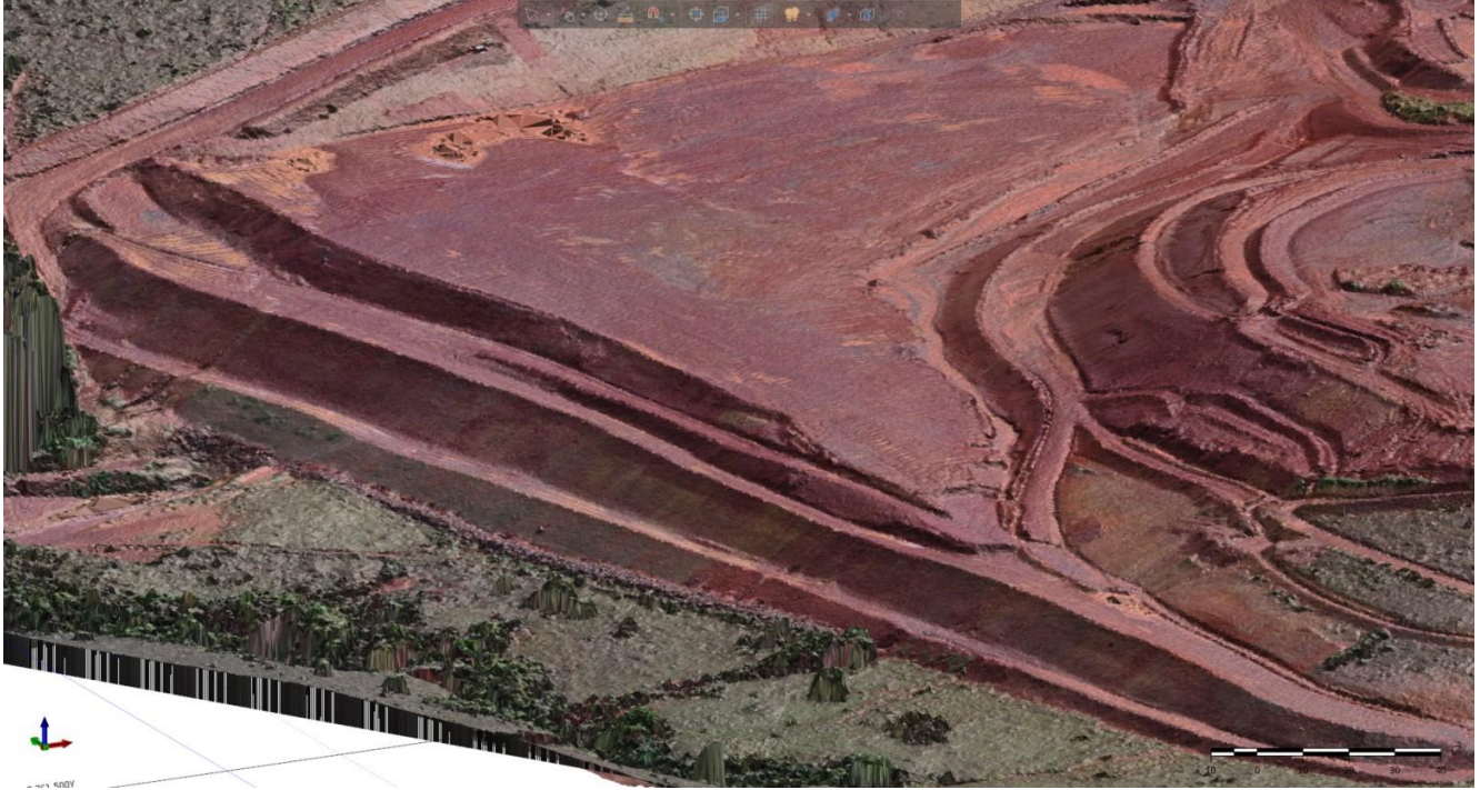
Figura 11: Taludes da deposição ascendente da pilha Noroeste. 15/11/2024.
