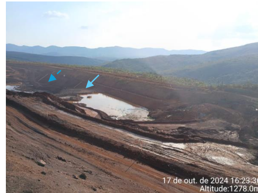
Figura 6-48:Parte da cava adjacente a usina de ITM. O local onde há tubulação é destacado por uma seta branca
