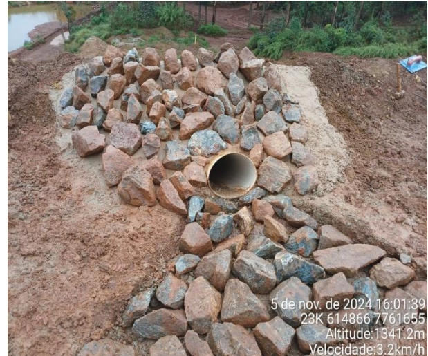
Figura 70: construção de drenagem temporária de direcionamento de água pluvial nas faces do talude.
