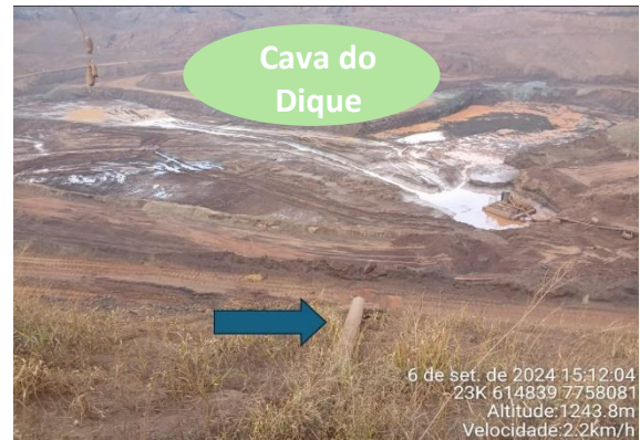
Figura 6-38: Cava do dique e tubo (seta azul).
