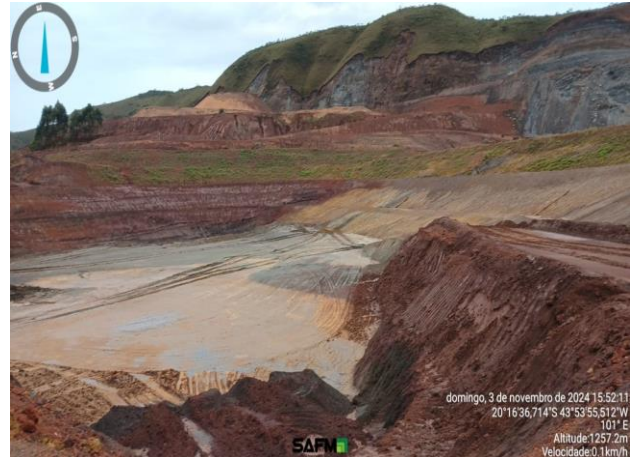
Figura 6-20: Remoção do maciço ao longo do trimestre
