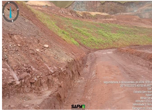
Figura 29: Canaletas de solo apiloado nos taludes remanescentes.
