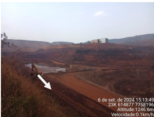
Figura 6-41: Local onde existia o dique longitudinal e atualmente é o fundo da cava do dique.
