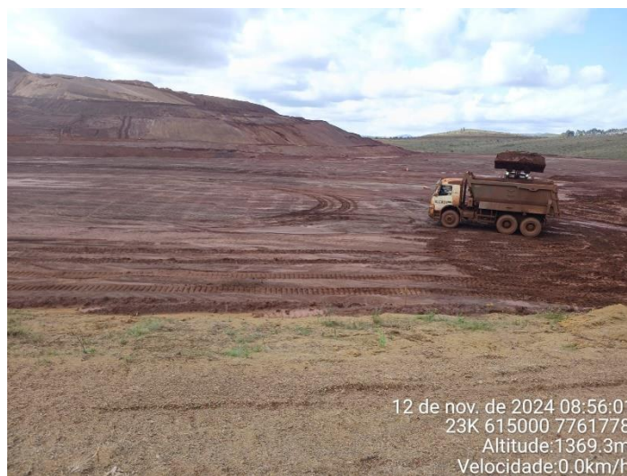
Foto 09: basculamento de material na praça 01 (com controle tecnológico).
