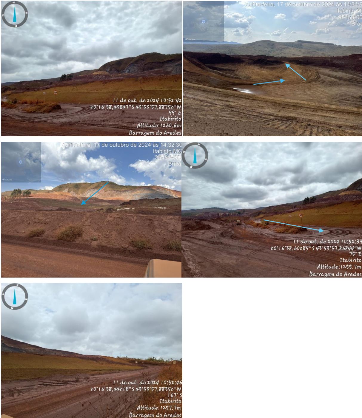
Figura 6-10: Direcionamento da água para saída da antiga estrutura da Barragem Aredes para cava a jusante;
