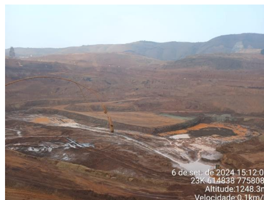
Figura 511: Sump (fundo da cava do dique) com a água pluvial sendo retida.
