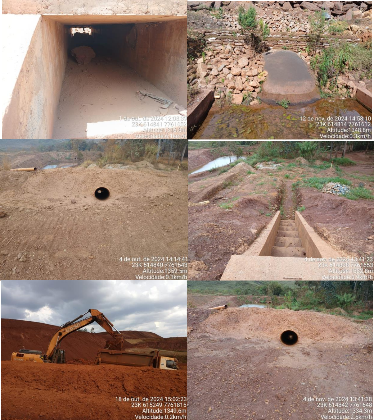
Figura 6-6: manutenção das áreas referentes ao sistema de drenagem da pilha noroeste
