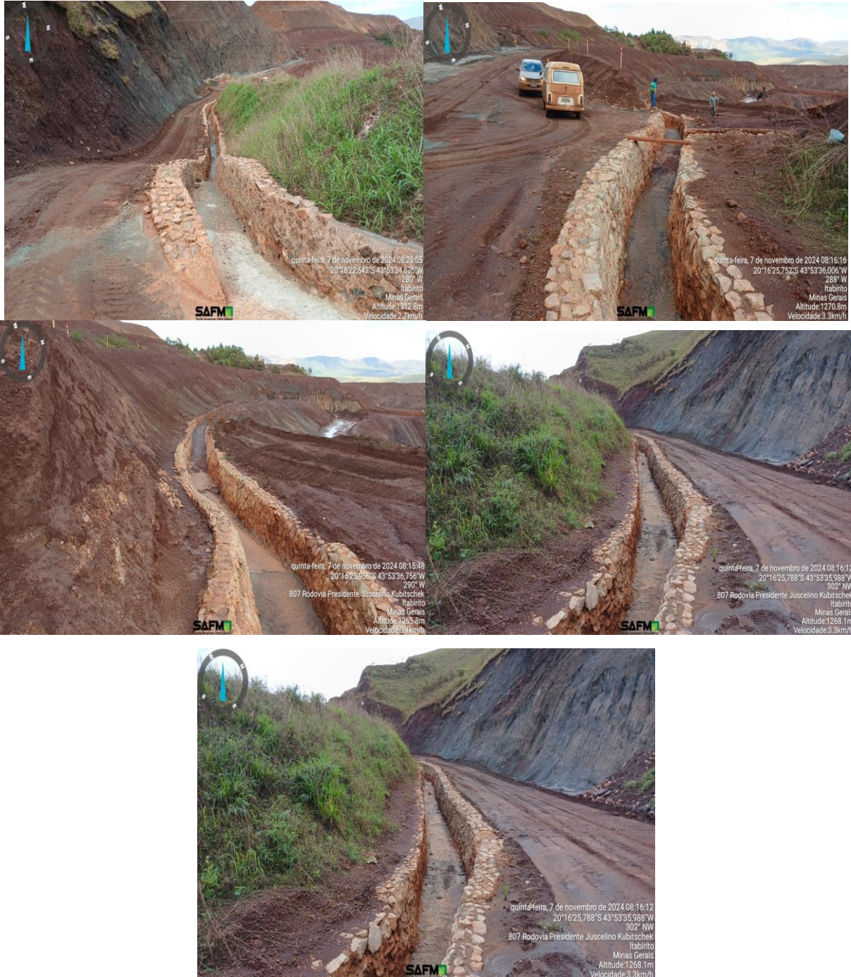
Figura 6-30: Canal de cintura da Barragem Central.
