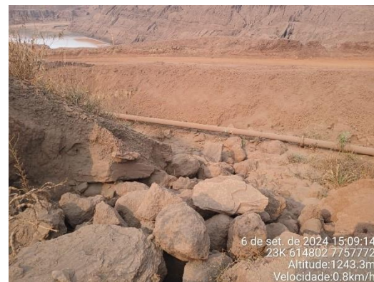
Figura 510: Enrocamento da ITA-320 que desagua em direção à cava do dique.
