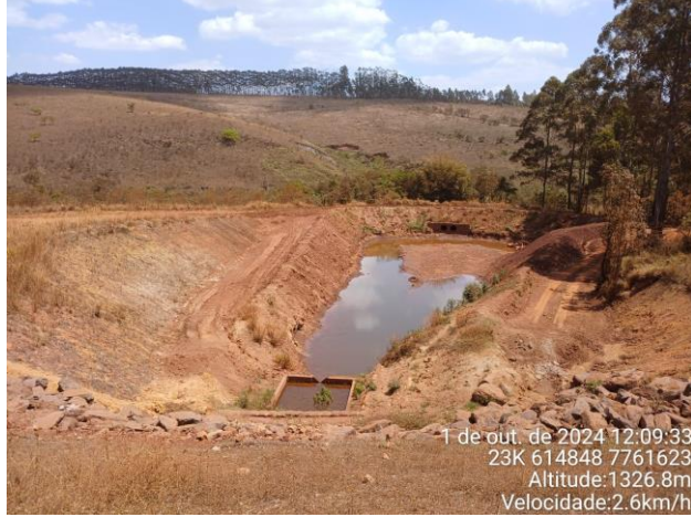
Figura 6-8: Sump e dreno de fundo com saída de água límpida– Pilha Noroeste
