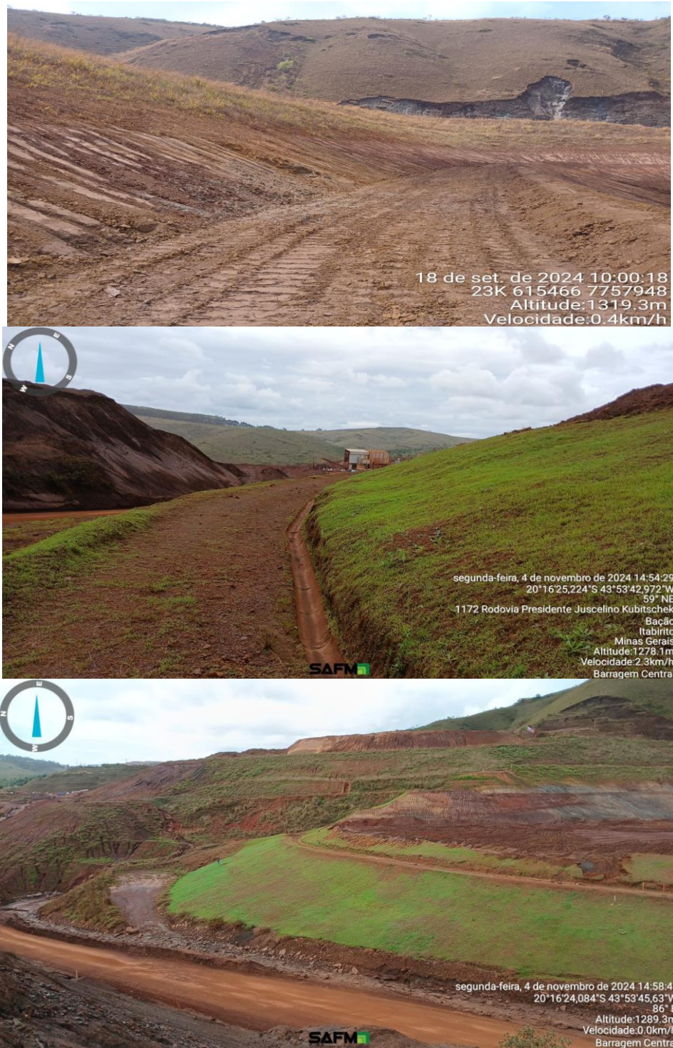
Figura 6-1: vegetação nos taludes remanescentes da Barragem Central.
