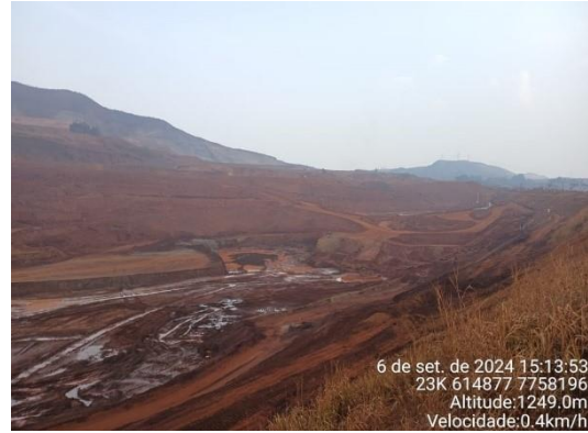
Figura 58: Cava do dique vista pela ITA-320.
