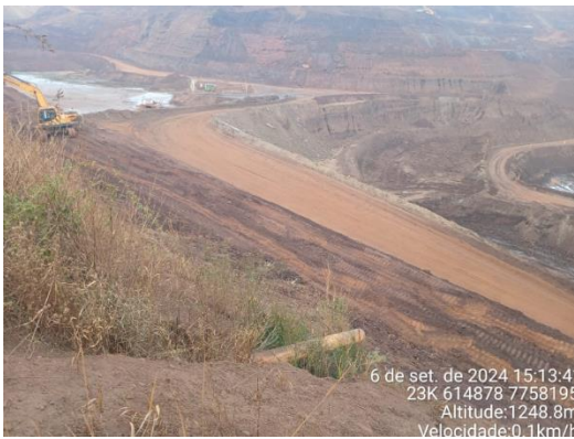
Figura 56: Encanamento direcionando a pluviometria da estrada para a cava do dique.
