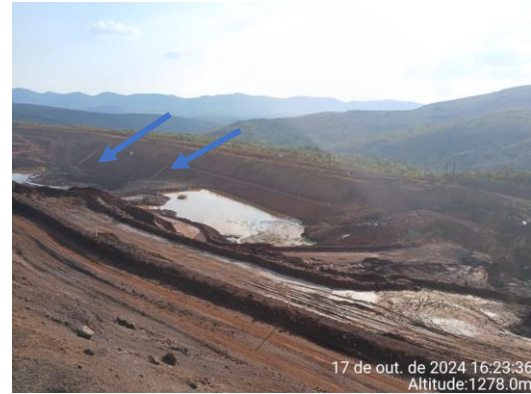
Figura 514: Parte da cava adjacente a usina de ITM. O local onde há tubulação é destacado por uma seta azul.
