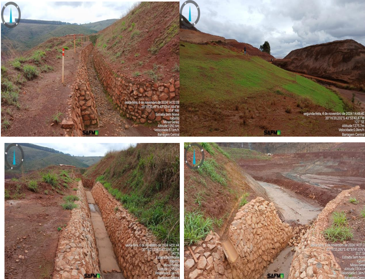
Figura 6-25: Barragem Central – condições do maciço e drenagem
