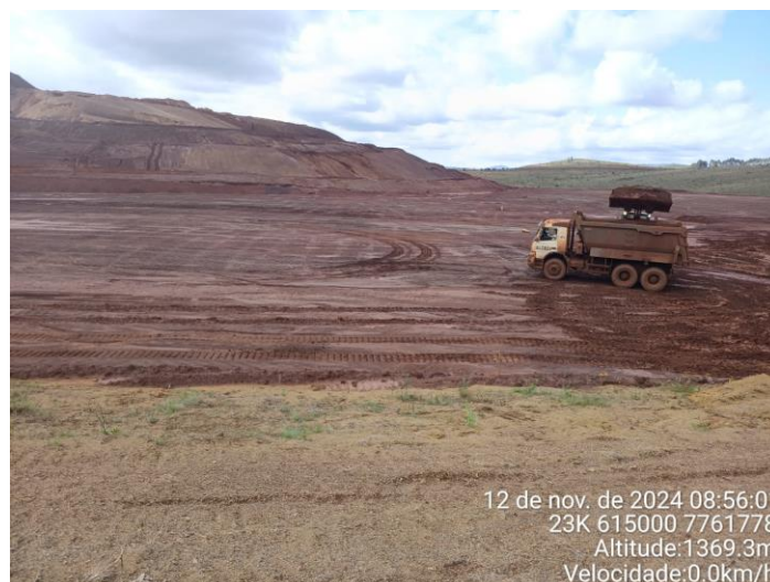
Foto 09: basculamento de material na praça 01 (com controle tecnológico).
