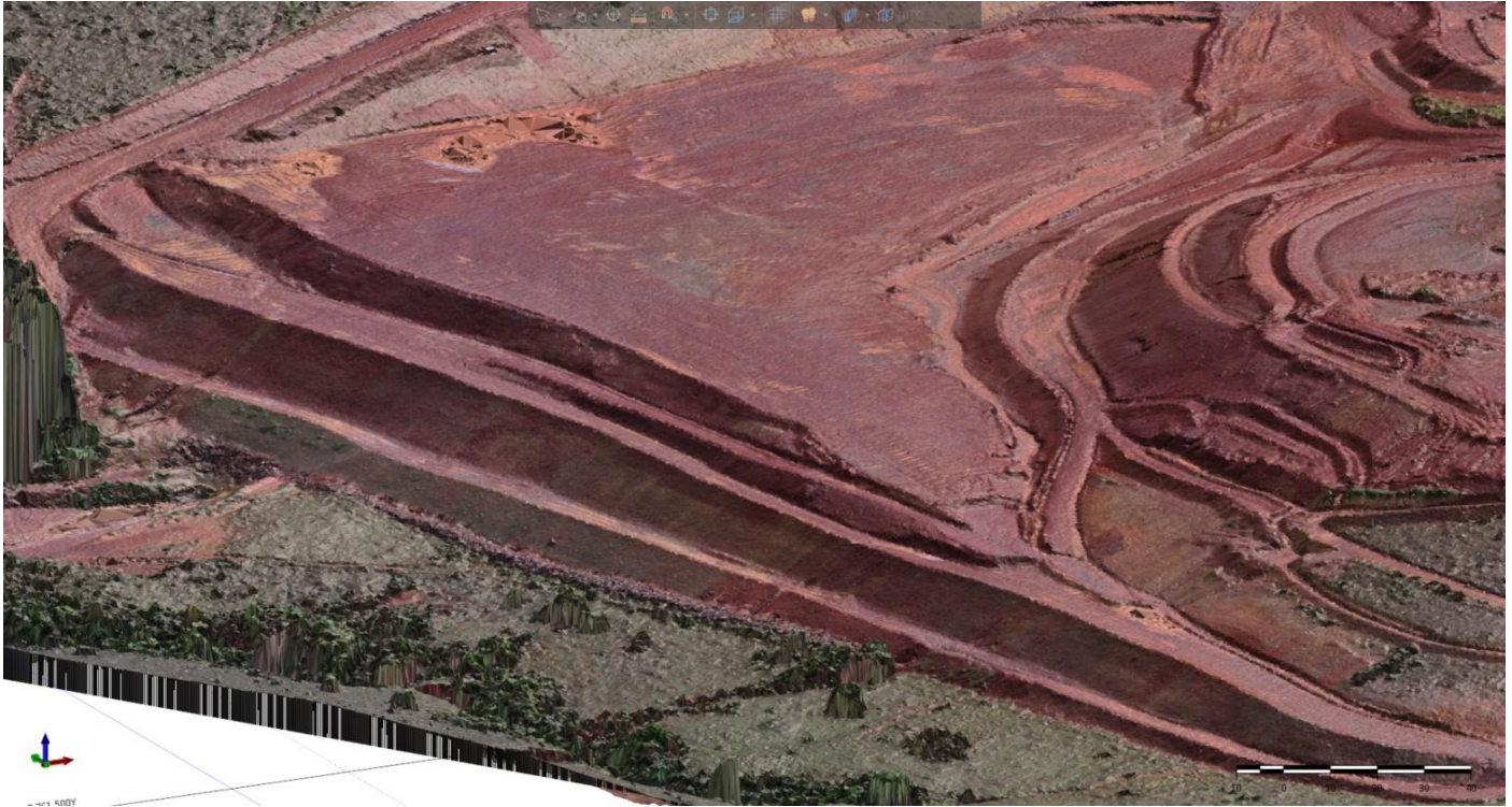
Figura 7: Taludes da deposição ascendente da pilha noroeste . 15/11/2024.
