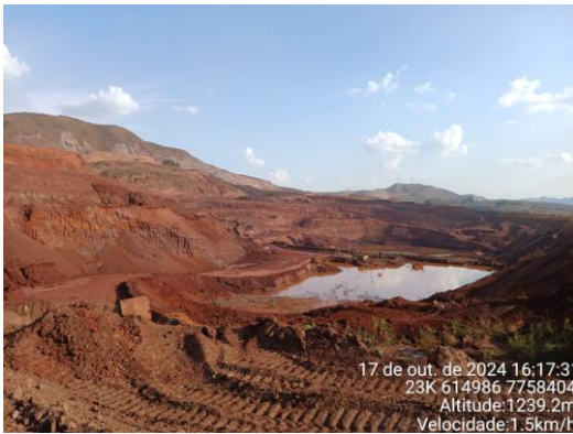
Figura 513: Condições da antiga cava laninha, atual expansão da cava do dique.
