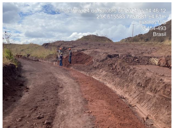
Figura 32: manufatura dos sistemas de drenagem da Barragem Central ao longo do trimestre.
