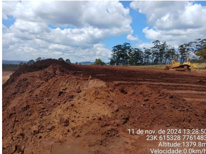
Foto 07: bota-espera na Praça 08 com material proveniente da barragem e rejeito filtrado.
