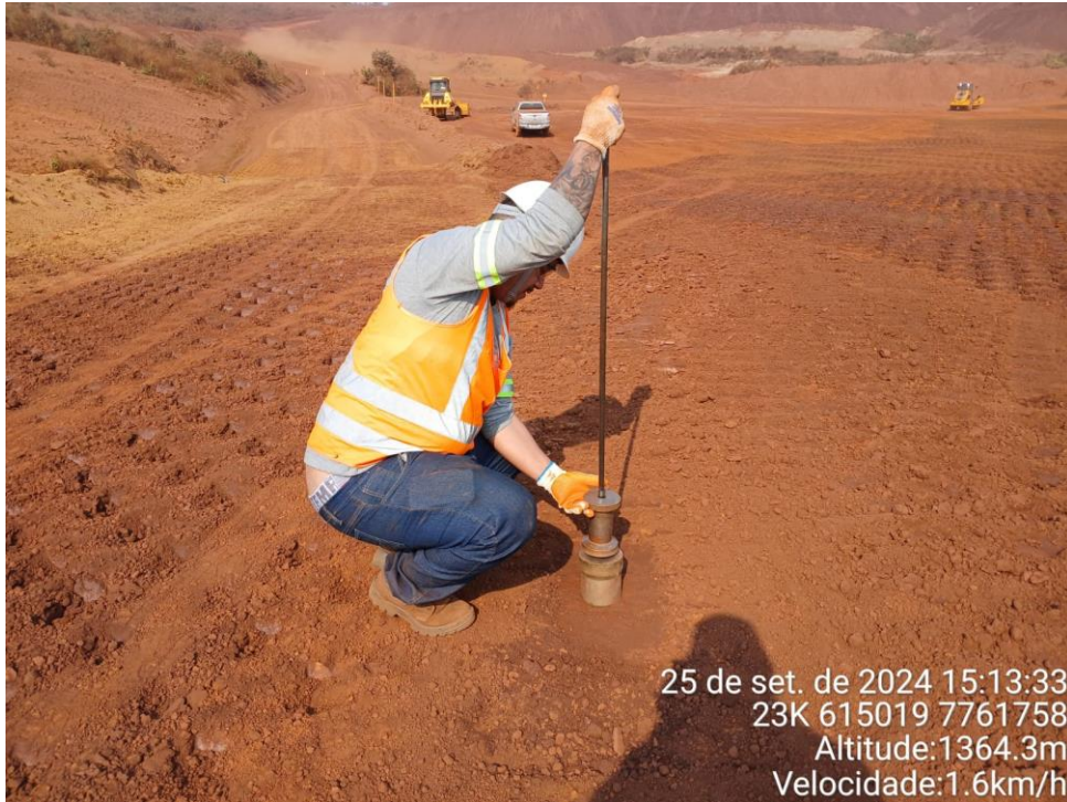
Foto 17: ensaio para determinação de umidade in situ e grau de compactação (Hilf). Componentes: haste guia, martelo de cravação, cabeçote metálico e cilindro biselado.
