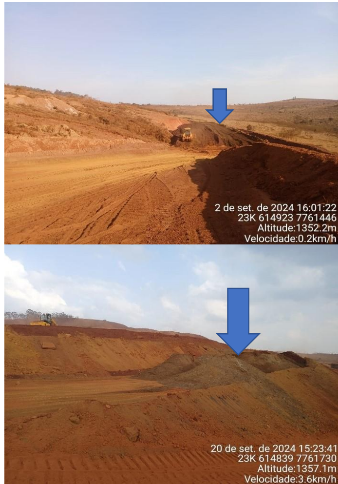
Foto 10: basculamento de estéril nas bermas das praças 03 e 01, respectivamente.
