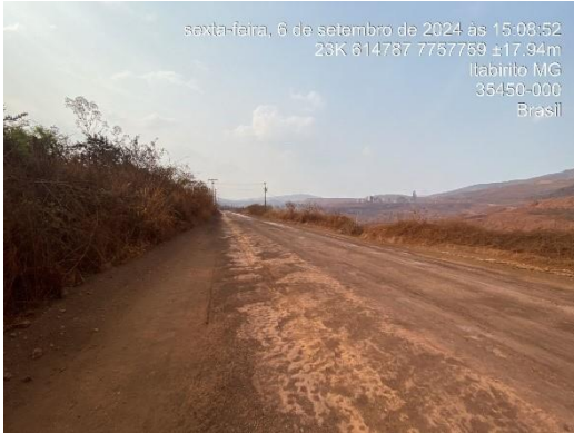
Figura 512: ITA-320 em boas condições
