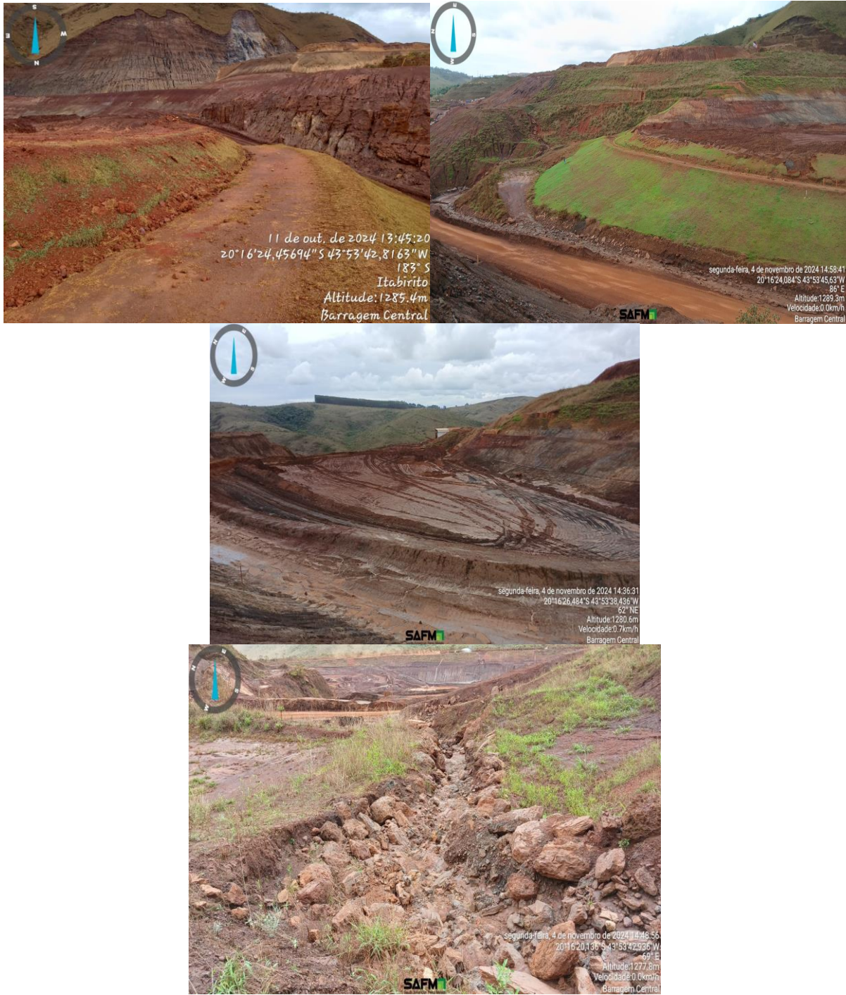
Figura 6-17: Situação geral da estrutura ao longo do trimestre.
