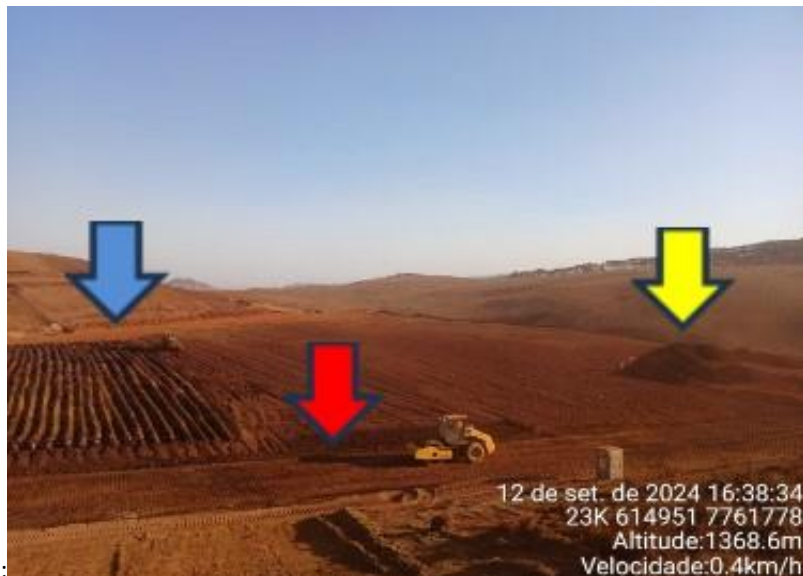
Foto 12: subdivisão da praça 01 conforme atuação dos equipamento.
