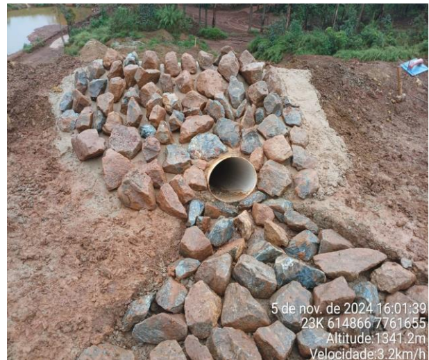
Figura 70: construção de drenagem temporária de direcionamento de água pluvial nas faces do talude.
