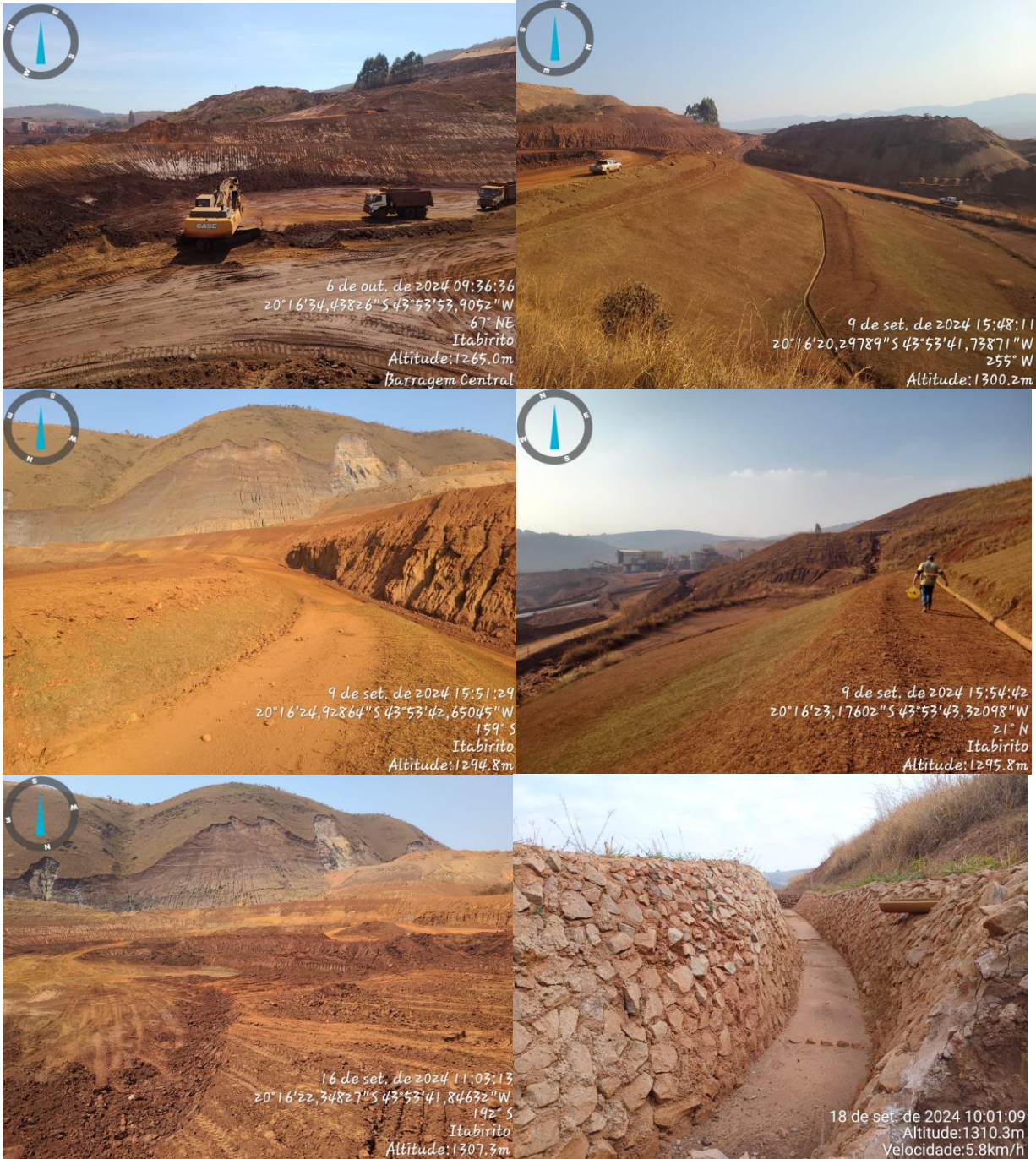
Figura 6-24: Fotografias do reservatório da Barragem Central
