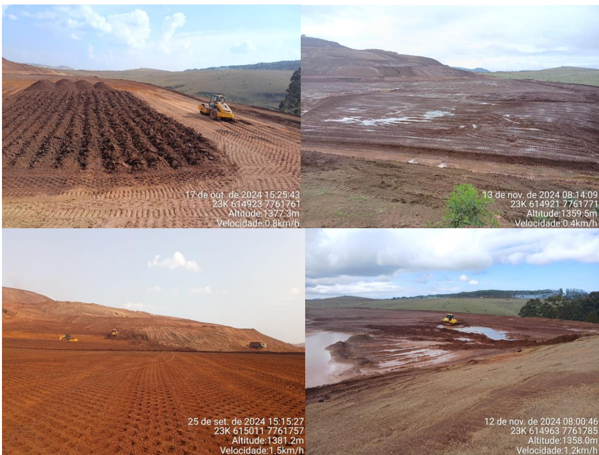
Figura 3: Compactação na pilha noroeste
