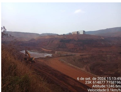
Figura 57: Local onde existia o dique longitudinal e atualmente é o fundo da cava do dique.
