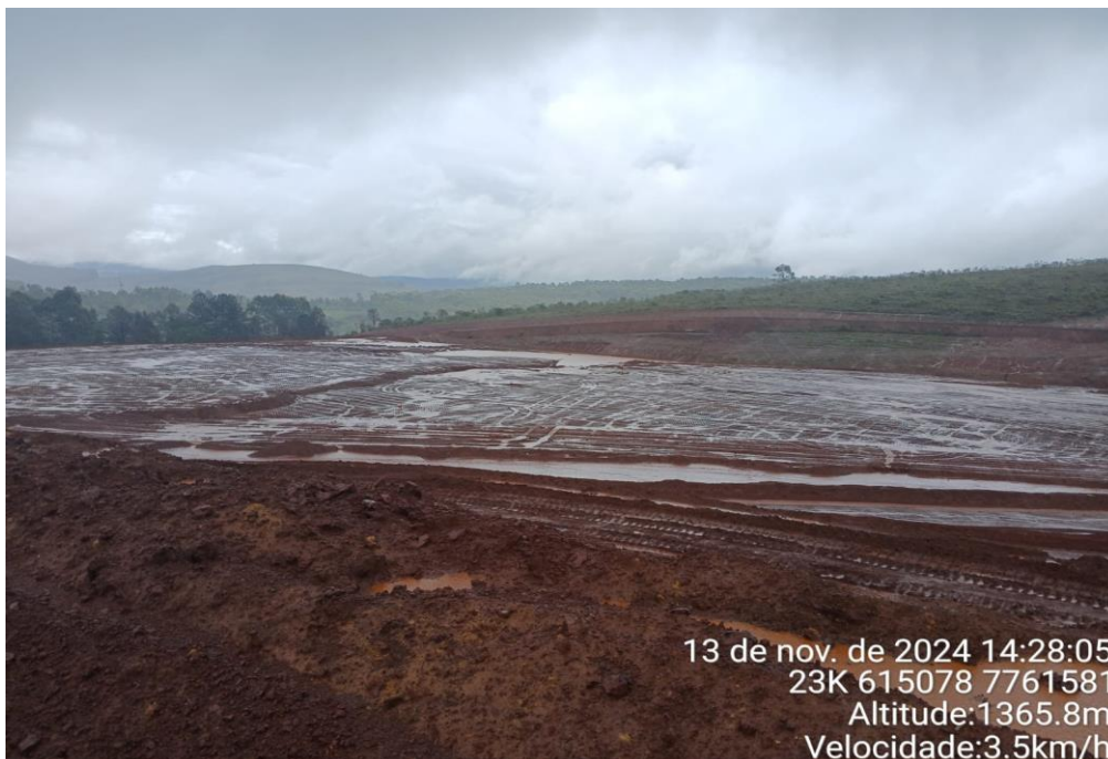
Foto 12: sistema de drenagem da praça 01 (com controle tecnológico).
