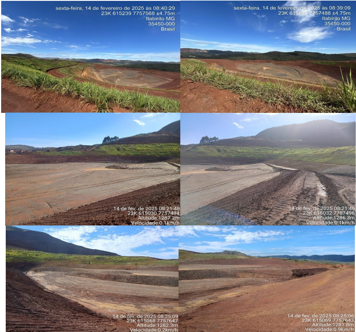
Figura 8: Remoção do barramento e rejeito ao longo do processo de descaracterização nesse trimestre.
