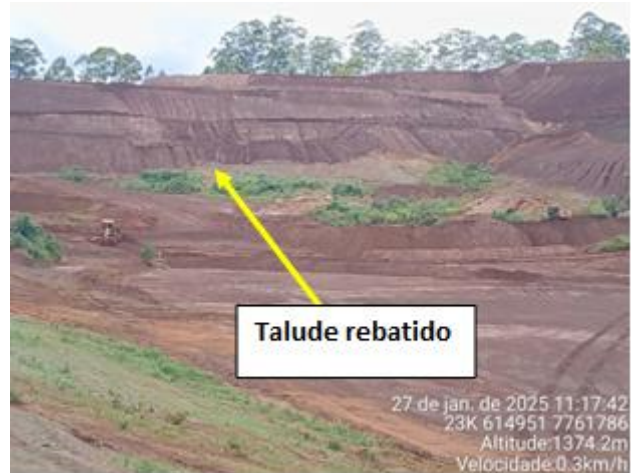
Foto 23: correção da erosão na praça 10.
