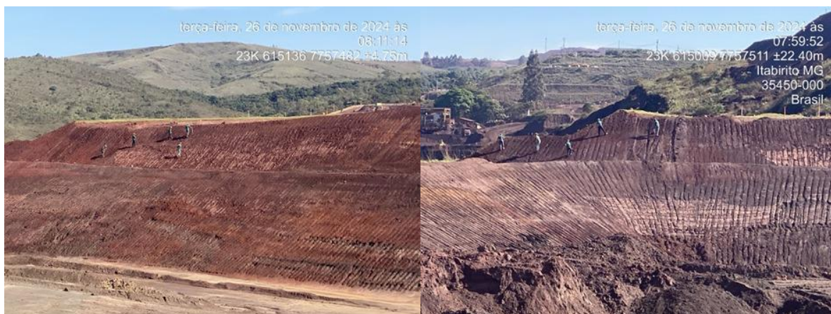
Figura 5: Vegetação implantada no talude remanescente da Barragem Aredes.
