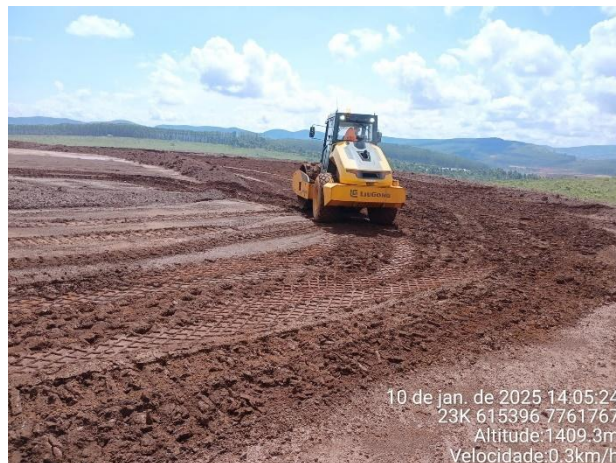
Foto 24: correção de trinca em berma da praça 10.
