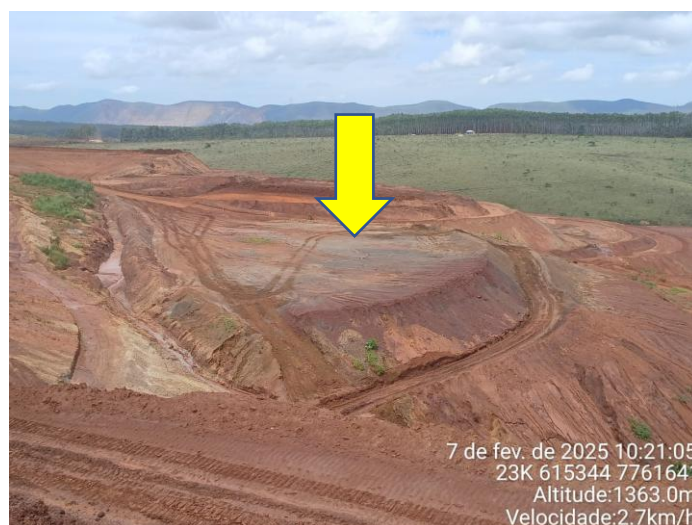
Foto 09: empilhamento de estéril na Praça 06.
