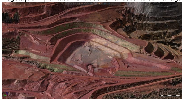
Figura 6: Início da remoção do maciço da Barragem Aredes. Dezembro de 2024.
