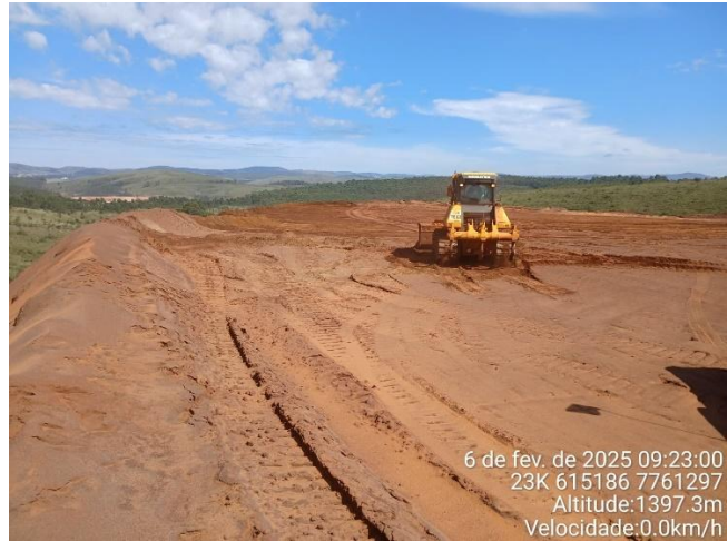
Foto 17: bota-espera de rejeito grosso na Praça 07.
