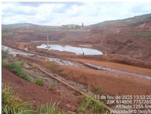
Figura 6-43: Cava do dique vista pela ITA-320.
