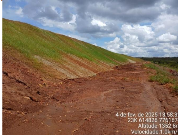
Foto 25: desenvolvimento vegetativo da hidrossemeadura na face do talude (cotas: 1330m a 1340m.).
