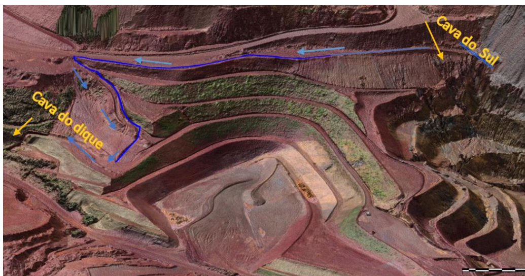
Figura 12: Canal off set redirecionando a água de montante para a cava do dique e para a cava sul.
