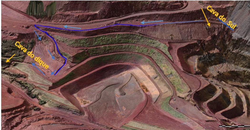
Figura 9: Canal off set redirecionando a água de montante para a cava do dique e para a cava sul.
