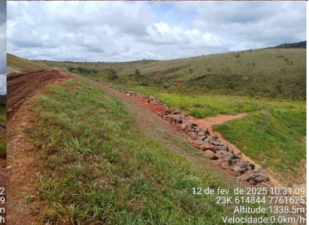
Foto 25: desenvolvimento vegetativo da hidrossemeadura na face do talude (cotas: 1330m a 1340m.).
