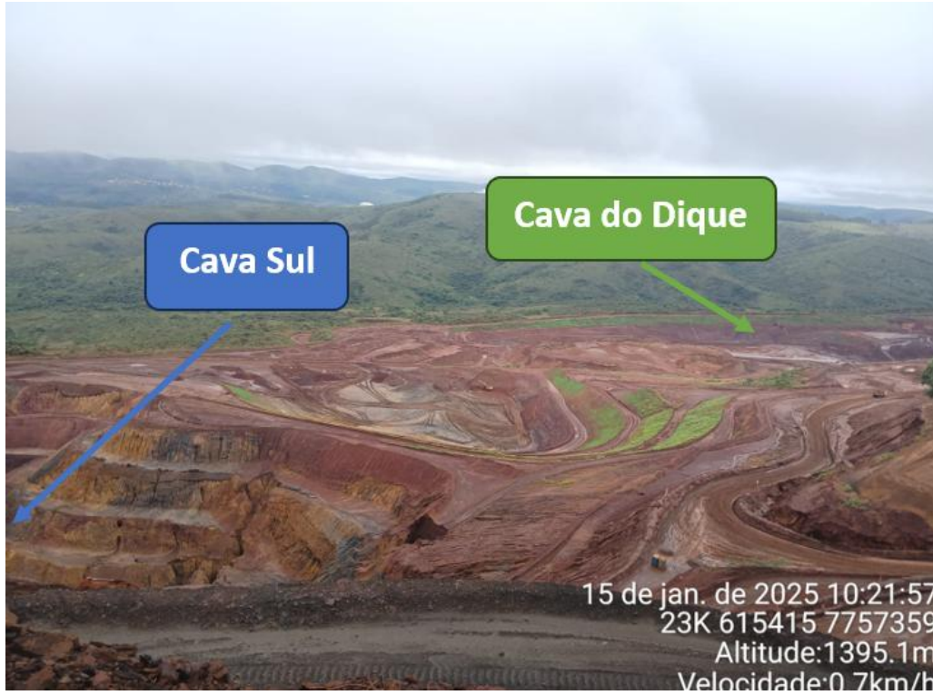
Figura 6-36: Duas cavas para as quais as águas pluviais são direcionadas na mina ponto
