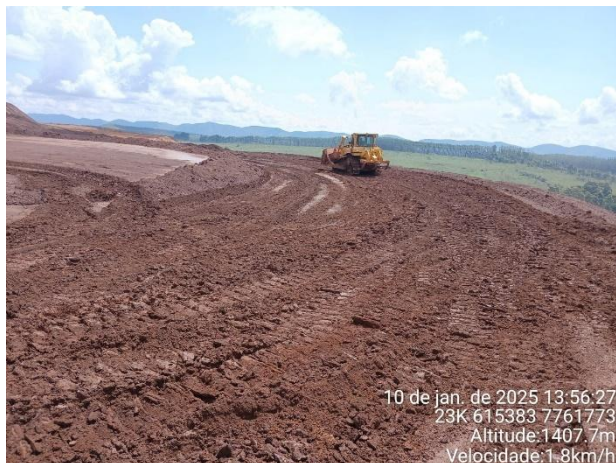
Foto 24: correção de trinca em berma da praça 10.
