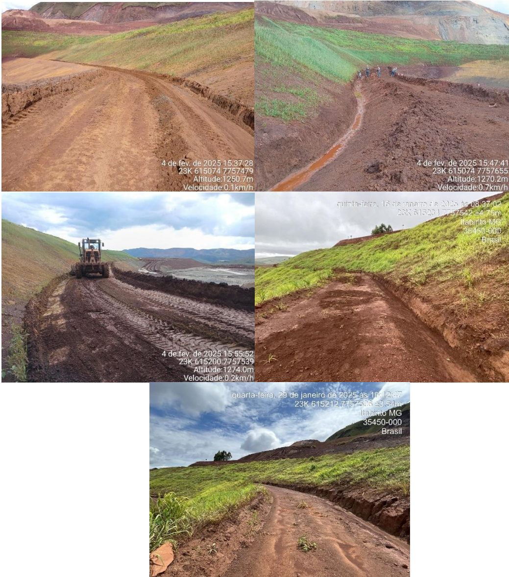
Figura 27: canaletas de solo apiloado nos taludes remanescentes.
