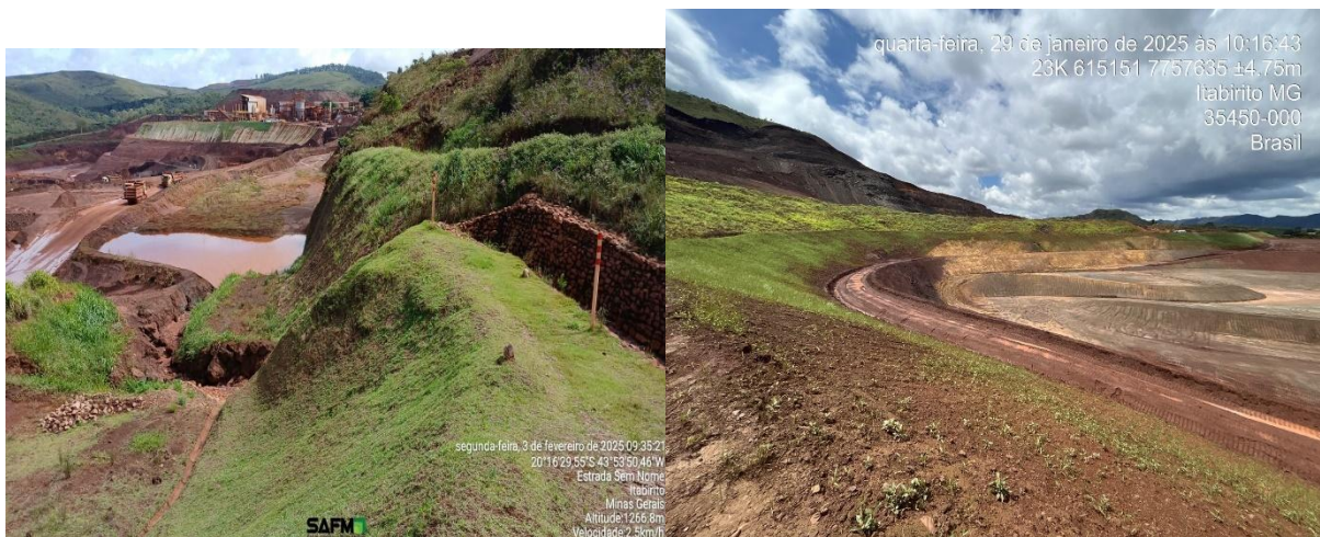
Figura 29: Talude remanescentes em boas condições e com vegetação devidamente plantada
