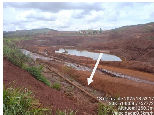
Figura 6-41: Encanamento direcionando a pluviometria da estrada para a cava do dique.
