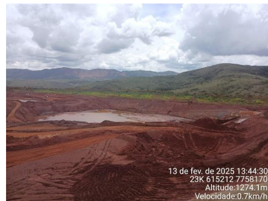
Figura 6-40: Cava do dique.
