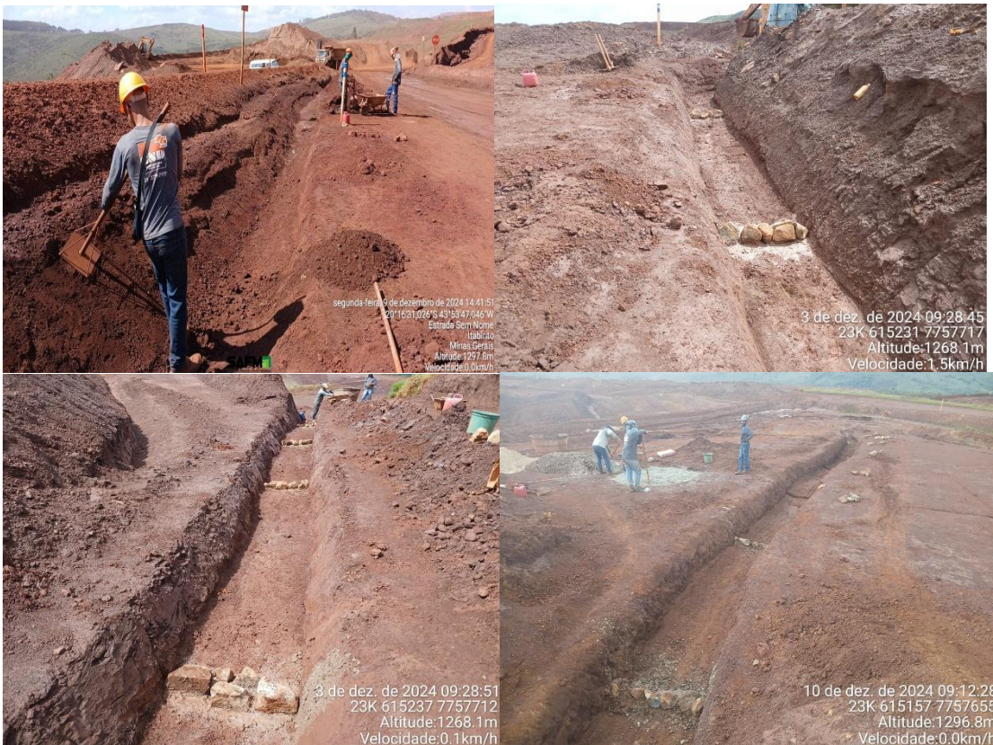
Figura 10: Finalização do canal off set.
