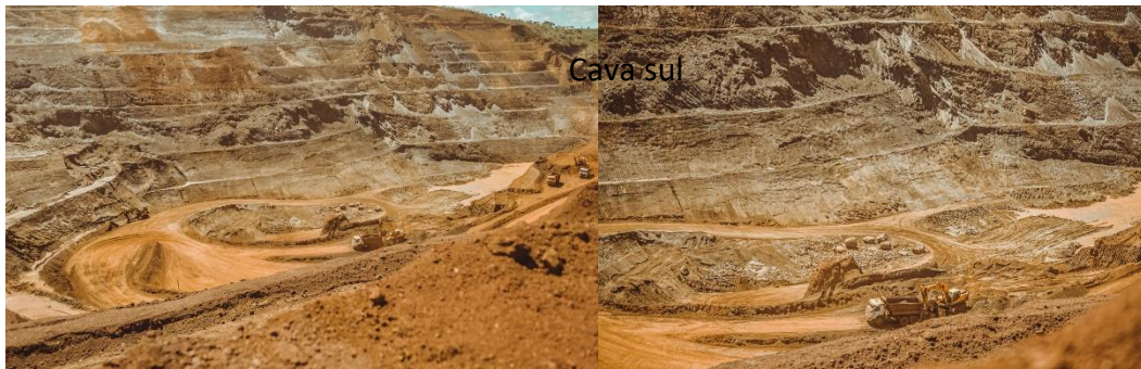
Figura 6-55: Cava sul. Sump para onde a água da barragem Aredes é desviada.
