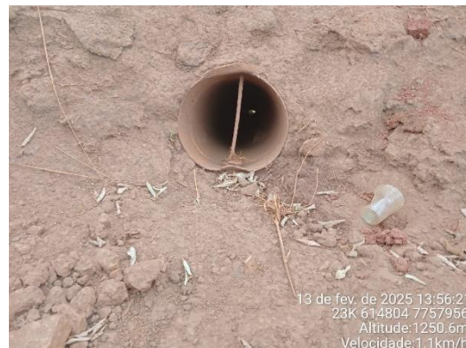
Figura 6-52: Tubo que sai da ITA-320 para o fundo da cava do dique com proteção de sedimentos.
