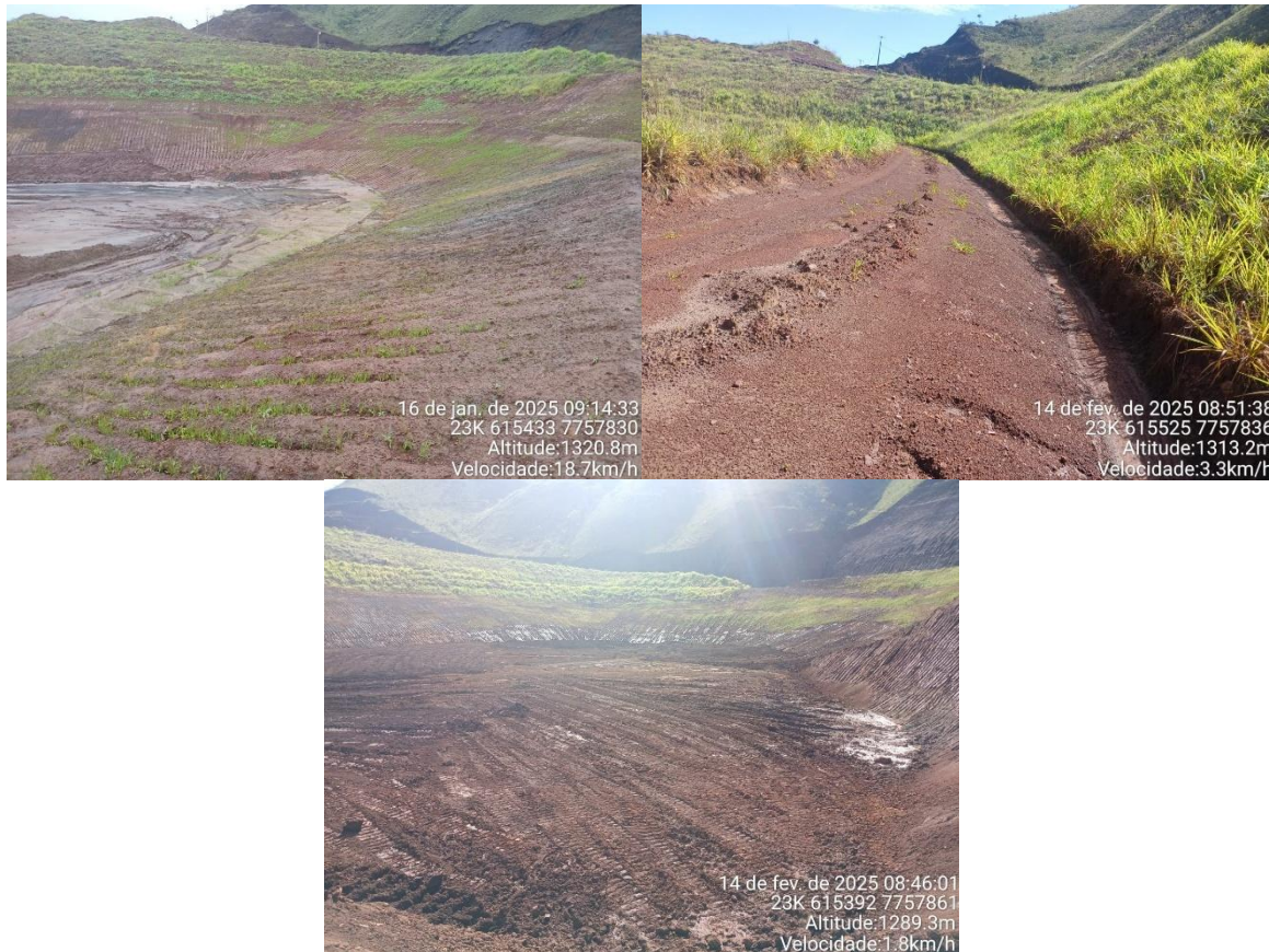
Figura 7: Situação da estrutura durante o período referente a este relatório.
