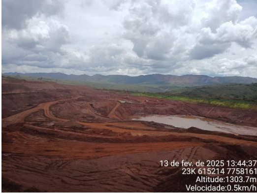
Figura 6-43: Condições da antiga cava laninha, atual expansão da cava do dique.
