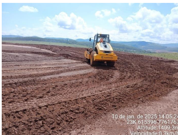
Foto 24: correção de trinca em berma da praça 10.
