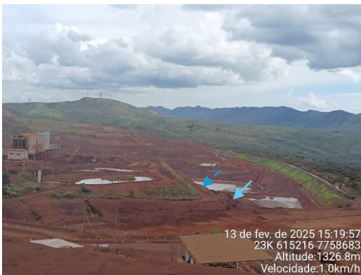
Figura 6-44:Parte da cava adjacente a usina de ITM. O local onde há tubulação é destacado por uma seta branca
