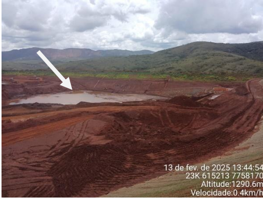
Figura 6-37: Local onde existia o dique longitudinal e atualmente é o fundo da cava do dique.
