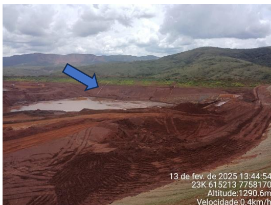
Figura 6-34: Cava do dique e tubo de drenagem (seta azul).
