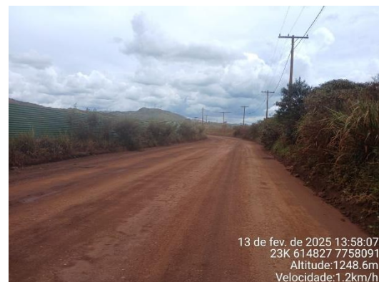
Figura 6-42: ITA-320 em boas condições
