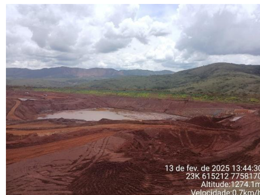
Figura 6-35: Cava do dique.
