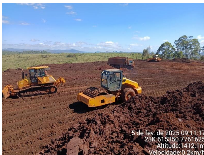
Foto 07: bota-espera na Praça 08 com material proveniente da barragem e rejeito filtrado.
