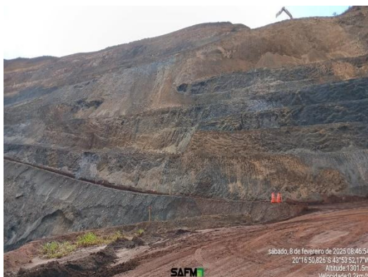
Figura 6-33: Fundo da cava sul.
