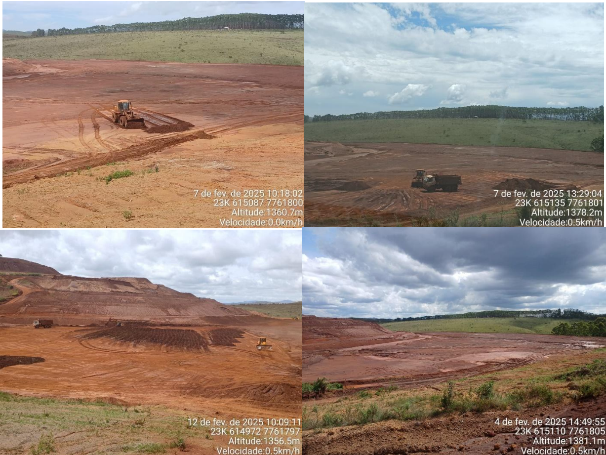
Figura 6: situação de momento da praça com controle e o início do processo de preparação para o alteamento a ser realizado na próxima estiagem.
