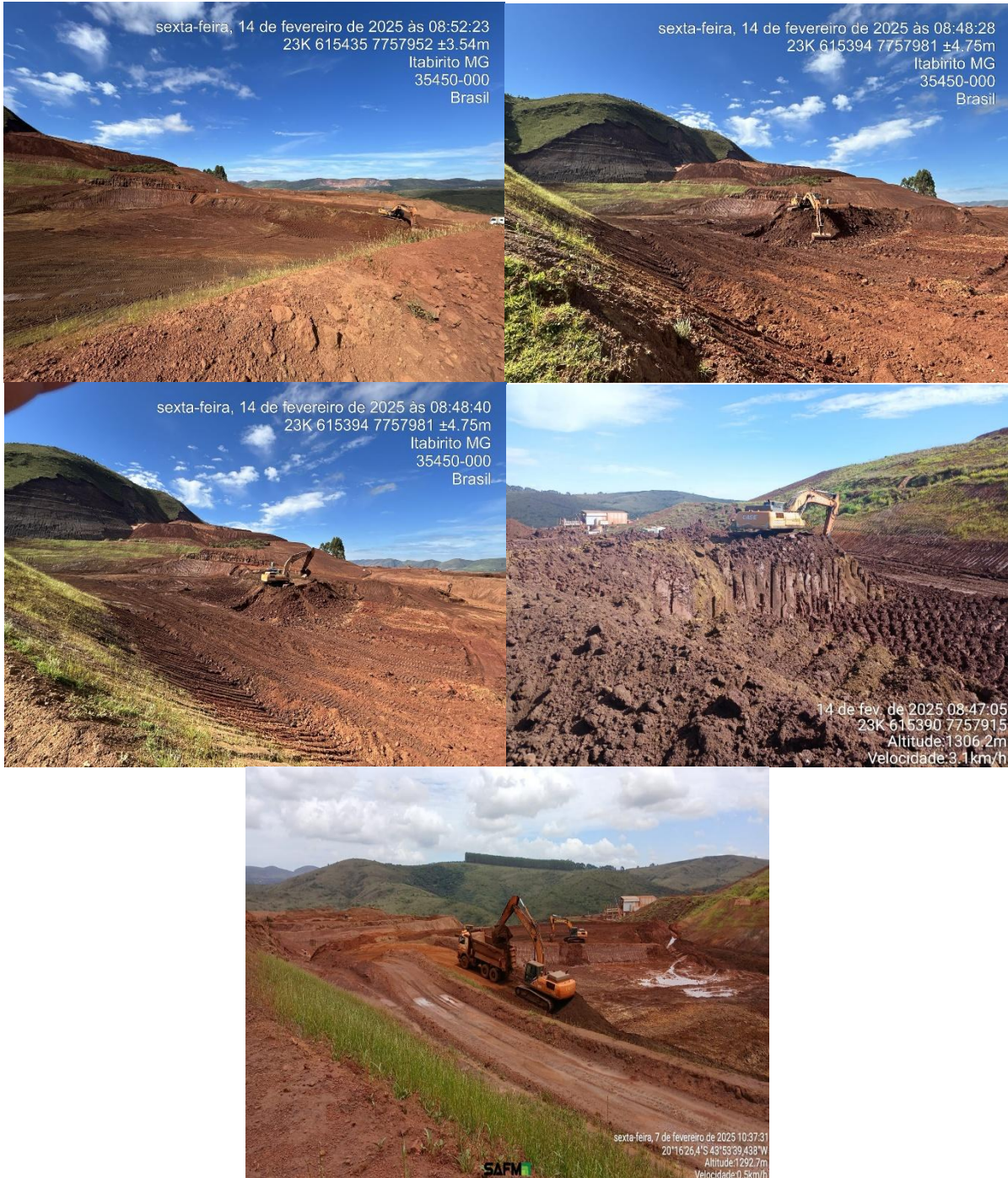
Figura 6-16: Situação geral da estrutura ao longo do trimestre.
