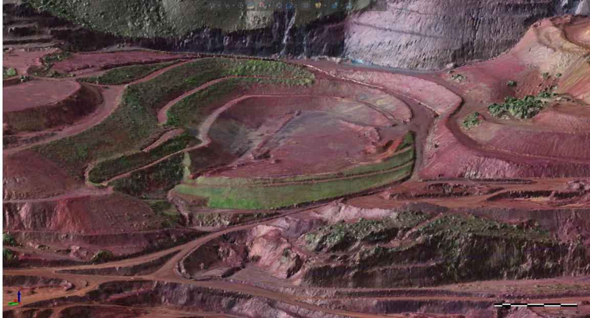
Figura 3: Situação da estrutura no final de janeiro de 2025.
