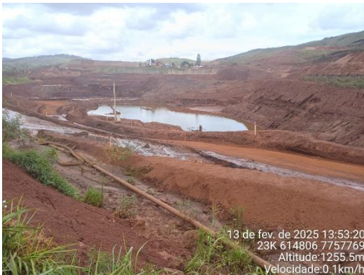
Figura 6-38: Cava do dique vista pela ITA-320.
