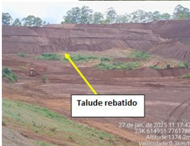
Foto 23: correção da erosão na praça 10.
