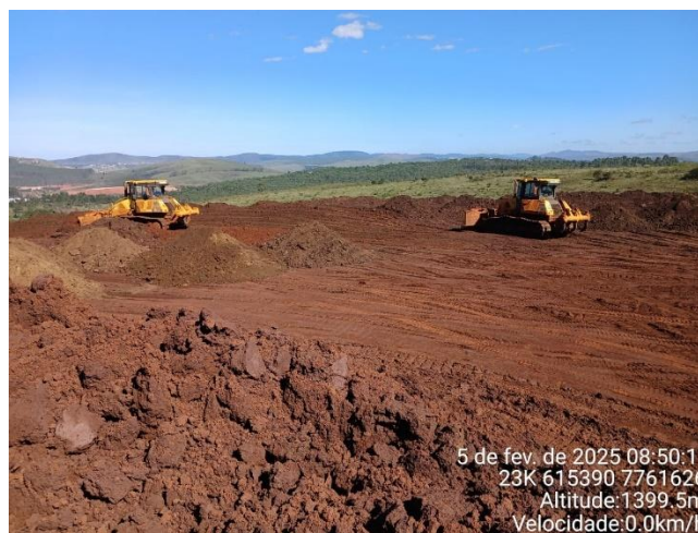
Foto 16: bota-espera na Praça 08 com material proveniente da barragem e rejeito filtrado.
