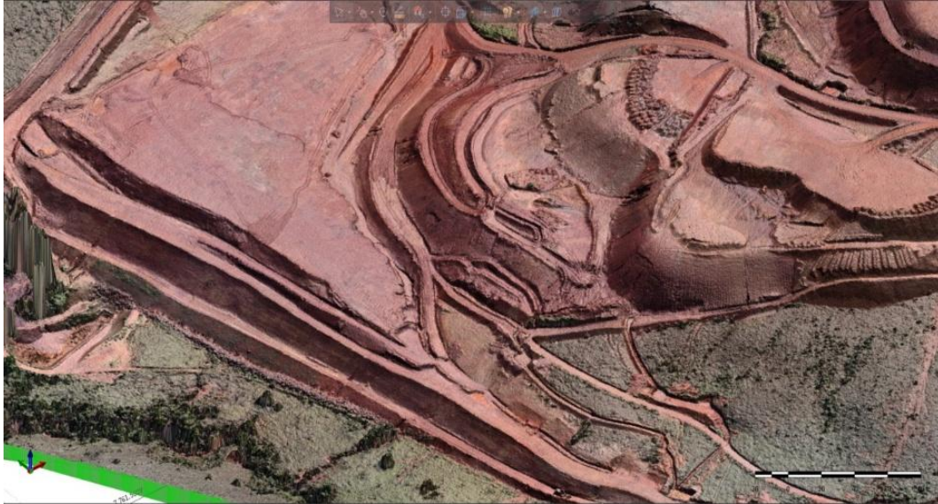
Figura 11: Taludes da deposição ascendente da pilha Noroeste. 01/12/2024.
