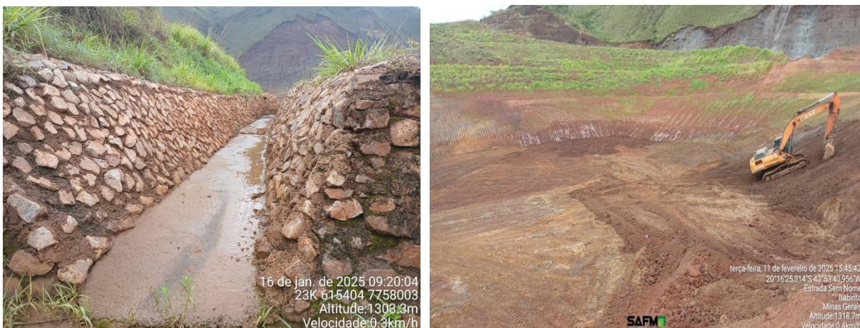
Figura 6-24: Barragem Central – condições do maciço e drenagem
