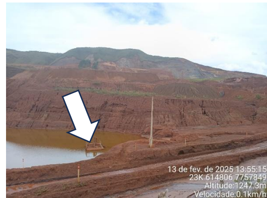
Figura 6-41: Sump (fundo da cava do dique) com a água pluvial sendo retida.
