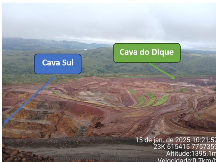
Figura 51: Duas cavas para as quais as águas pluviais são direcionadas na mina ponto
